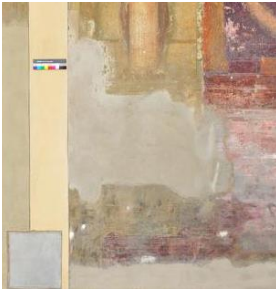
Figura 1b • Simulazione della integrazione della lacuna effettuata utilizzando il campione di intonaco fotografato contestualmente.
