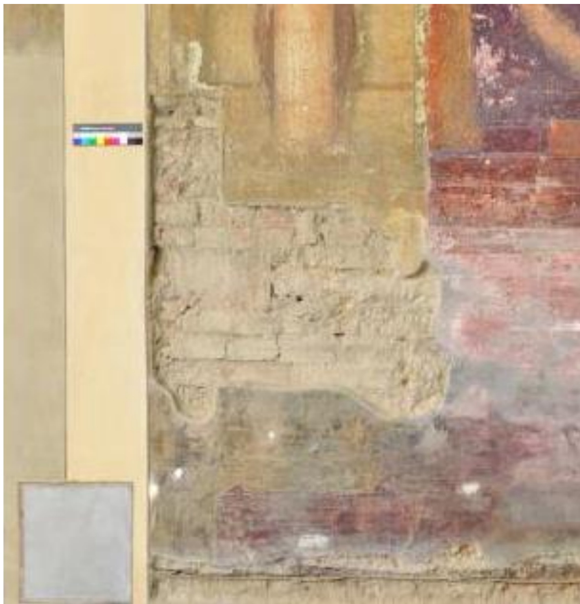
Figura 1a • Lacuna in un dipinto murale. Accanto alla lacuna è visibile il campione di intonaco con il quale si intende elaborare la simulazione.
