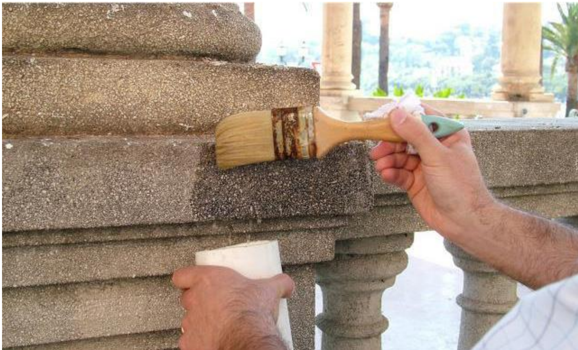
Figura 6 • Fase di esecuzione della pulizia di un basamento in pietra artificiale.
