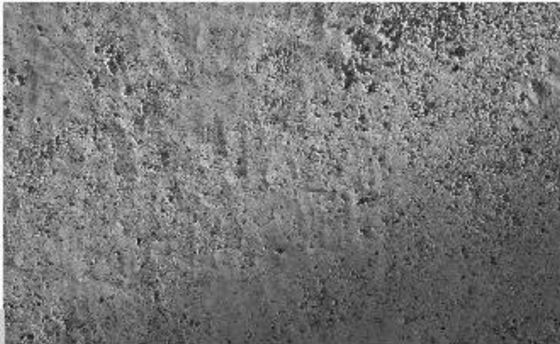
Figura 4 • Presa analoga a quella della fig. 2, ma su una superficie intonacata. Le ombre create dalla luce radente (solare) evidenziano le leggere ondulazioni della superficie apparentemente liscia.
