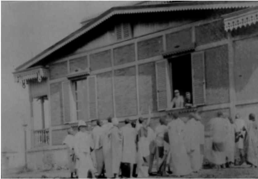
3. Asmara. Antica palazzina del Comando, ca. 1893-95.
