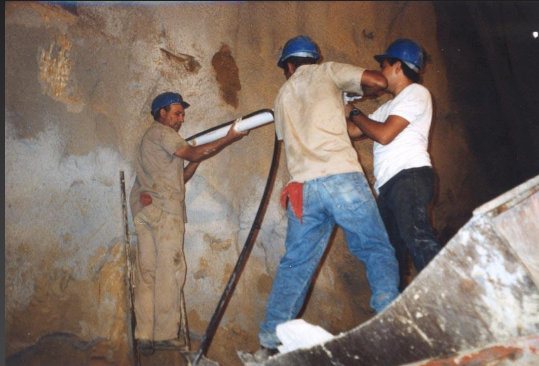
Installazione tubazione estensimetrica incrementale su fronte scavo
