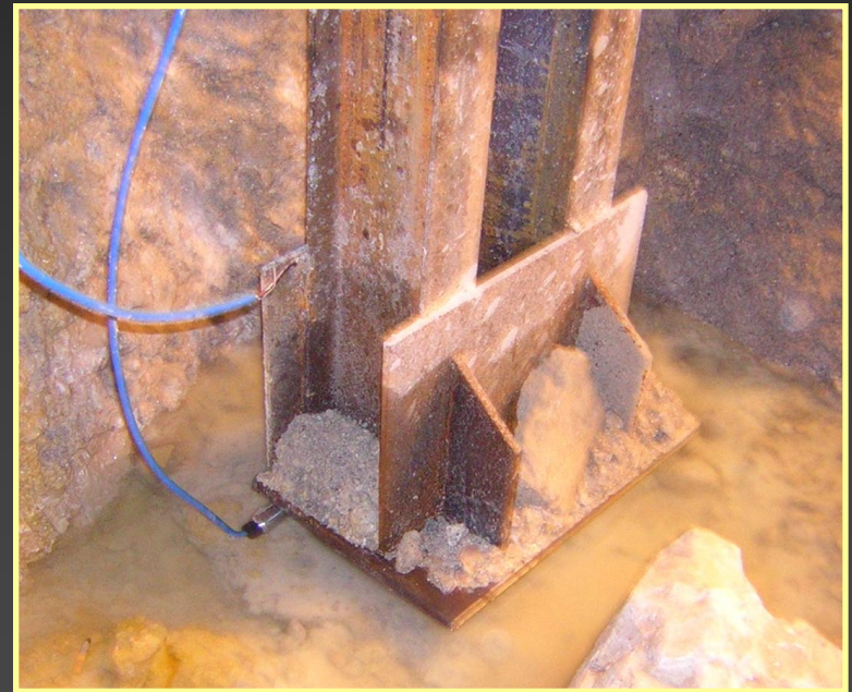
Cella di carico al piede della centina
