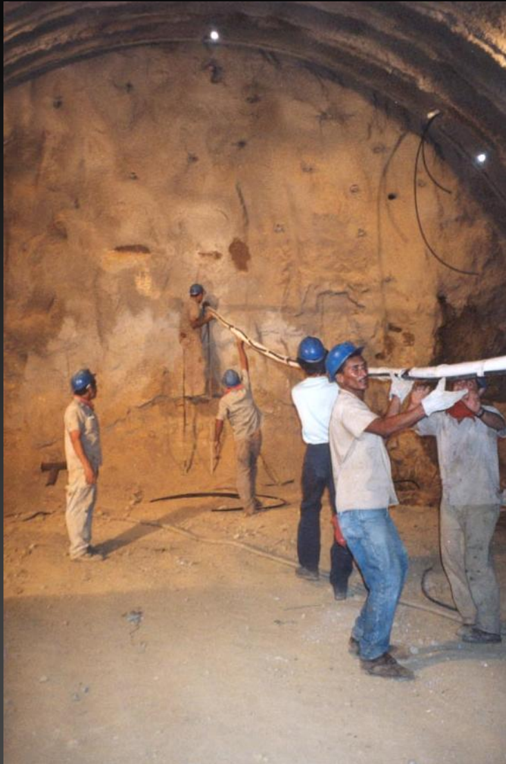
Installazione tubazione estensimetrica incrementale su fronte scavo
