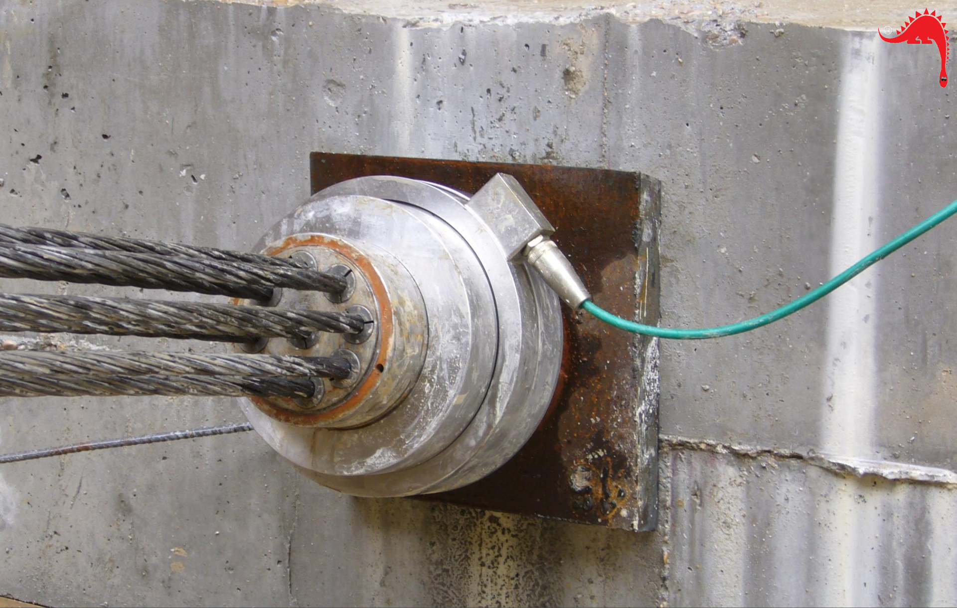
Cella di carico elettrica per tiranti montata su berlinese
