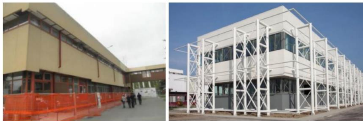
Fig. 25 – Esempio di impiego di esoscheletri nell'adeguamento sismico di un edificio esistente
