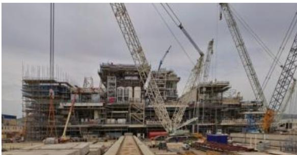
Figura 5 - Topside in fase di costruzione
