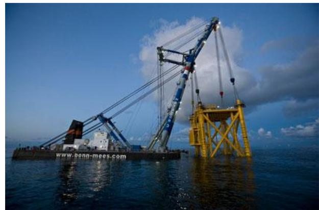
Figura 10 - Varo con crane barge
