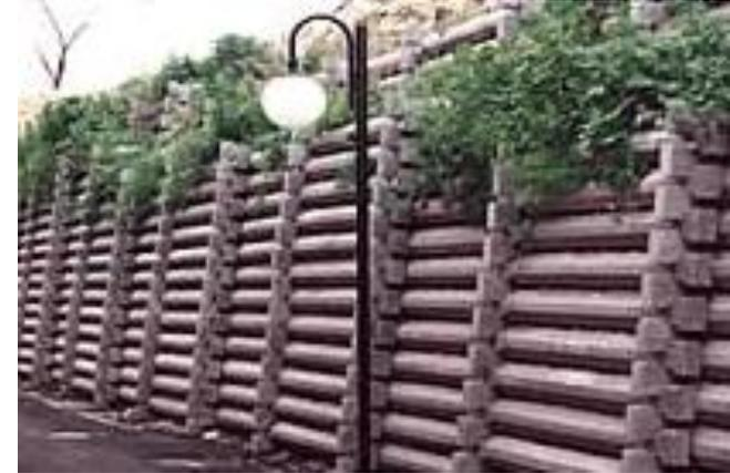
Per contenere e consolidare le scarpate si possono utilizzare anche le *graticciate* (graticci di legno di bloccaggio della terra inerbati).
