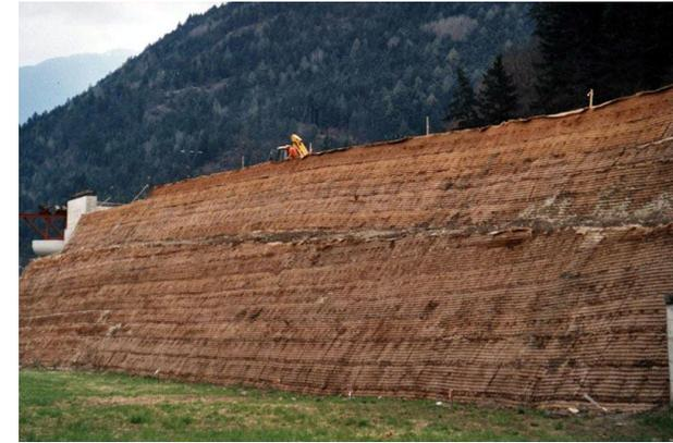
Le caratteristiche della terra rinforzata/armata **dipendono** dalla interazione tra il materiale di rinforzo e la terra a contatto, interazione che è legata alle caratteristiche dei materiali impiegati (terra e rinforzo) e alle modalità costruttive.
