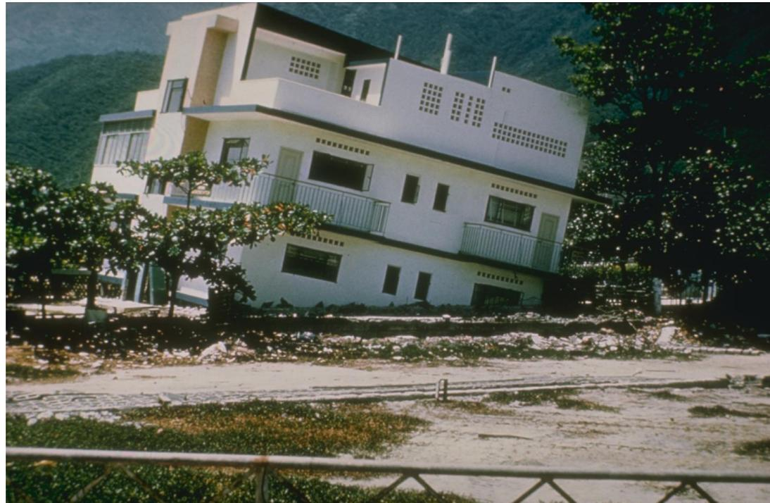
**I FENOMENI DI LIQUEFAZIONE avvengono in ben DETERMINATI CONTESTI GEOLOGICI E IDROGEOLOGICI, innanzitutto in depositi di sabbie e limi più o meno sabbiosi interessati da livelli della falda piuttosto alti (falda superficiale). Suoli di più recente deposizione, sciolti, in presenza di falda a pochi metri di profondità o addirittura al piano campagna, sono particolarmente suscettibili di liquefazione.**
