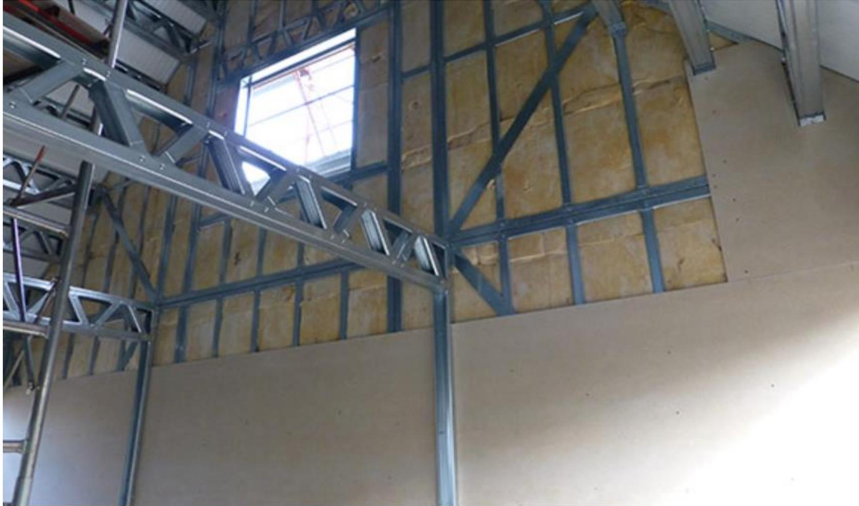
*Vista di un sistema costruttivo in profili sottili formati a freddo - foto: Cogi srl*
