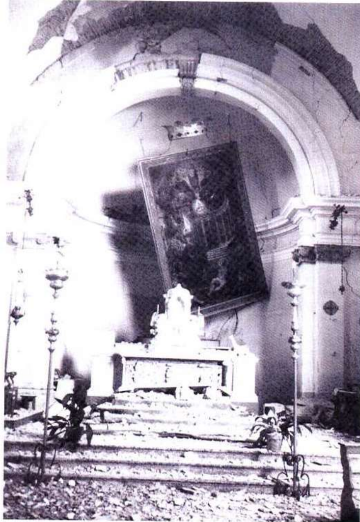
Danni alla chiesetta di Buia dovuti al terremoto del Friuli 1976
