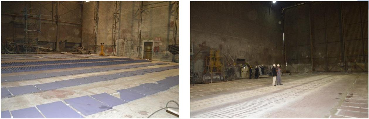
Figura 153 Pitturazione di elementi di paiolato. Manufatti predisposti per la pitturazione (sinistra) e relativi depositi di vernice (destra)
