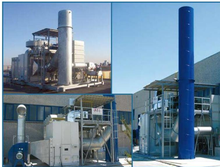
Figura 110 Impianti di abbattimento con rotoconcentratore
