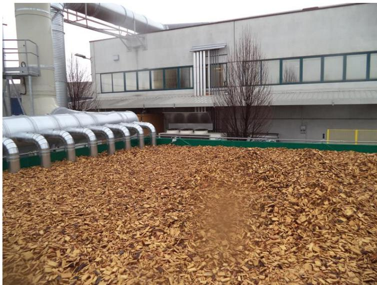
Figura 112 Biofiltro per trattamento COV da verniciatura
