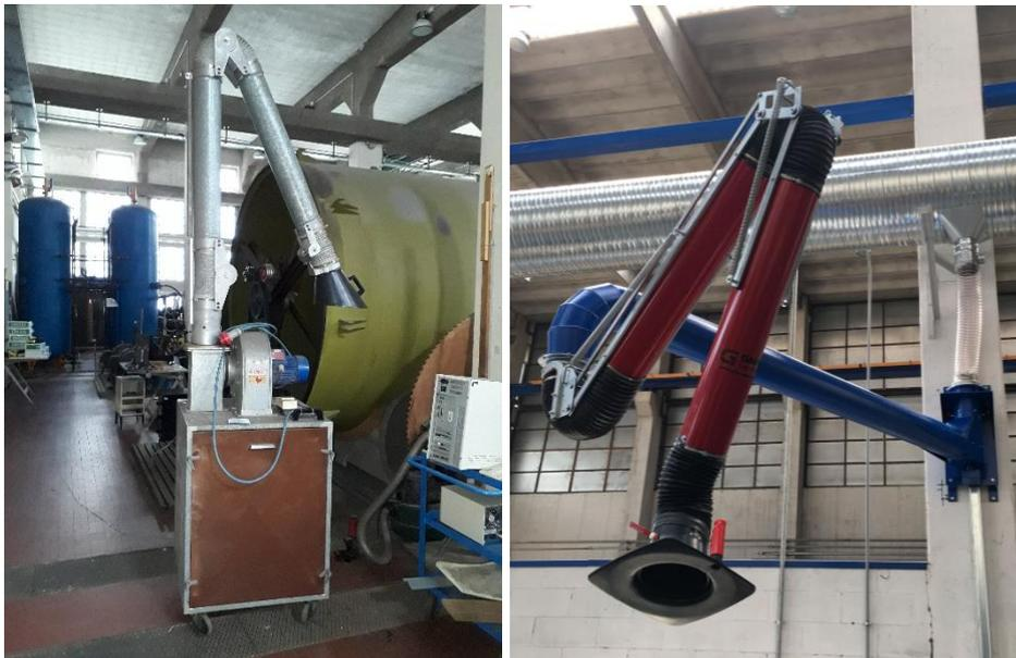
*Figura 117 Cappa mobile: soluzione portatile e collegamento ad impianto centralizzato*
