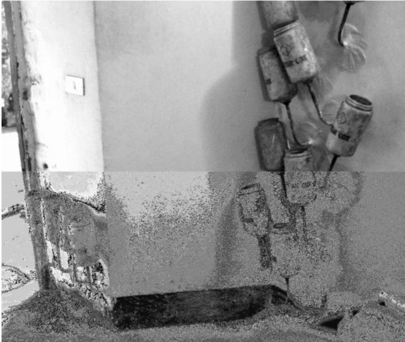
Figura 7 • Iniezioni a lenta diffusione. Esecuzione di una barriera verticale accostata a una orizzontale, eseguita se il muro su cui è realizzata la barriera è accostato a una parete non soggetta a intervento di deumidificazione.
