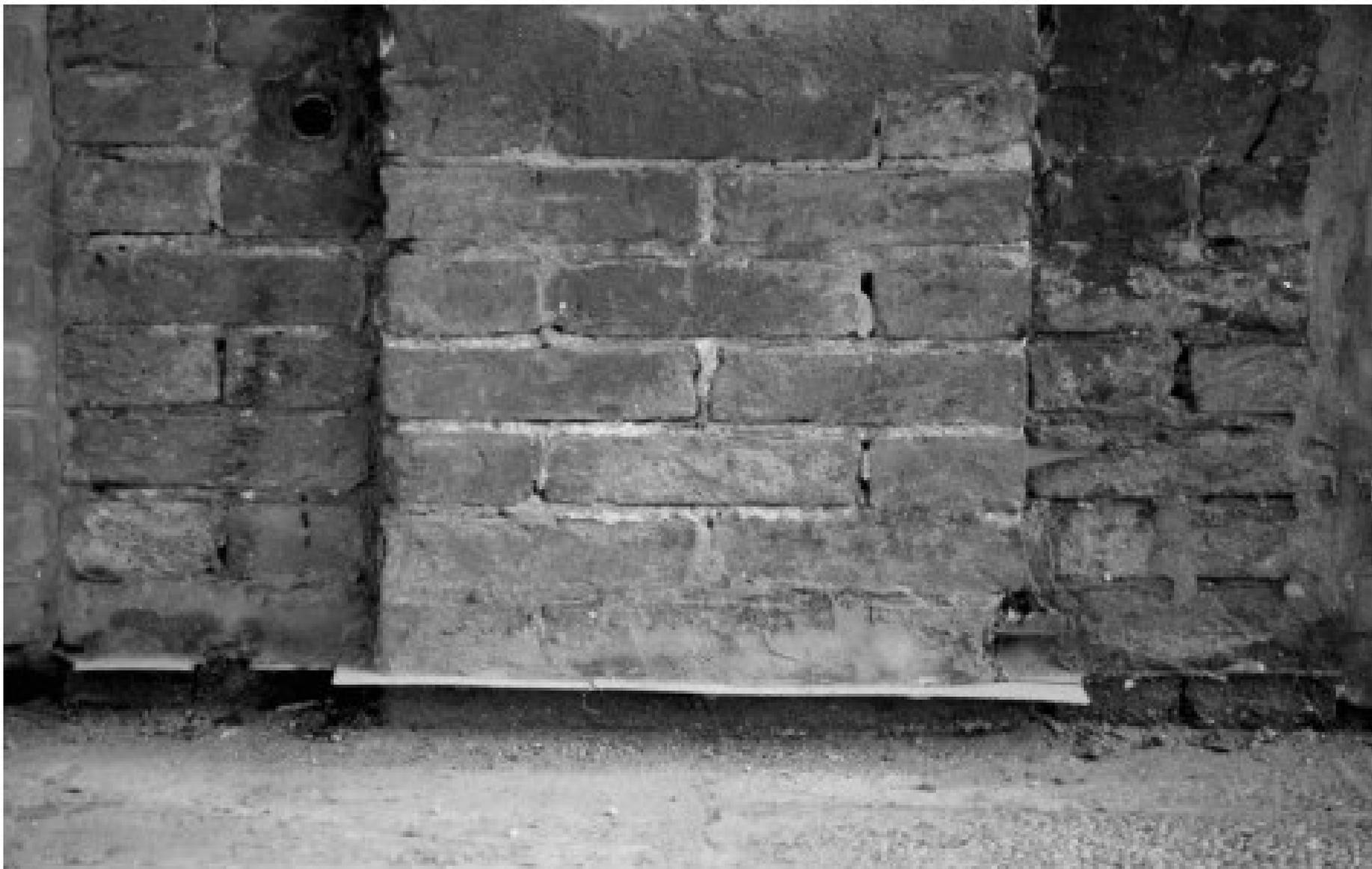
Figura 1 • Taglio meccanico della muratura: barriera con fogli di materiali impermeabili. Inserimento dei fogli impermeabili, dimensionati in modo da prevedere la loro sporgenza dal filo del muro per almeno 2 cm (per creare la barriera anche nello strato di finitura esterno della parete).
