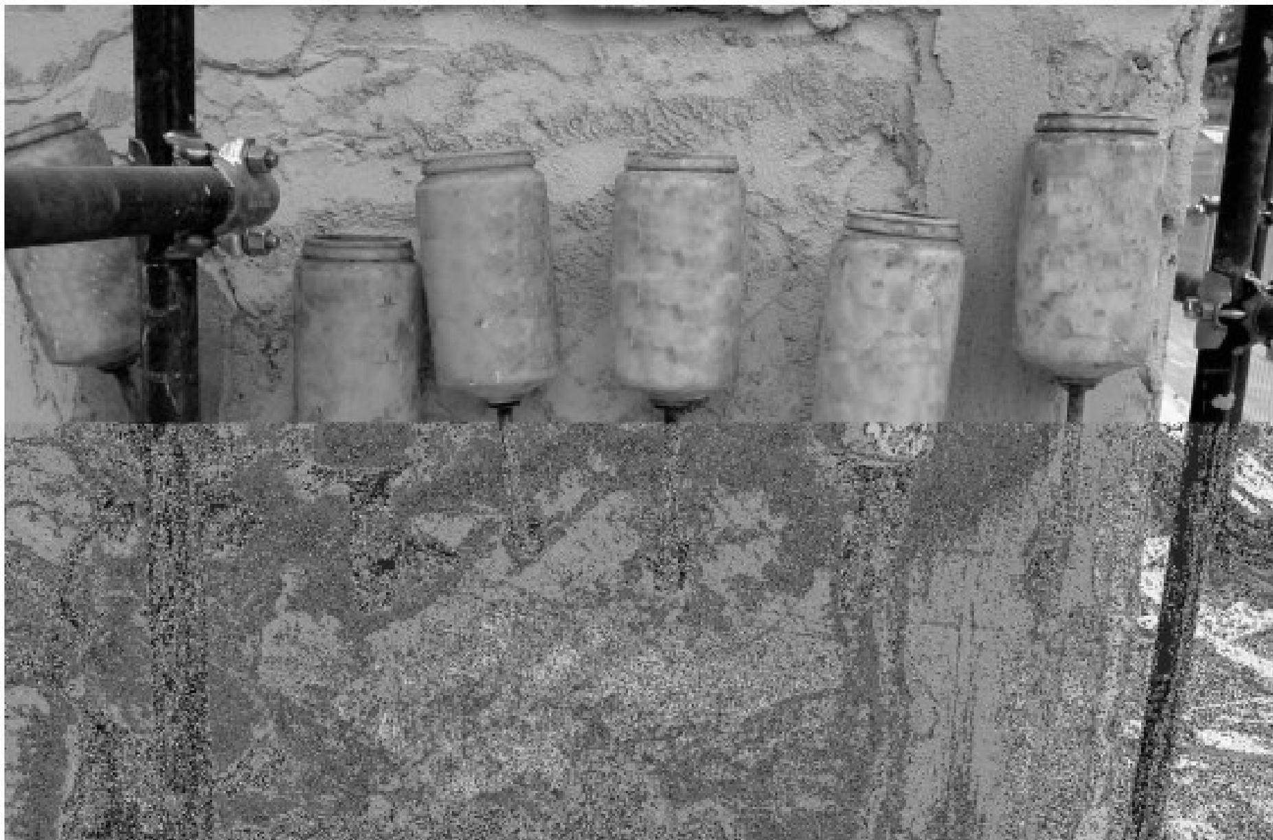
Figura 6 • Iniezioni a lenta diffusione. Trasfusori inseriti nella muratura e stuccatura dei bordi per evitare dispersione di liquido.
