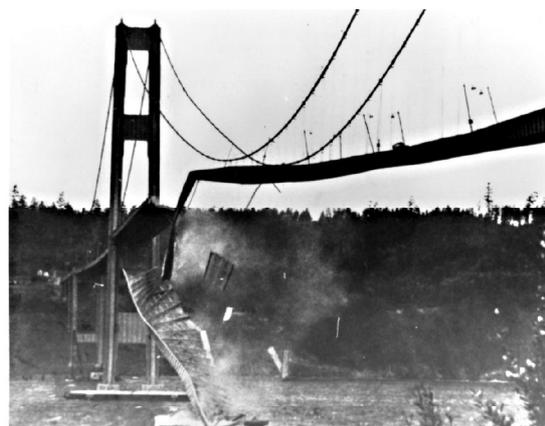
Il crollo del ponte avvenne alcune ore dopo che il processo vibrazionale si era instaurato indotto da un [vento praticamente costante](#) dell'ordine di 65 Km/h e in assenza di raffiche forti ed improvvise. La velocità del vento, di entità ben inferiore a quella prevista in fase di progetto, indusse nella campata centrale oscillazioni torsionali di ampiezza inesorabilmente crescente.
