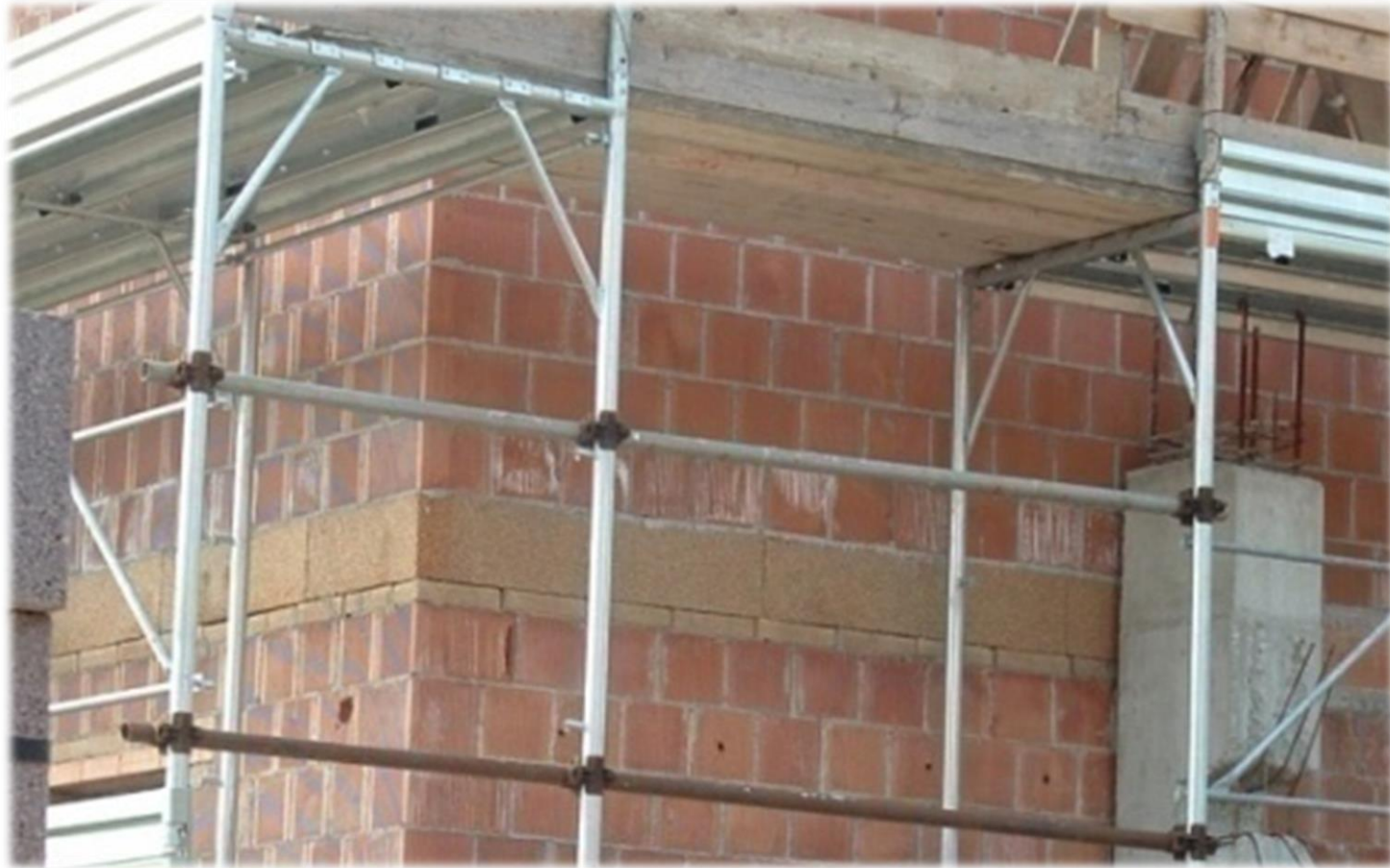
Striscia perimetrale per la correzione del ponte termico solaio – parete perimetrale
