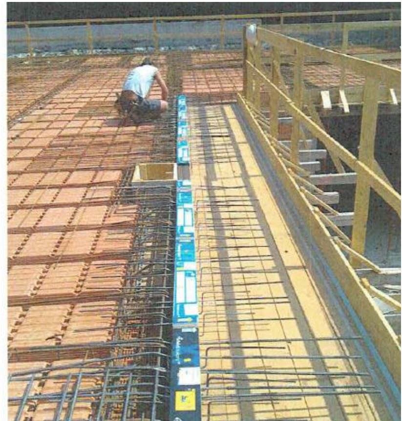
A destra, struttura provvisoria per il getto della soletta a sbalzo, con tavola di chiusura.
