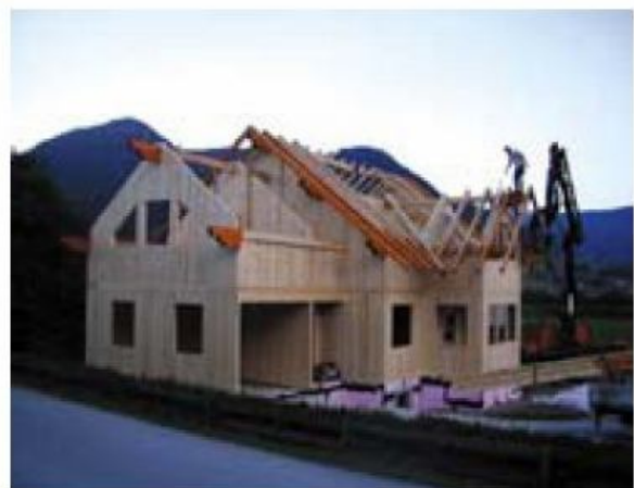
Abitazione unifamiliare – Wörschach (A)
