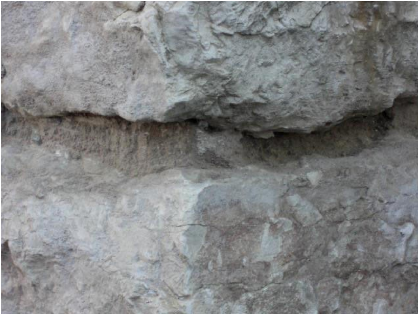
Figura 16a • Fasciatura inserita nei giunti di malta. Scarnitura e pulizia del giunto previo arrotondamento dello spigolo.
