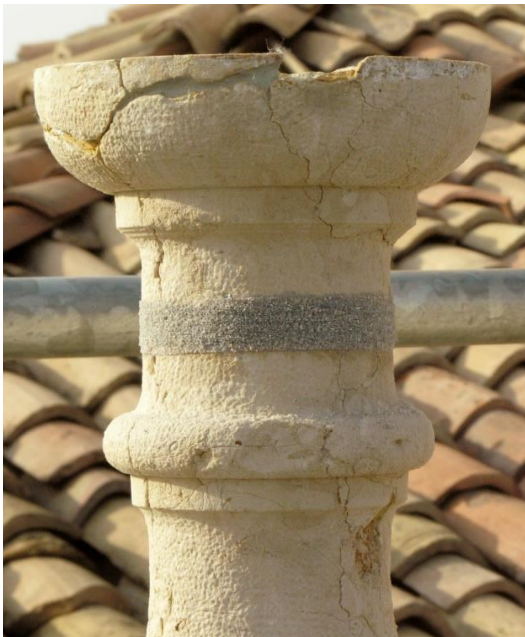
Figura 13 • Nastro di altezza ridotta in fibra di carbonio prima della stesura della malta di finitura.
