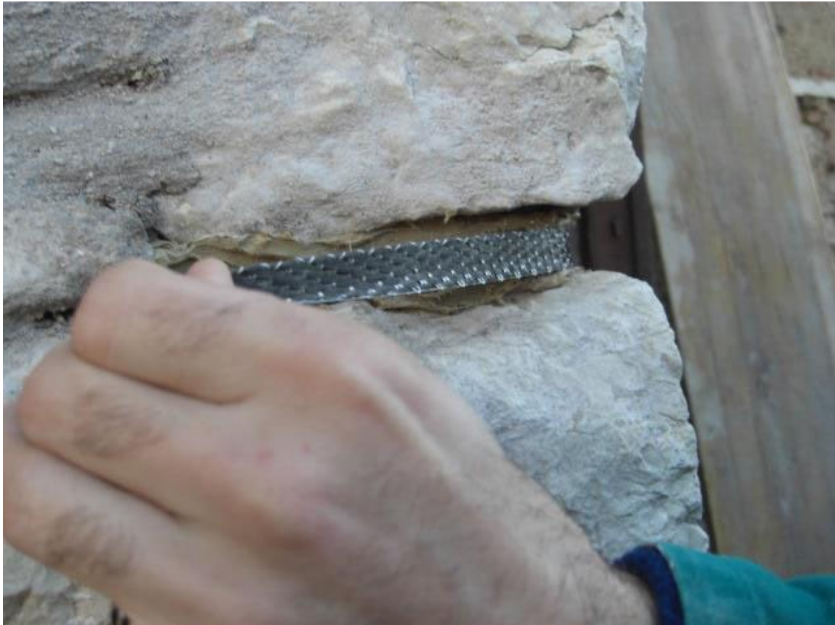
Figura 16c • Fasciatura inserita nei giunti di malta. Applicazione del nastro in fibra di carbonio (1,5 cm).
