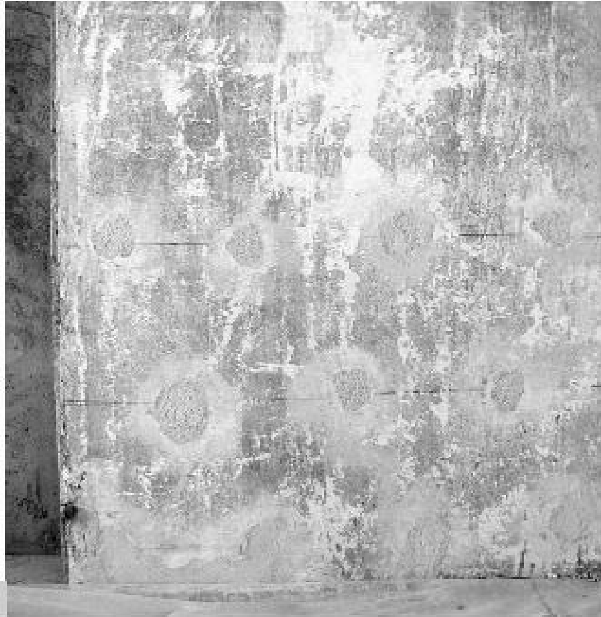
Figura 10 • Stuccatura dei fori di iniezione.
