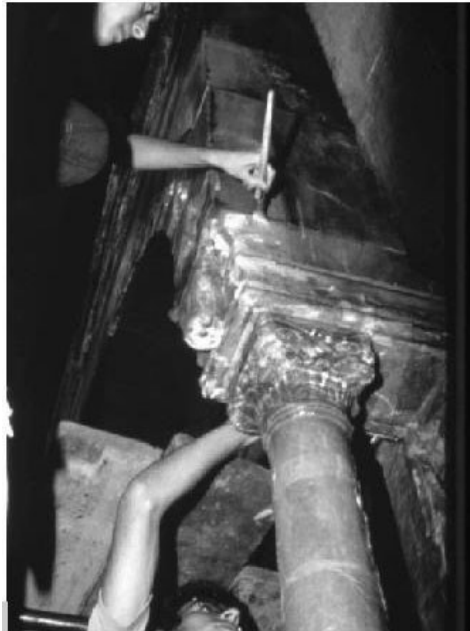
Figura 3 • Applicazione della velinatura.
