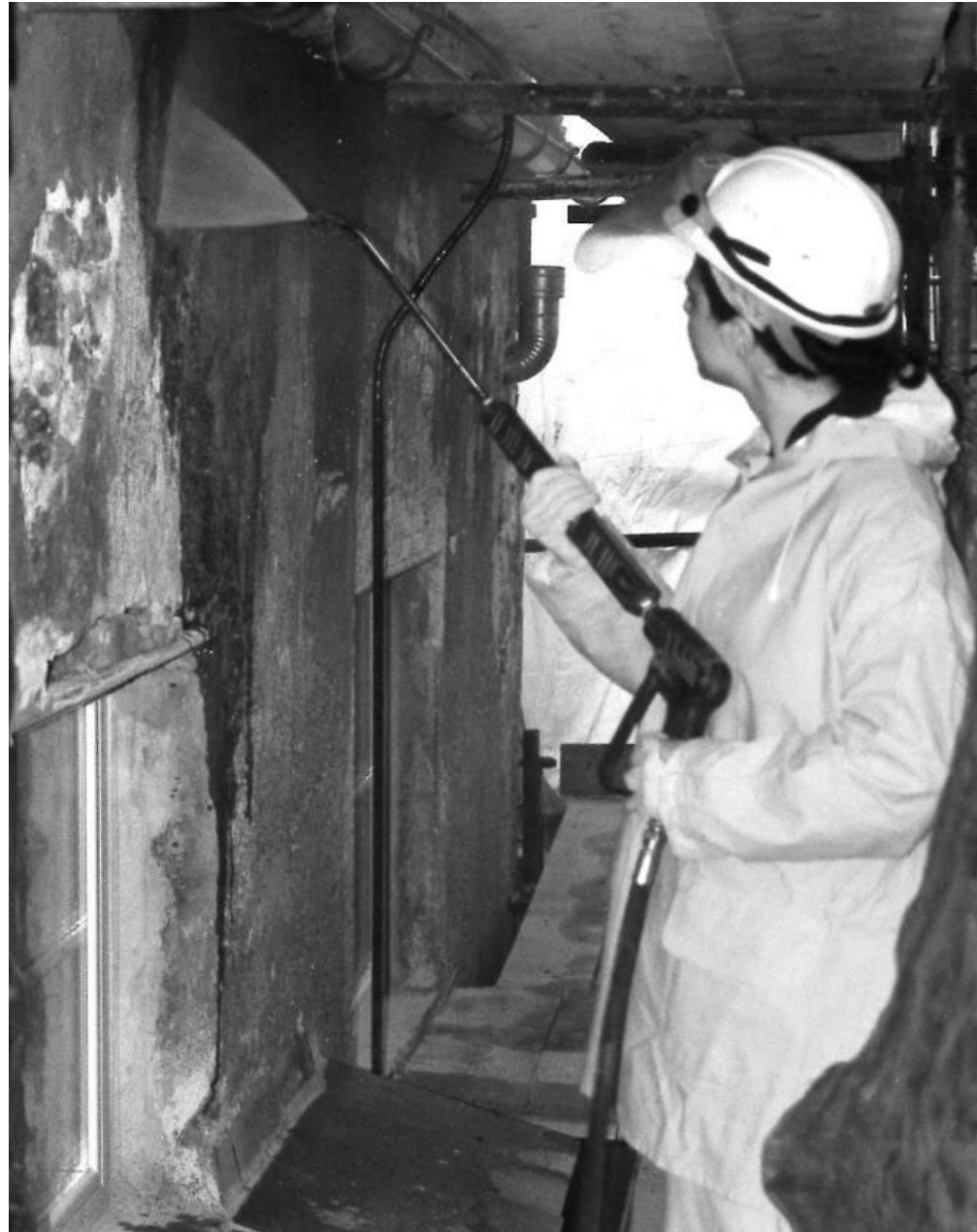
Figura 11 • Operatore durante il consolidamento.
