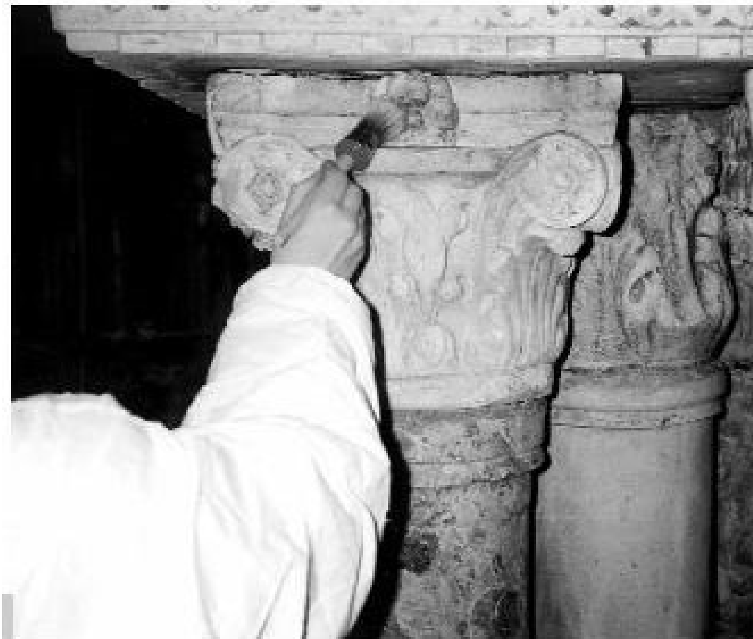
Figura 12 • Addetto durante l'operazione di stesura del prodotto impregnante.
