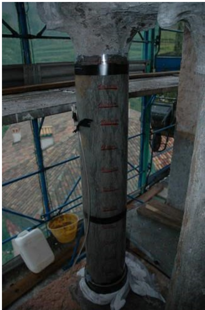
Figura 3 • Impregnazione a tasche di colonna in pietra con silicato di etile.
