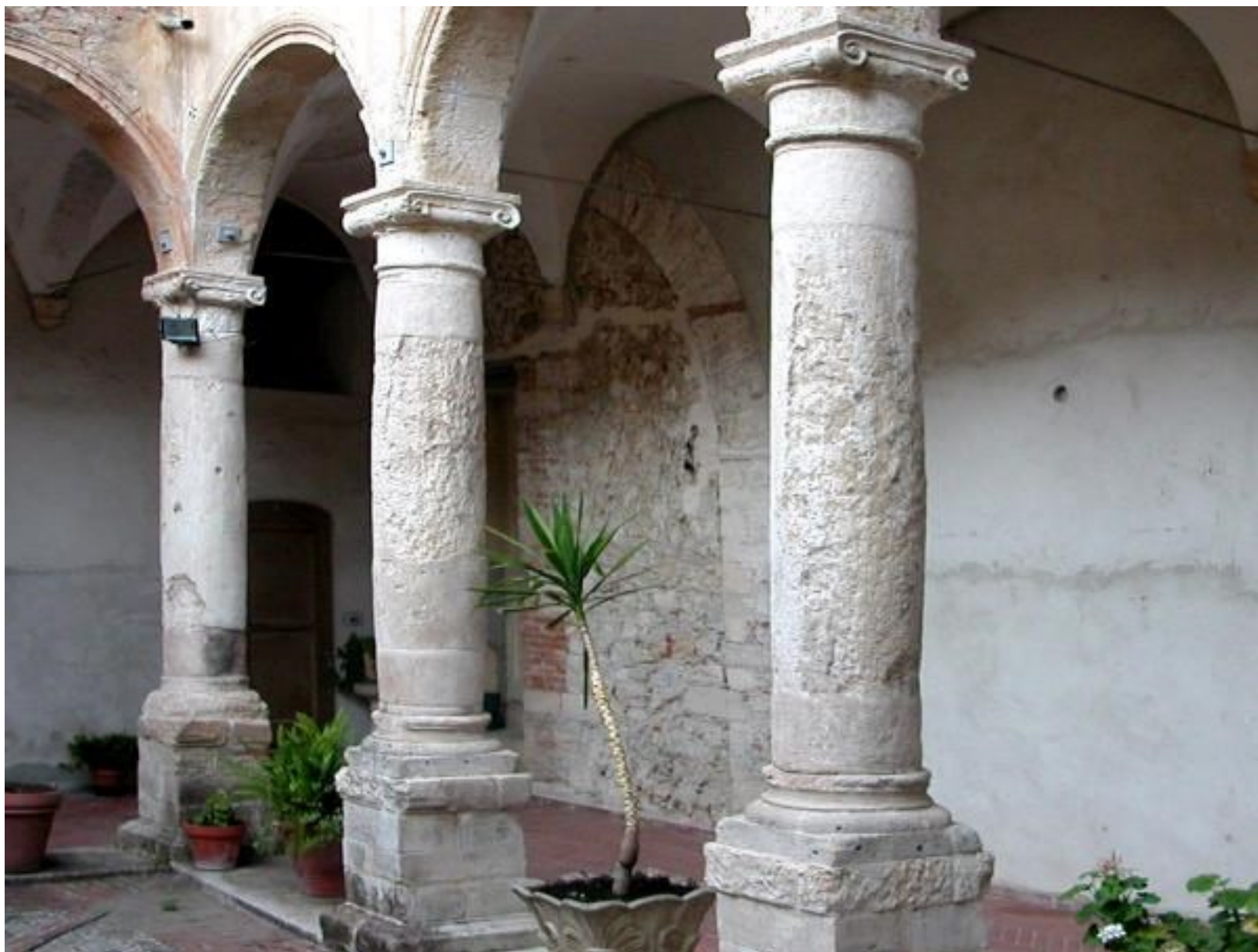
Figura 11 • Fasciature con nastri in fibra di carbonio applicate alla base e alla sommità del fusto delle colonne.
