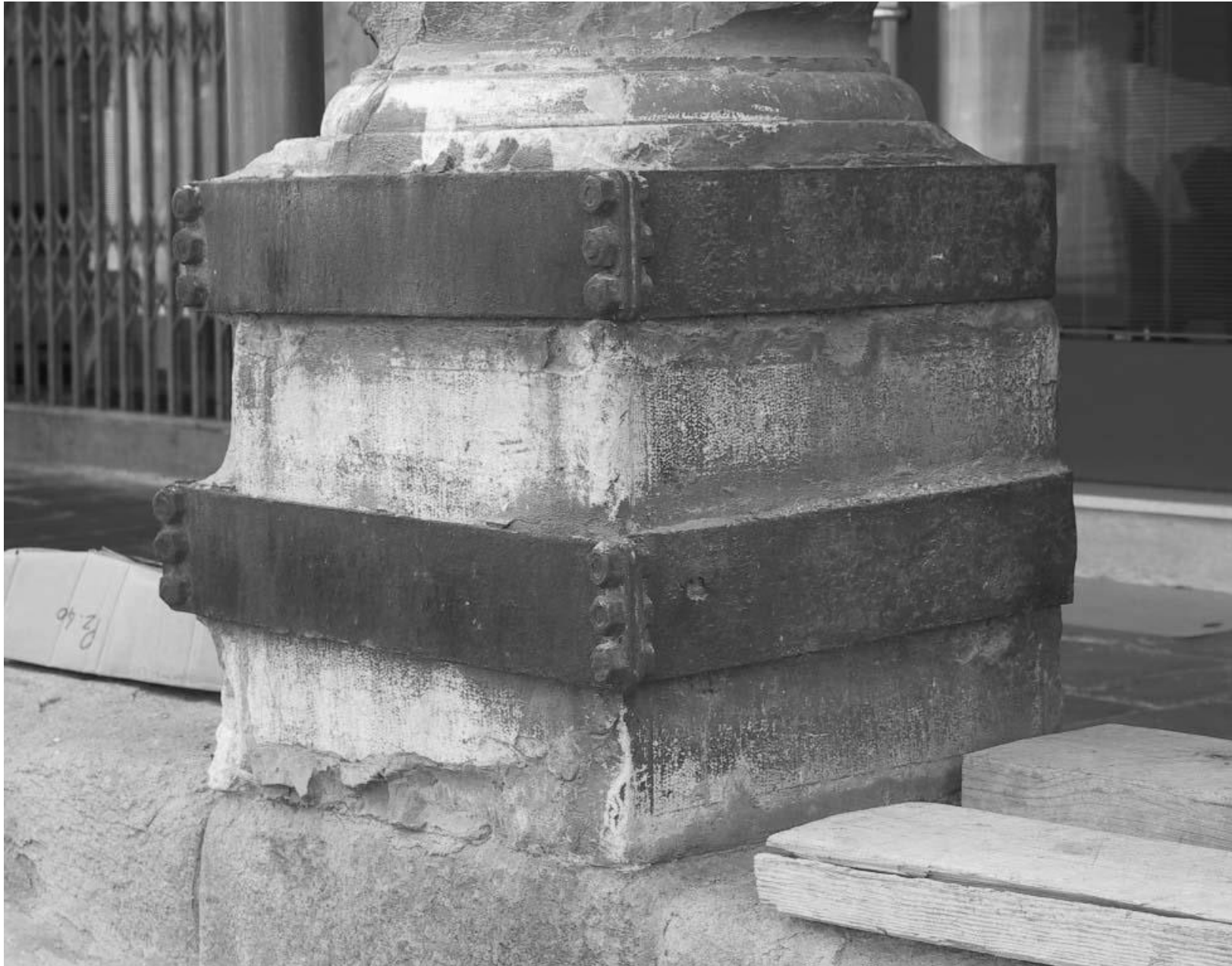
Figura 6 • Pesanti cerchiature al piedistallo di una colonna.
