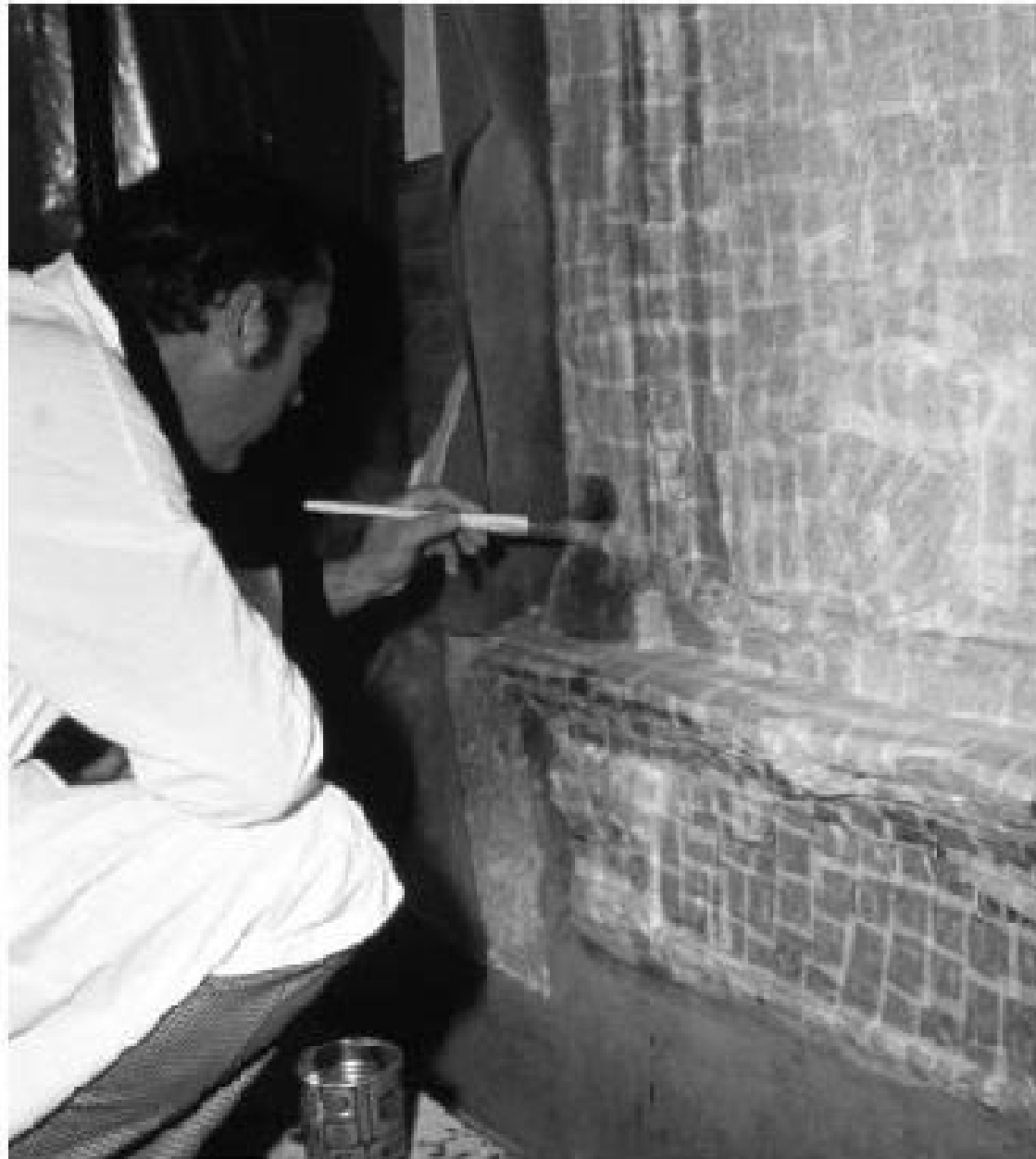
Figura 4 • Applicazione del consolidante sulla superficie precedentemente protetta.
