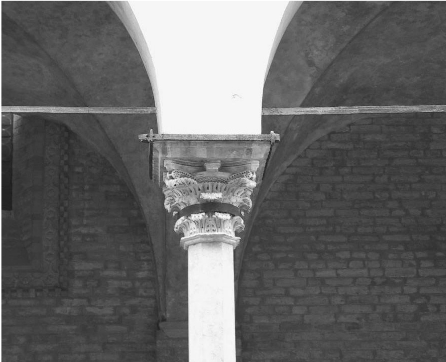
Figura 1 • Cerchiatura del capitello e del pulvino.
