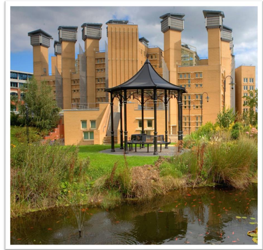
Un esempio contemporaneo (2008) di wind-catching con torri di ventilazione (Lancaster Library, Coventry University).
