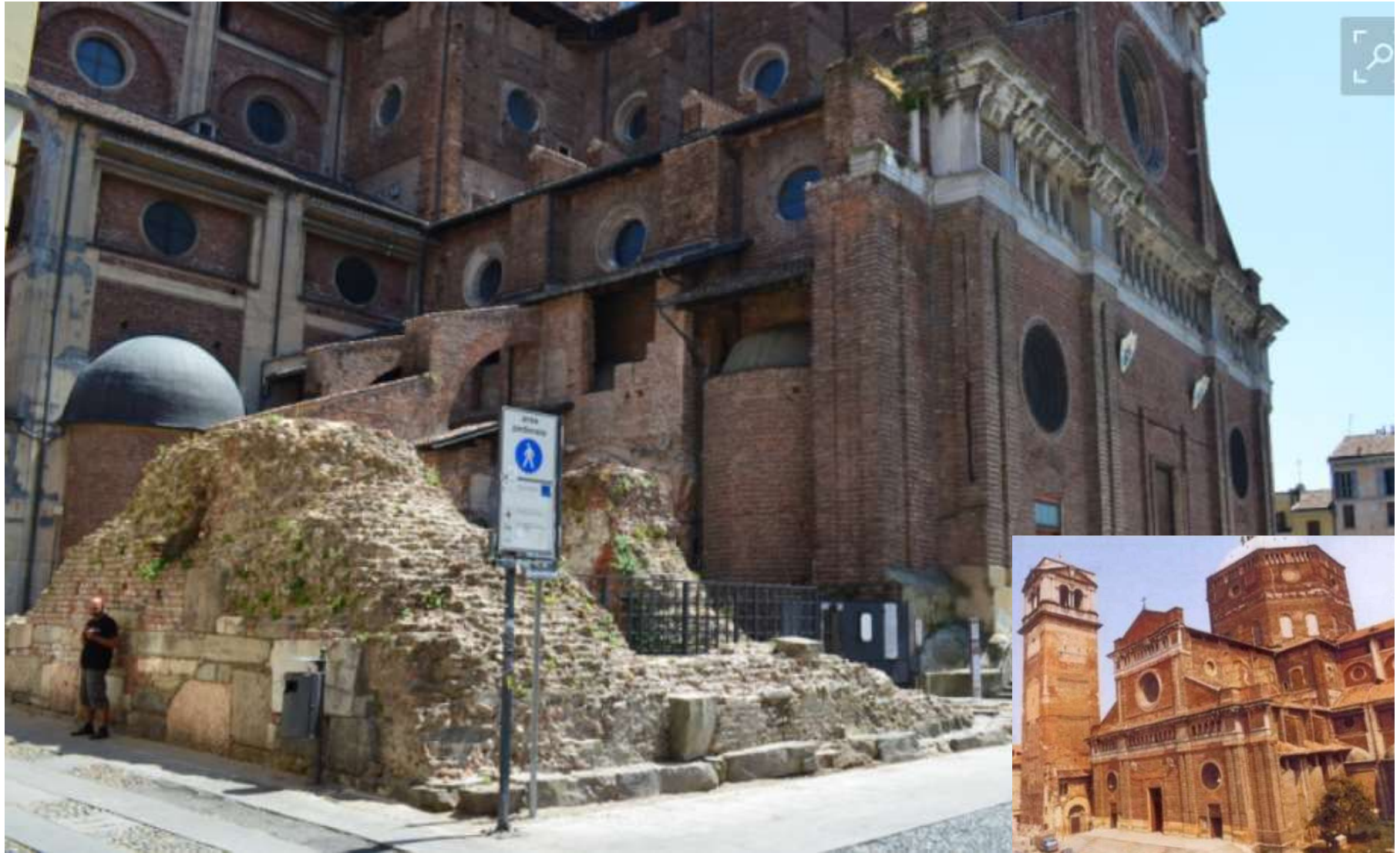
Crollo Torre Civica (marzo 1989)
