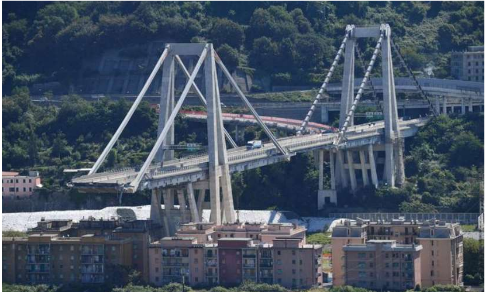
Viadotto sul Polcevera – Genova (ago. 2018)
