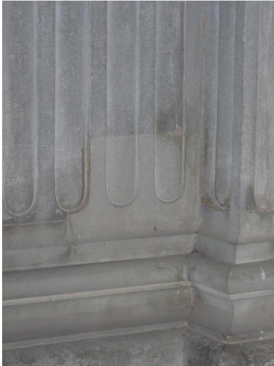
Figura 8 • Tasselli realizzati con stesse forme e materiale delle parti da sostituire. Firenze, Cappella Pazzi, base di parasta.
