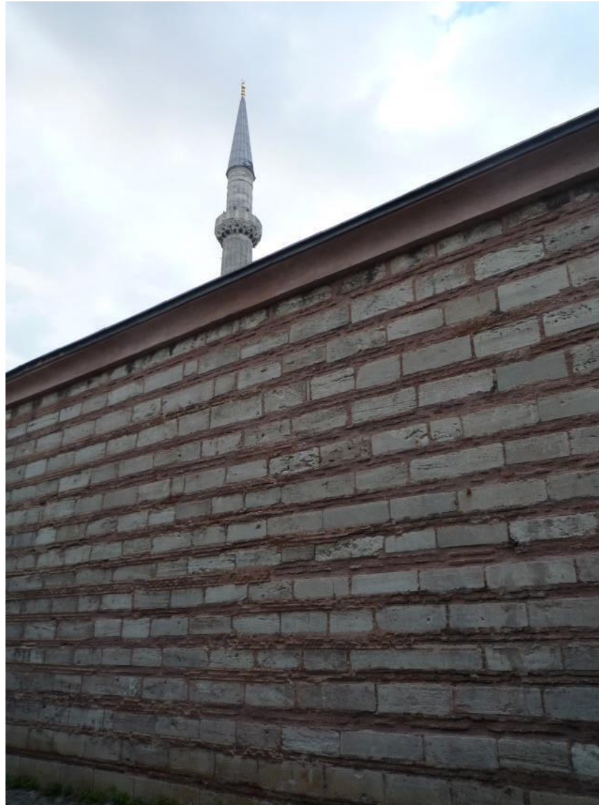
Figura 4 • Istanbul, muro di cinta della Basilica di Santa Sofia: parete sulla quale è stata applicata la tecnica del cuci-scuci, mantenendo uguali materiali, forme, dimensioni e apparecchiature con un risultato altamente mimetico.
