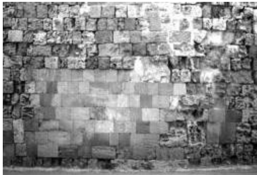
Figura 6 • Parete sulla quale è stata applicata la tecnica del cuci -scuci, mantenendo la nuova muratura a un livello di paramento arretrato rispetto a quello preesistente.
