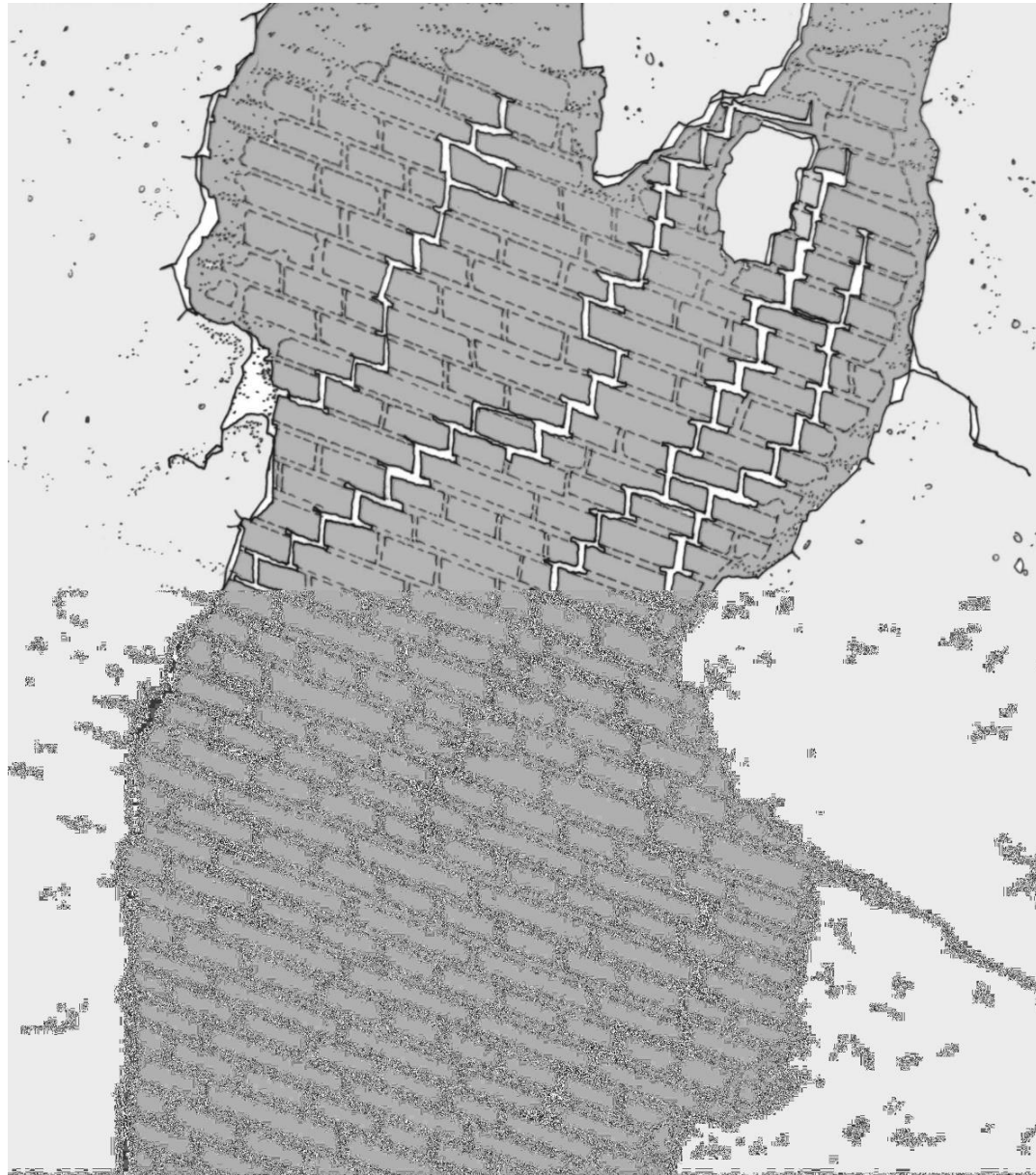
Figura 1 • In alcuni casi, la muratura da integrare non è ancora caduta, ma è conservata in situ, anche se in condizioni precarie tali da non poter essere riparata o consolidata e va completamente rimossa e sostituita.
