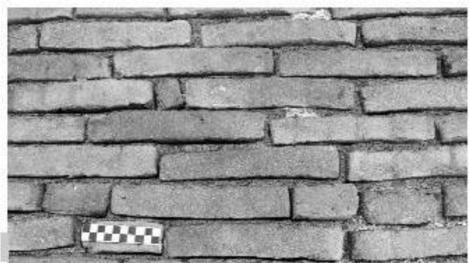
Figura 1 • Risarcitura dei giunti eseguita sottofilo.
