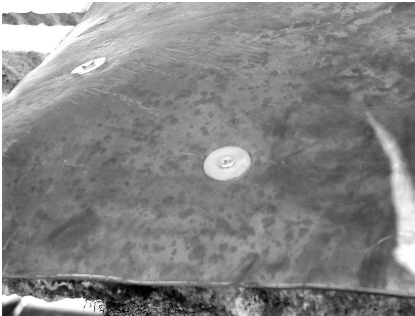
Figura 18 • Fissaggio di un foglio di piombo di grandi dimensioni con viti a espansione.
