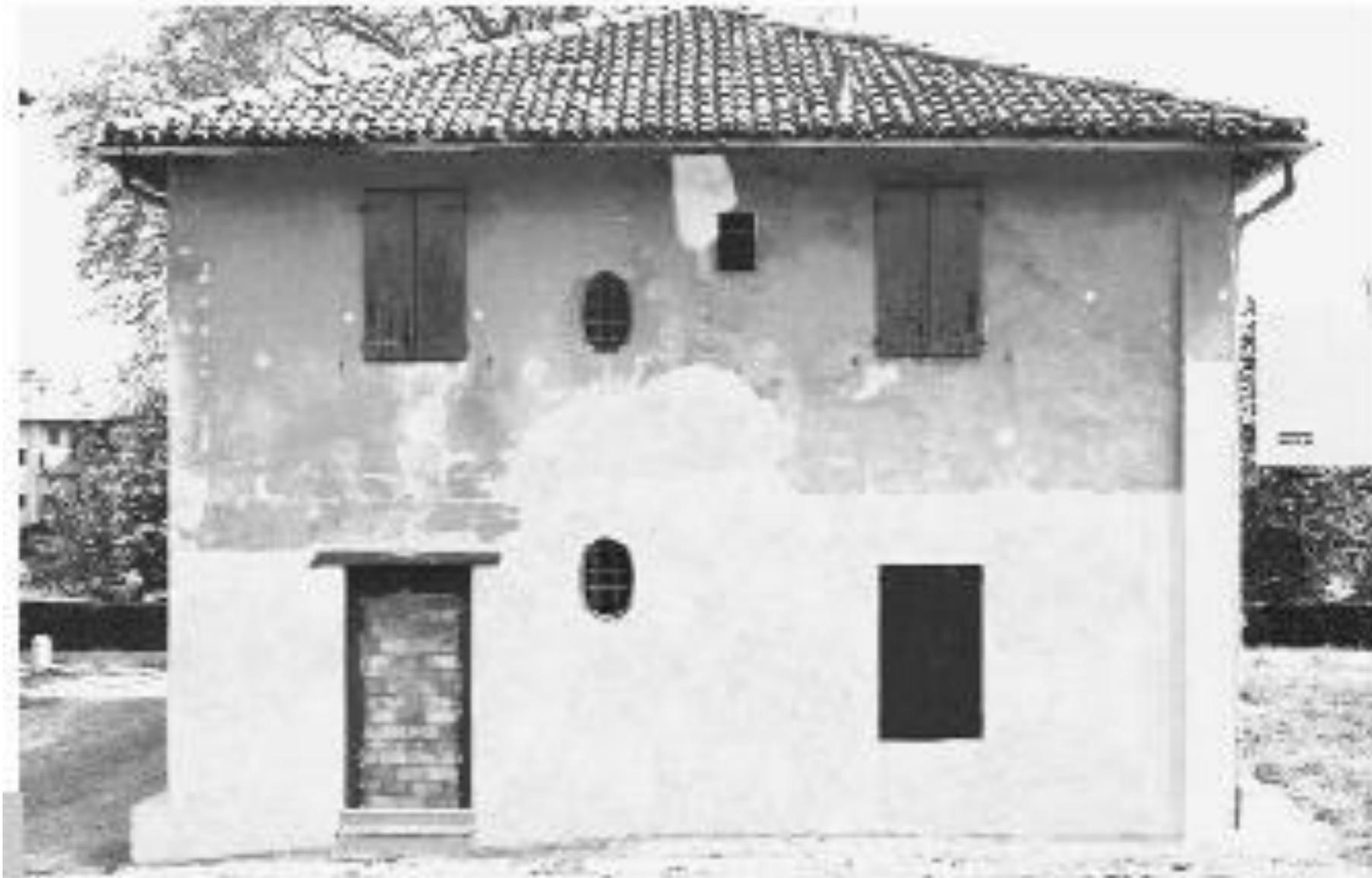
Figura 1 • Rappezi di varia dimensione e nuova stesura di intonaco nella parte basamentale della facciata.
