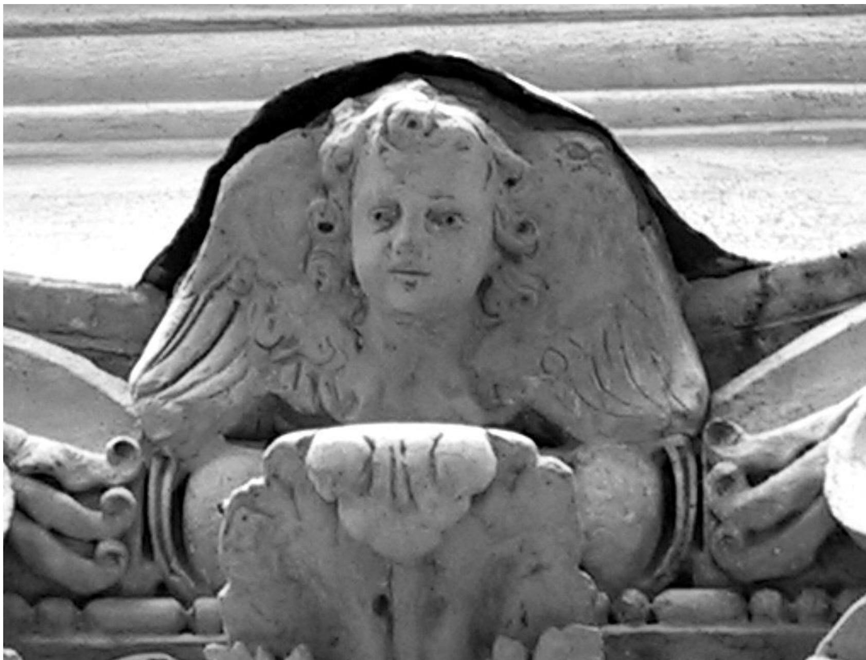
Figura 21 • Protezione di un elemento figurativo in stucco per mezzo di una copertina di piombo.
