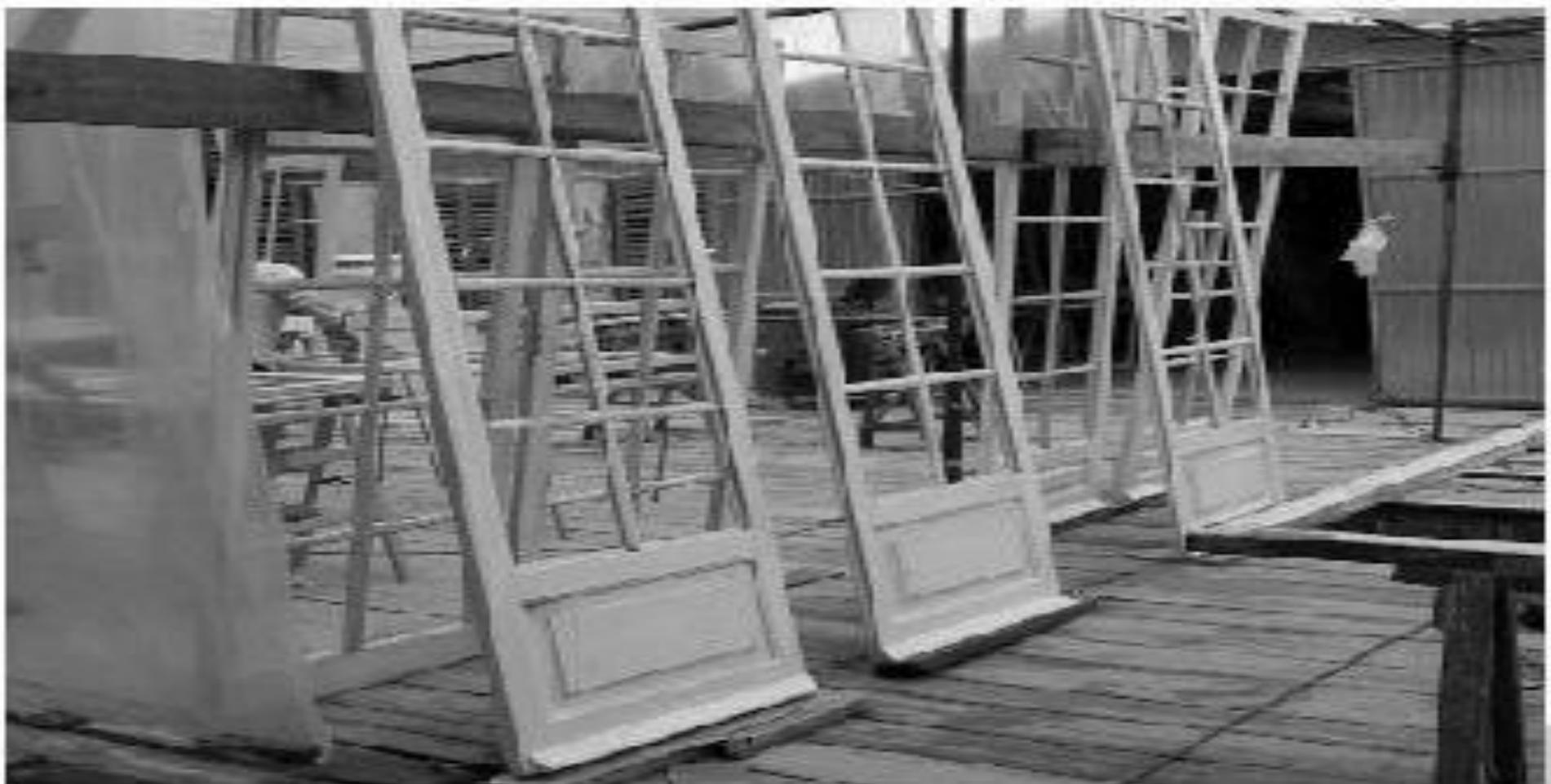
Figura 6 • Asciugatura dopo l'applicazione degli strati di coloritura.
