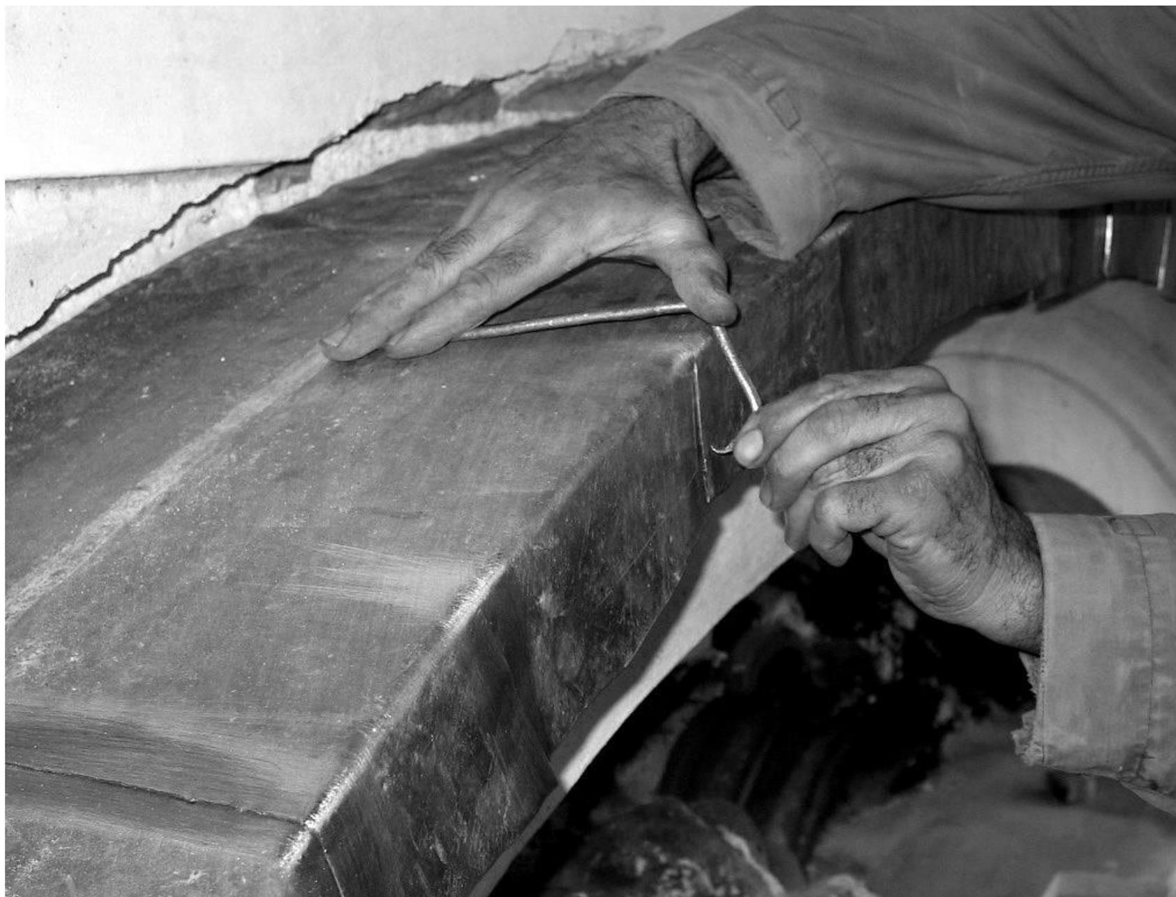
Figura 11 • Incisione della traccia necessaria all'esecuzione del taglio del materiale in eccesso.
