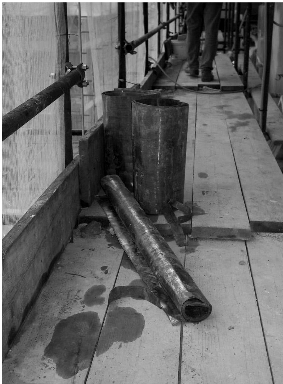
Figura 7 • Lamina di piombo in rotoli.
