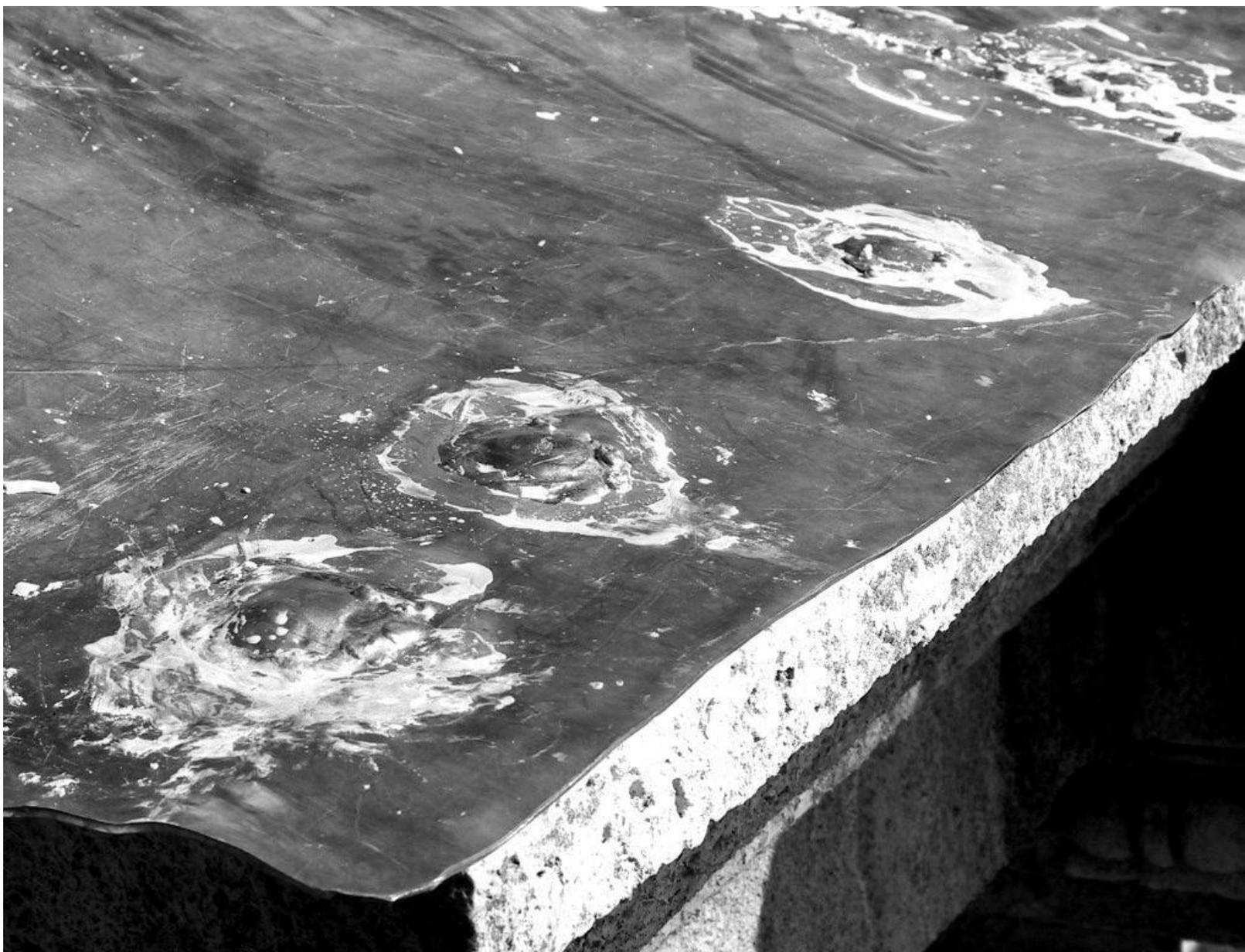
Figura 19 • Rivestimento delle teste delle viti a espansione e relative rondelle, con dischetti in lamina di piombo saldati, per evitare possibili infiltrazioni d'acqua.
