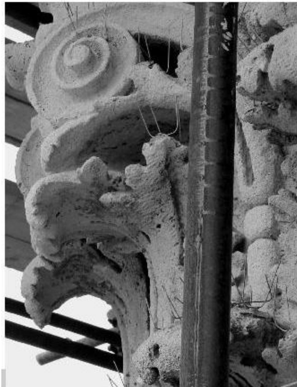
Figura 4 • Protezione di un capitello mediante il posizionamento di dissuasori ad aghi.
