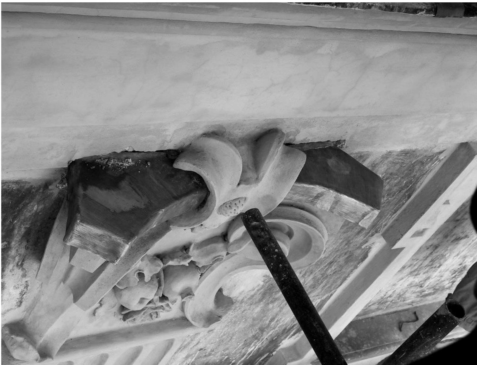
Figura 20 • Protezione di un capitello in stucco ottenuta tramite rivestimento dell'abaco con una lamina di piombo.
