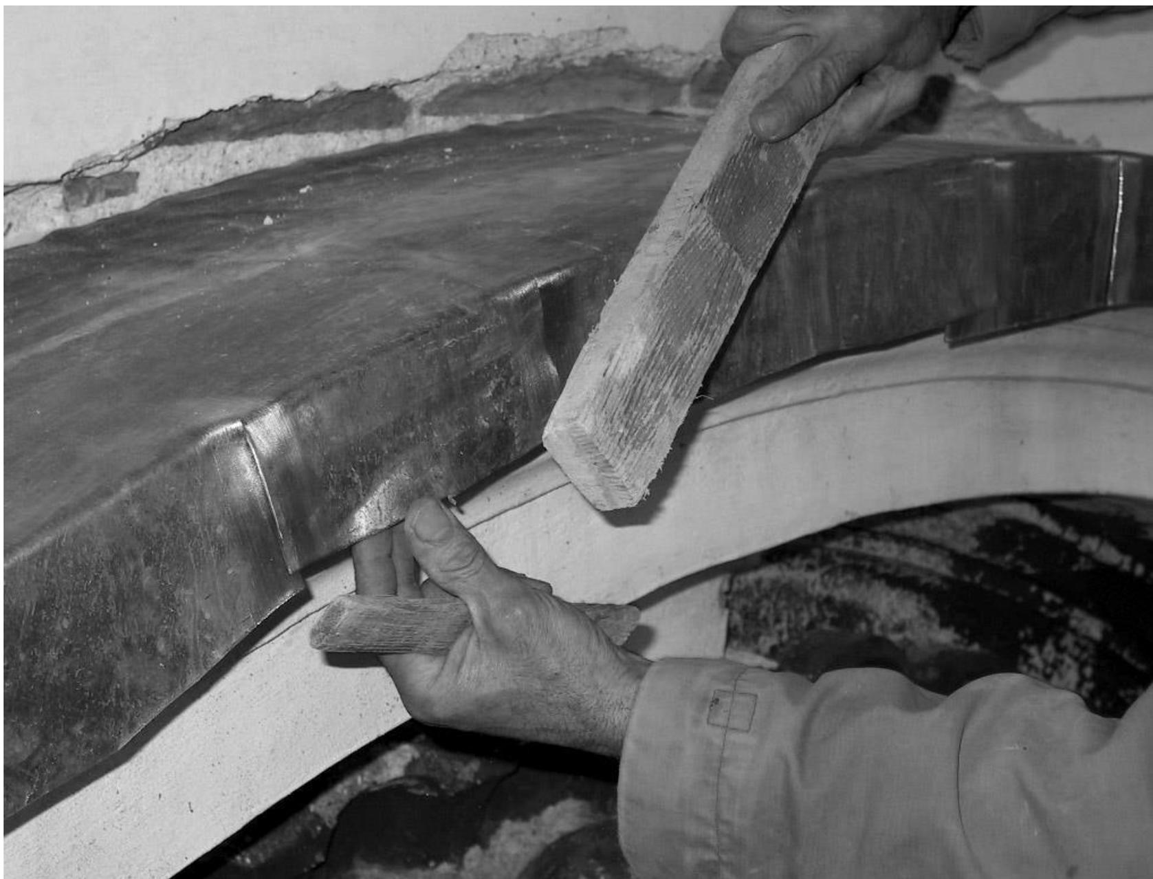
Figura 10 • Dettaglio dell'operazione di ribattitura del foglio di piombo.
