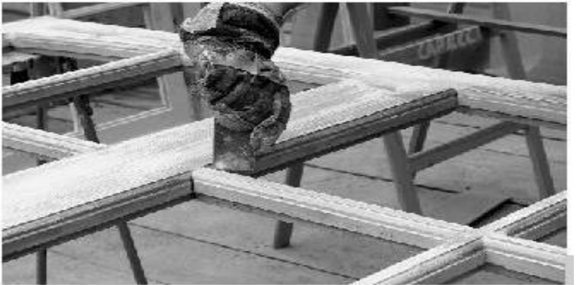
Figura 4 • Pulitura con raschietto.
