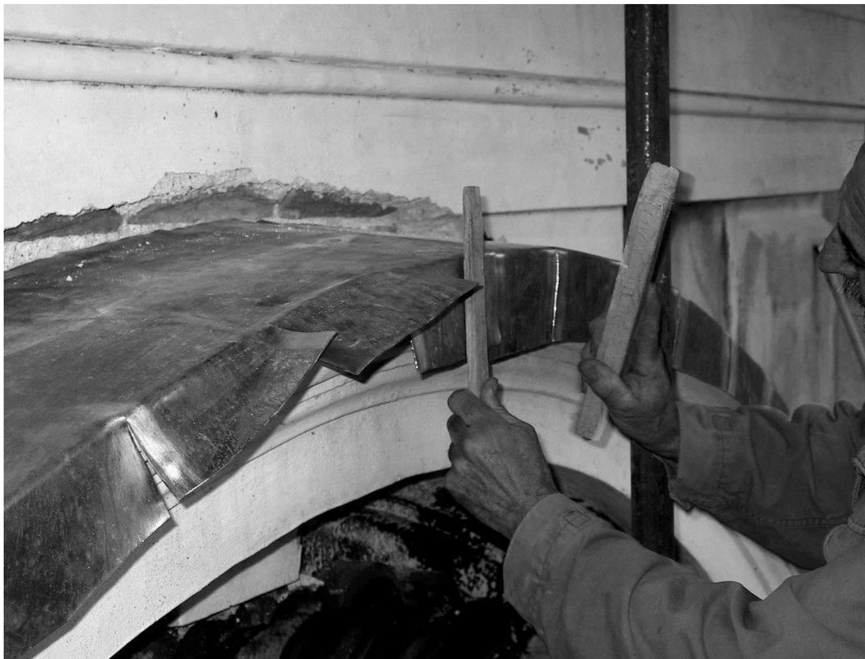
Figura 9 • Ribattitura del foglio di piombo mediante due assicelle di legno.
