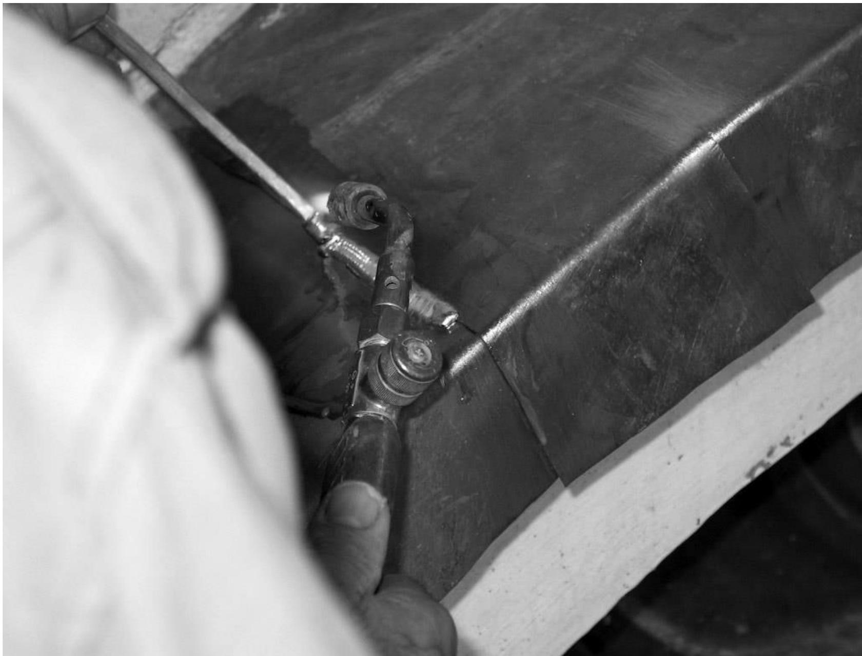
Figura 16 • Saldatura con cannello di stagno.
