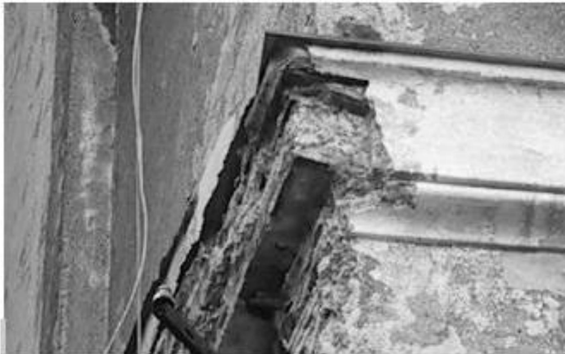
Figura 1 • Cornice marcadavanzale in stucco. La mancata riparazione o sostituzione della copertina di ardesia, posta a protezione della cornice, ha consentito alle acque meteoriche di compromettere l'integrità del rivestimento in stucco e del supporto in mattoni.
