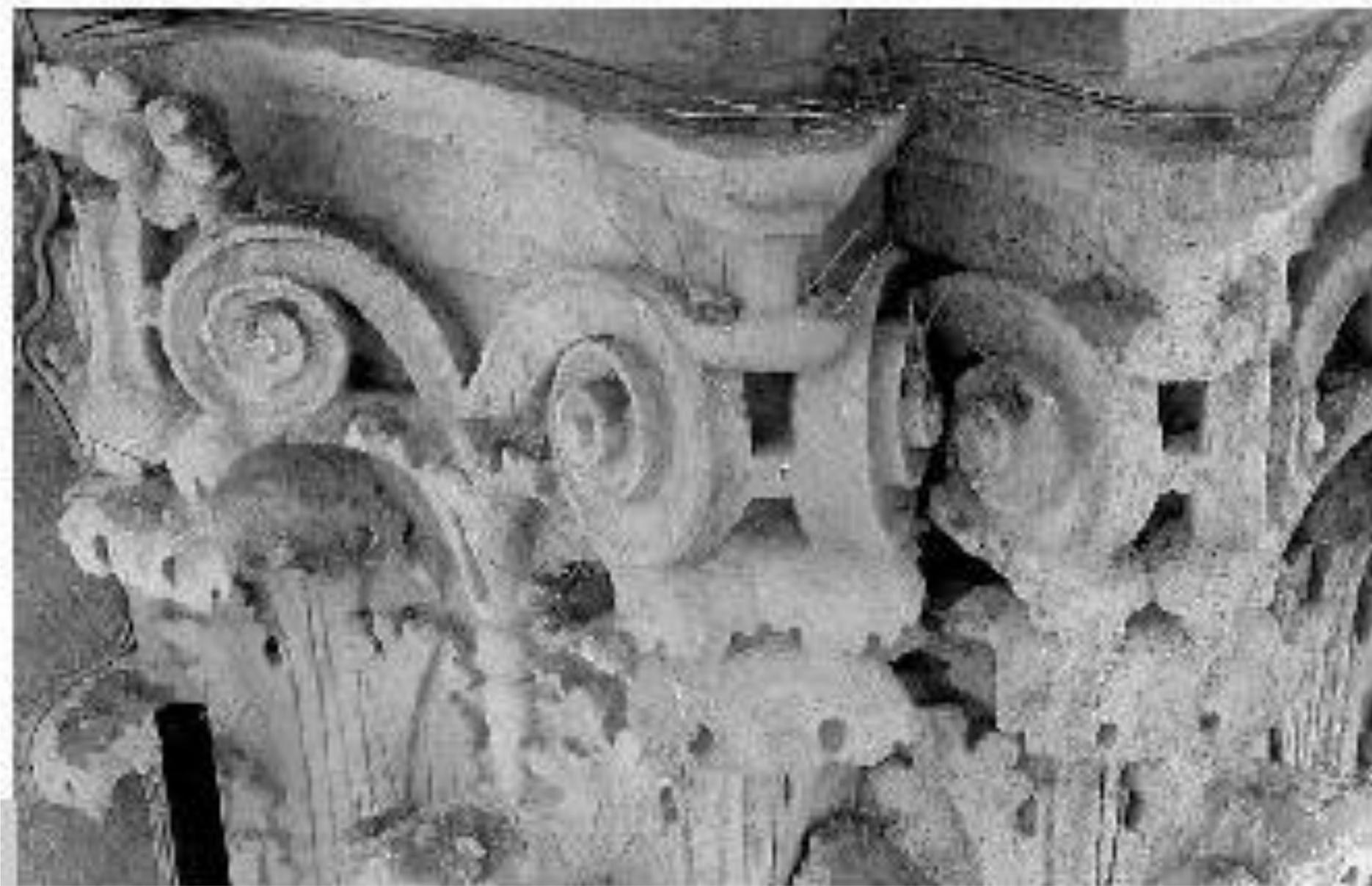
Figura 8 • Allontanamento di volatili con sistemi misti: mentre sulle volute sono stati applicati dei dissuasori ad aghi, sull'abaco del capitello si può vedere la linea del sistema elettrostatico.
