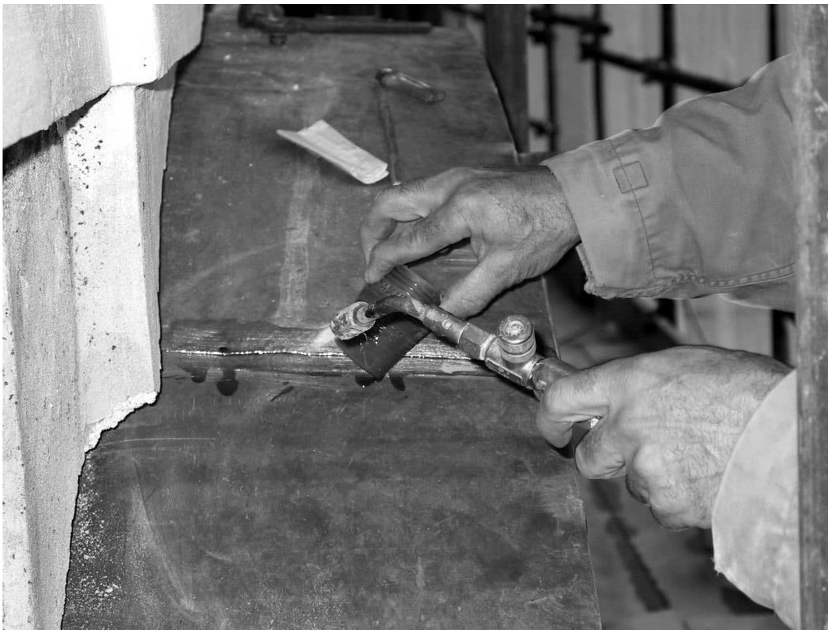
Figura 15 • Riscaldamento dei lembi da saldare e preparazione delle superfici con applicazione di stearina.
