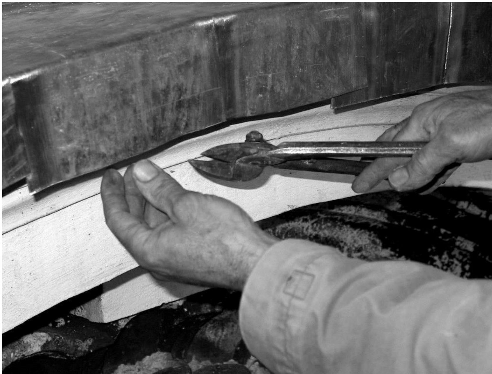
Figura 12 • Taglio con cesoie del materiale in eccesso.
