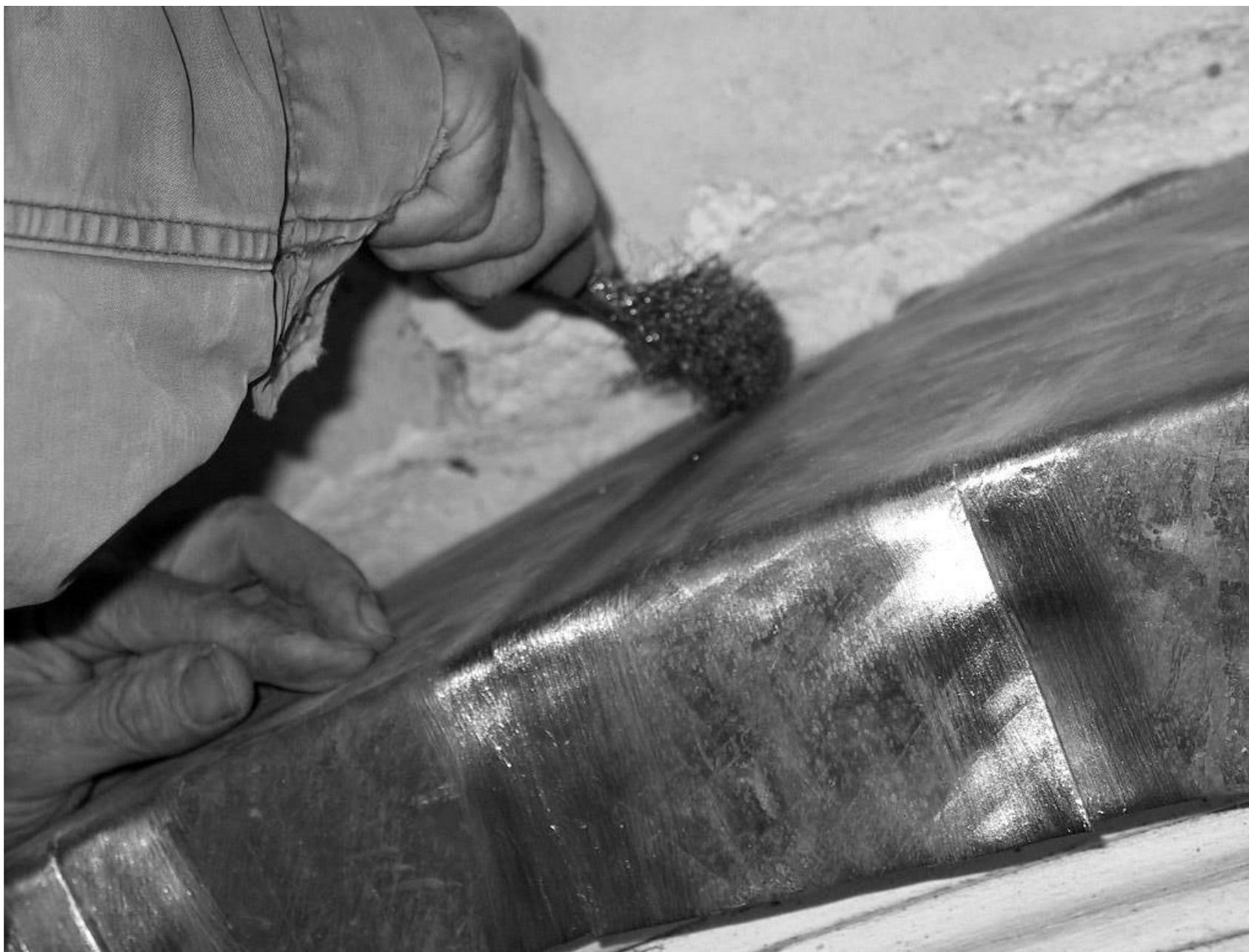
Figura 14 • Pulitura, mediante spazzola metallica, dei giunti da saldare.
