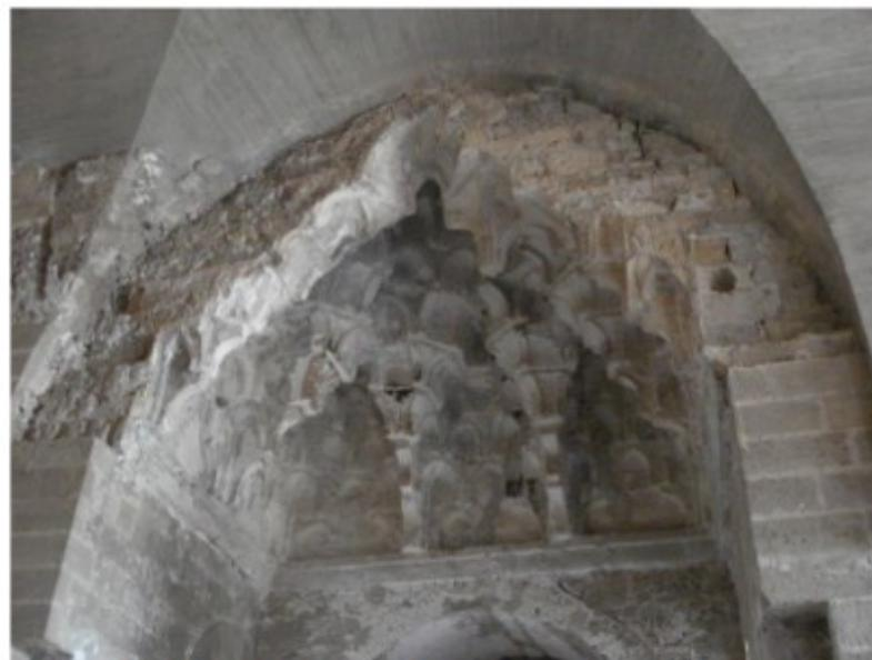
Particolare della *murqana*, e della ricostruzione della volta in cemento armato.
