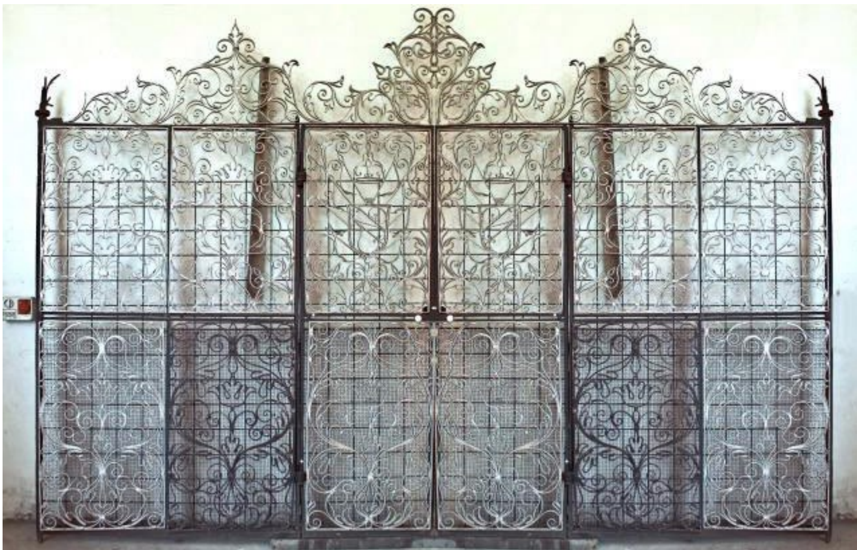
Figura 8 • Villa Barbaro a Maser. Cancello seicentesco pulito impropriamente con sabbatura a secco e bagno acido e successivamente sottoposto a zincatura a caldo. Tali trattamenti hanno alterato in modo irreversibile le caratteristiche fisiche e chimiche della superficie metallica. Il cancello, inoltre, è stato rimosso dalla collocazione originaria mediante tagli che hanno lasciato monconi residui delle volute decorative alle estremità superiori destra e sinistra.
