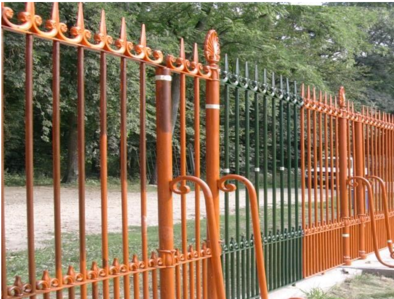
Figura 4 • Parco di Racconigi. Cancellata del Giardino dei Principini: fasi del ciclo di protezione e verniciatura su superficie sabbiata. Prima mano di minio arancione, seconda mano di minio marrone (per distinguere le mani durante l'applicazione e la verifica), campionatura con due mani di smalto verde alchilico lungo olio.
