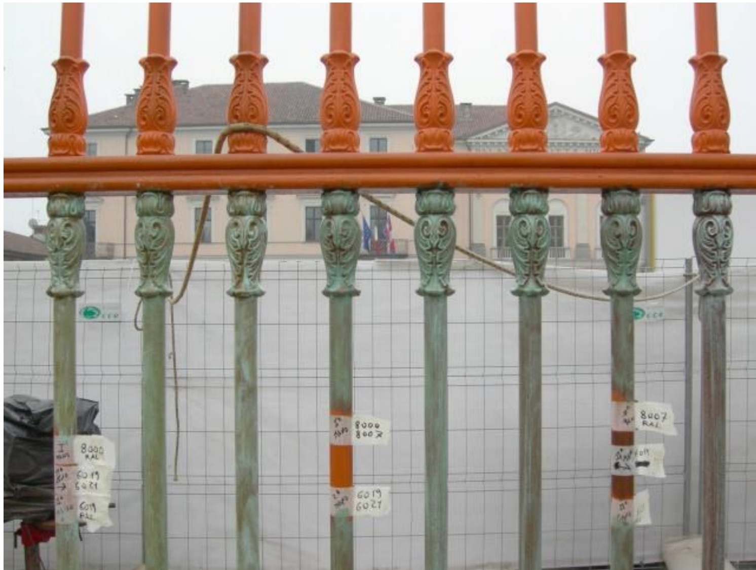
Figura 6 • Castello di Racconigi. Cancellata monumentale: parte superiore con una mano di minio su superficie sabbiata, parte inferiore con campionature colore realizzate con velature verdi su due mani di fondo marrone/bronzo ad interpretare le indicazioni dei documenti di calcolo e misura redatti nel 1843 da Ernest Melano che riportavano la dicitura “coloritura verde bronzo” o “coloritura in due riprese tinta bronzo”.
