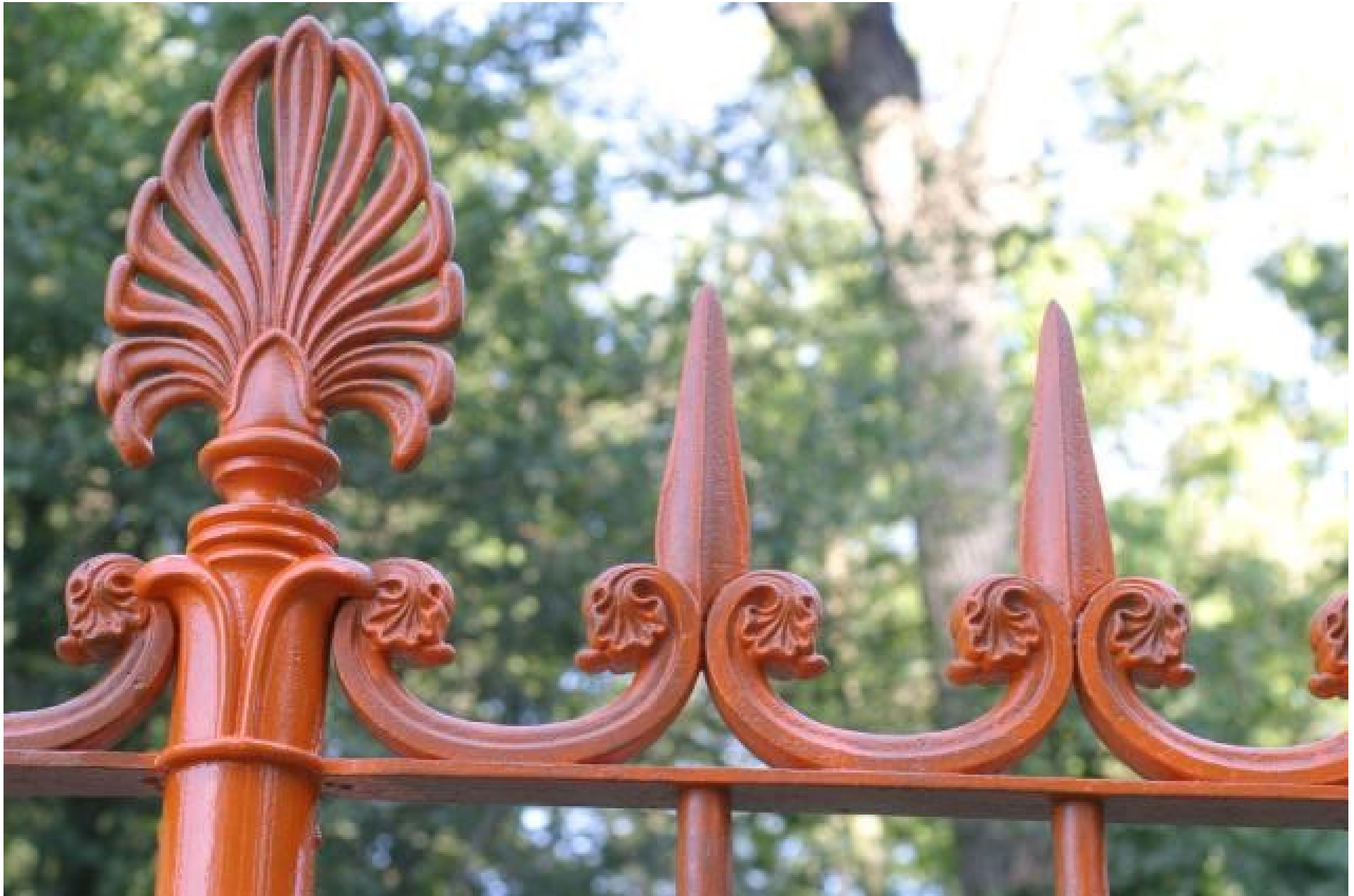
Figura 5 • Particolare della prima mano di minio su superficie sabbiata di una palmetta della cancellata.
