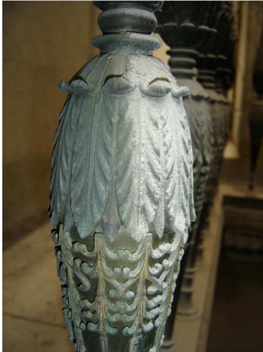
Figura 1 • Palazzo Nobile di Villa Torlonia (Roma). Particolare di un balaustrino con evidente accumulo di particellato.
