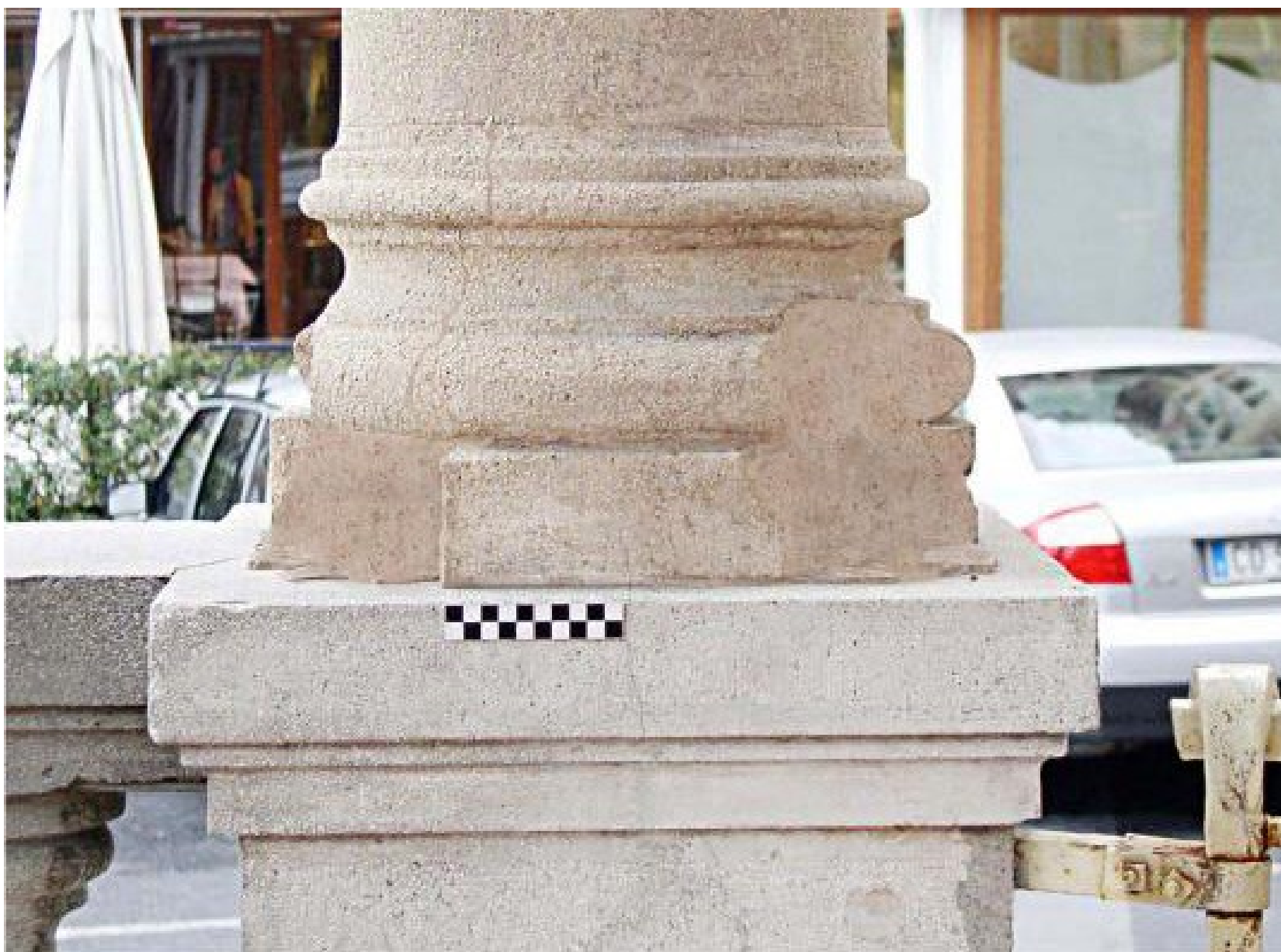
Figura 18 • Simulazione della stesura di una malta di protezione di tonalità simile all'impasto originale, senza la ricostruzione dei volumi.
