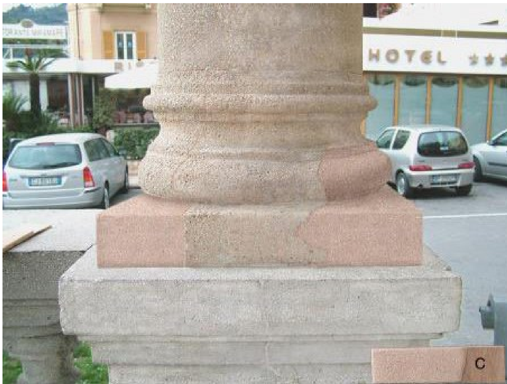
Figura 17 • Simulazione della integrazione delle mancanze elaborata con un impasto simile all'originale, ma applicata con un leggerissimo sottolivello.
