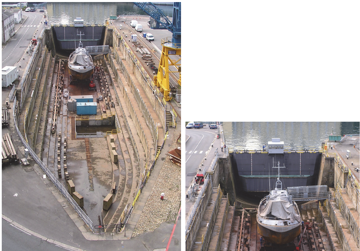
Fig. 13.1.2.1. Un piccolo bacino ed un dettaglio della barcaporta (foto dell'Autore, 2013)
