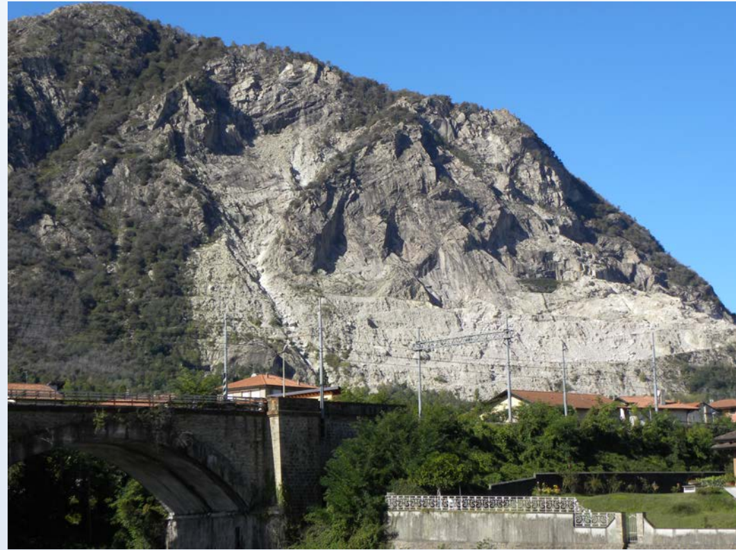
Cava del granito di Baveno (Piemonte)
