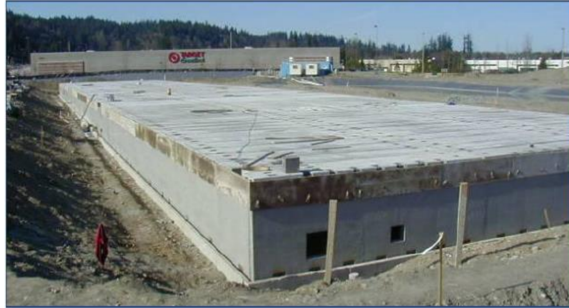
Esempio di vasca volano interrata in calcestruzzo
