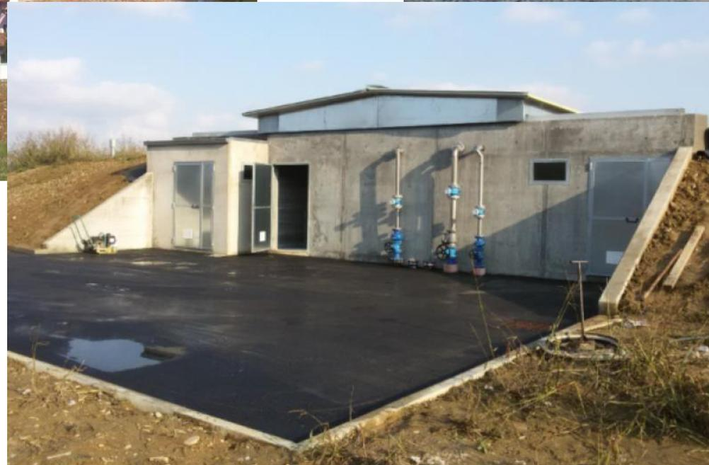
La scelta tra le diverse soluzioni è dettata da un confronto tra l'altezza massima del pelo libero nel serbatoio, per garantire il funzionamento a gravità della condotta di valle, e l'altezza geodetica del terreno al piano campagna di inserimento del serbatoio.
