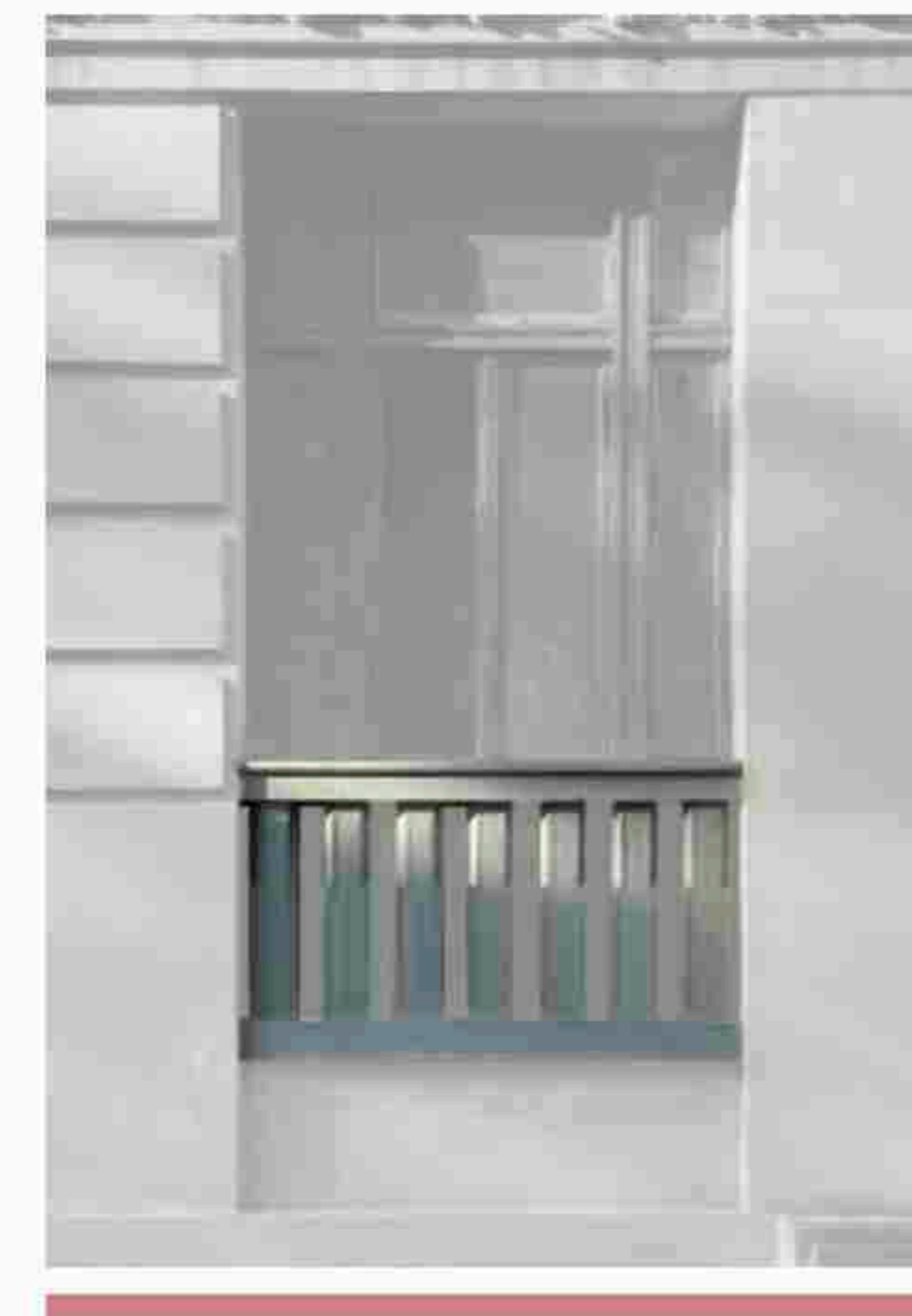
Balaustrini finestra livello 1 Graniglia di cemento MS_Jar_06
