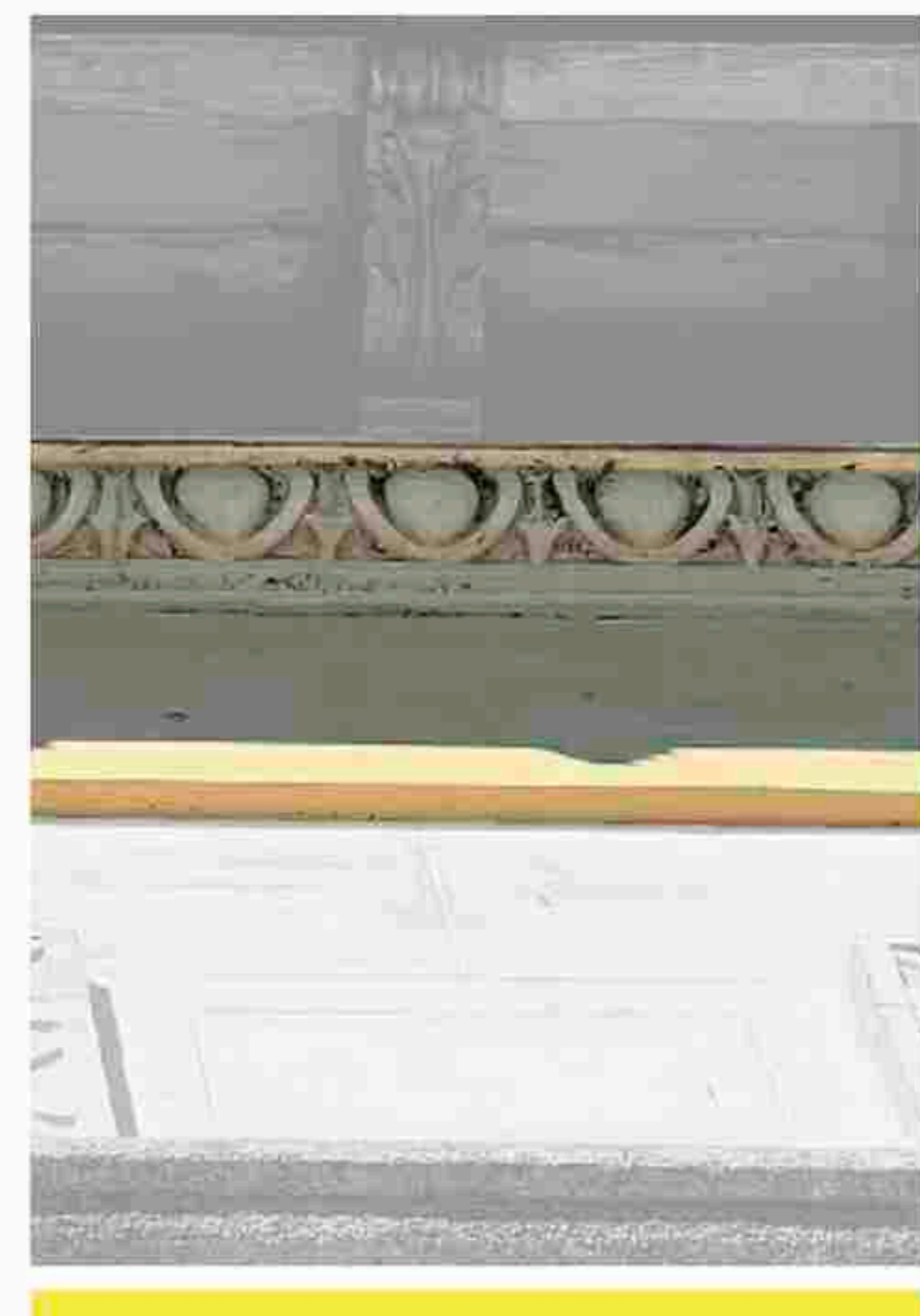
Cornice di gronda Intonaco a base cementizia MS_int_03
