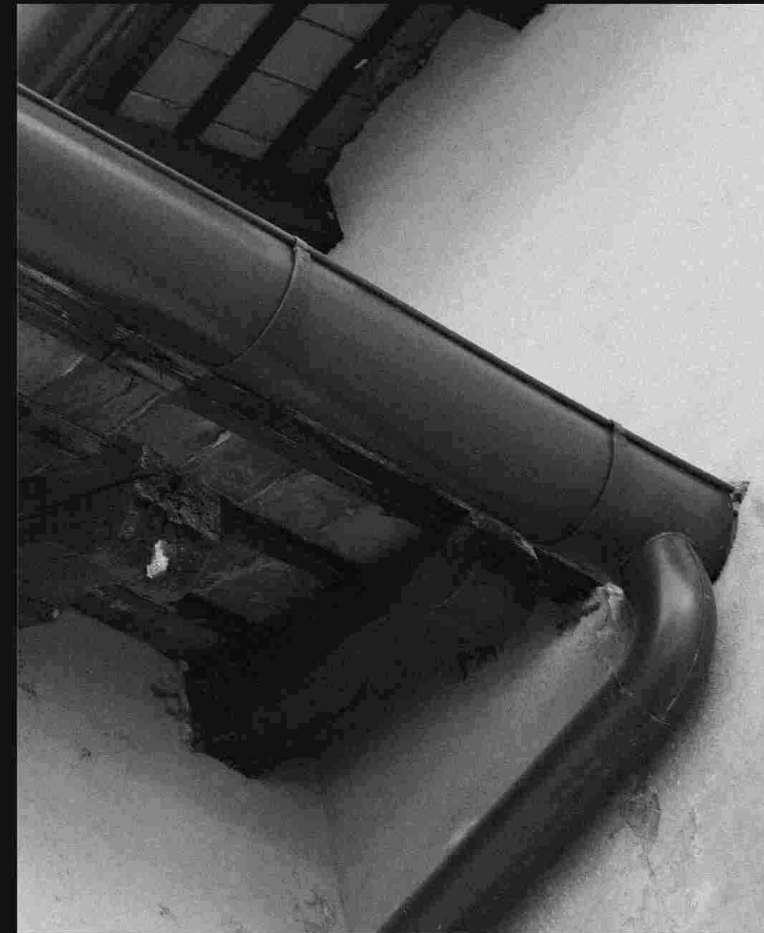
Dettaglio della copertura - puntoni, canale di gronda e pluviale
