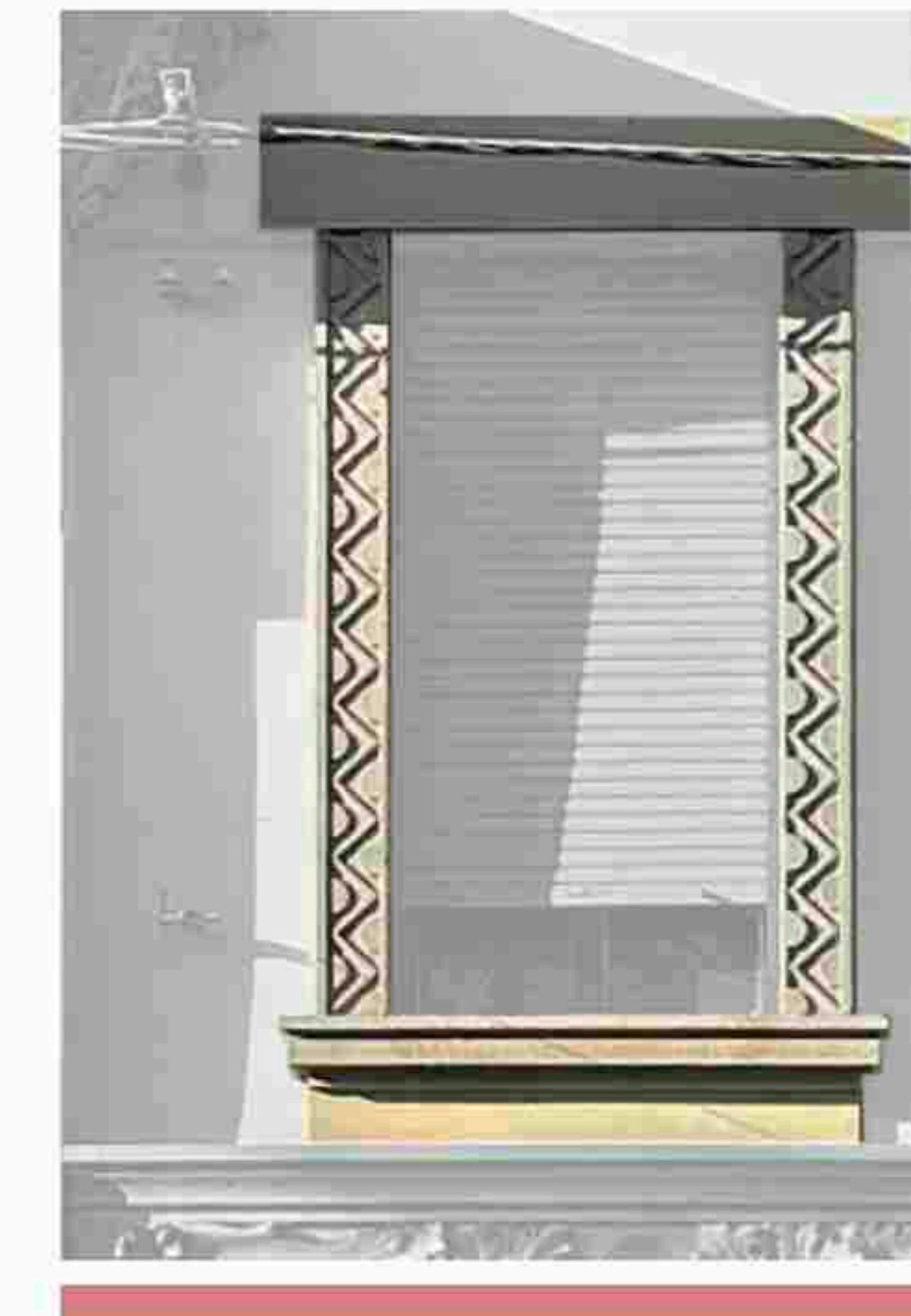
Cornice finestra livello 2 Graniglia di cemento MS_Jar_06 Intonaco a base cementizia MS_int_03
