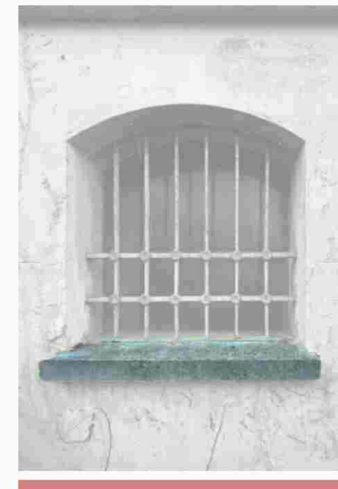
Davanzale finestra livello 0 Graniglia di cemento MS_Jar_06
