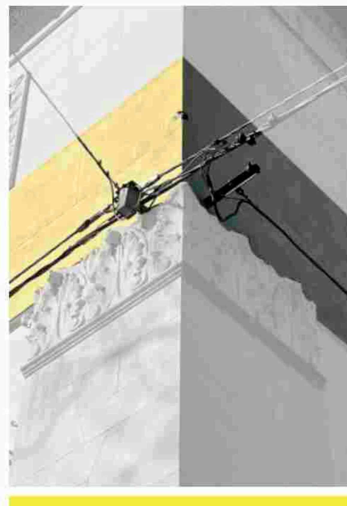
Cornice marcapiano livello 2-3 Intonaco a base cementizia MS_int_03
