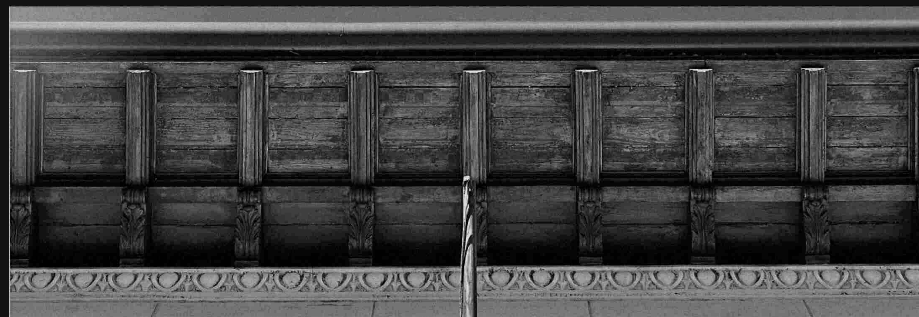
Dettaglio della copertura - decorazione lignea dello sporto di gronda
