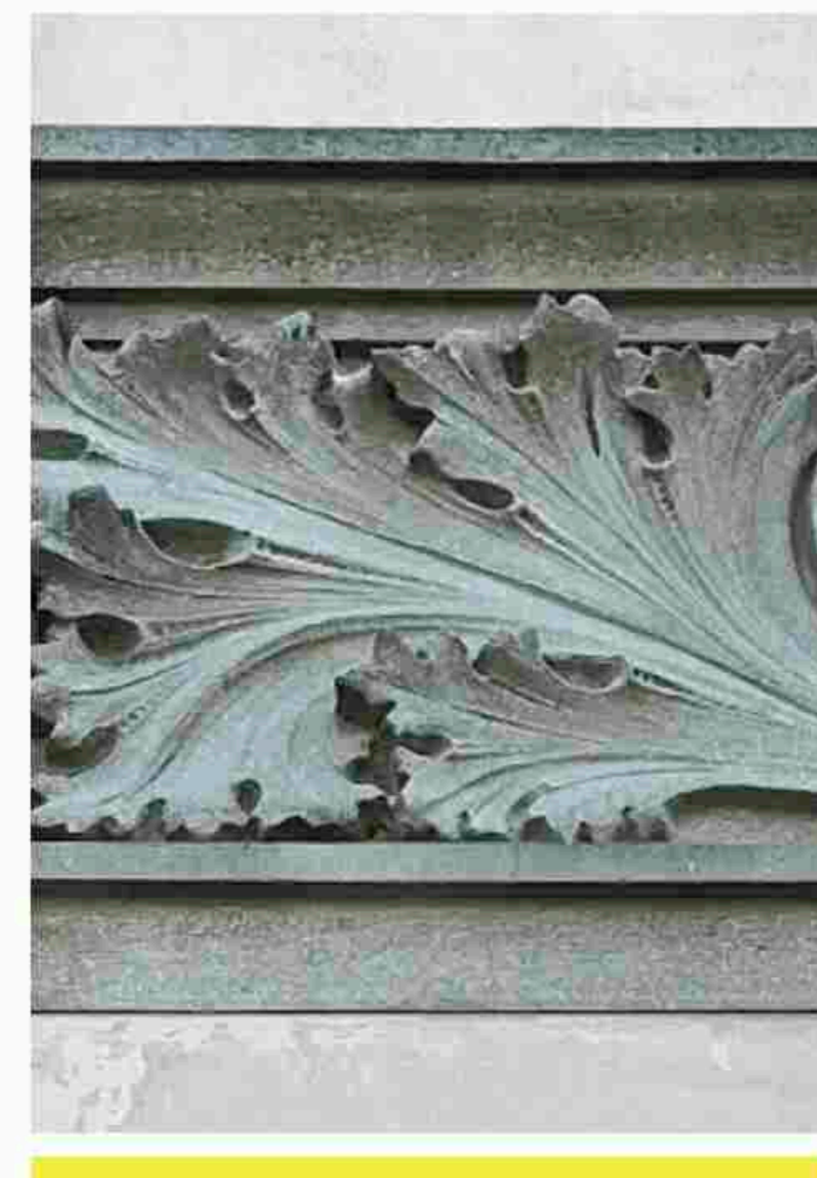
Cornice marcapiano livello 1-2 Graniglia di cemento MS_Jar_06
