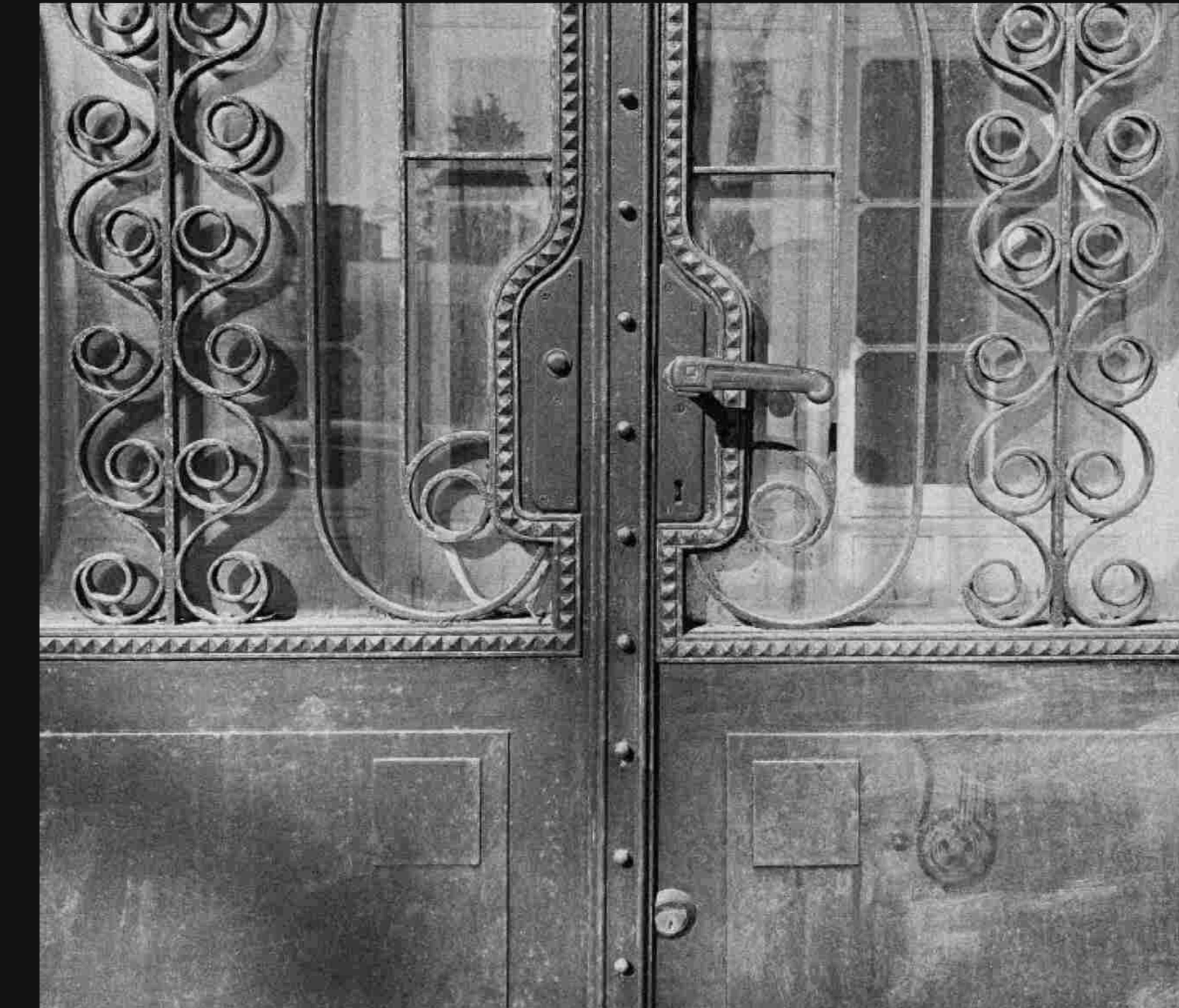
Dettaglio del portale - portone d'accesso all'edificio
