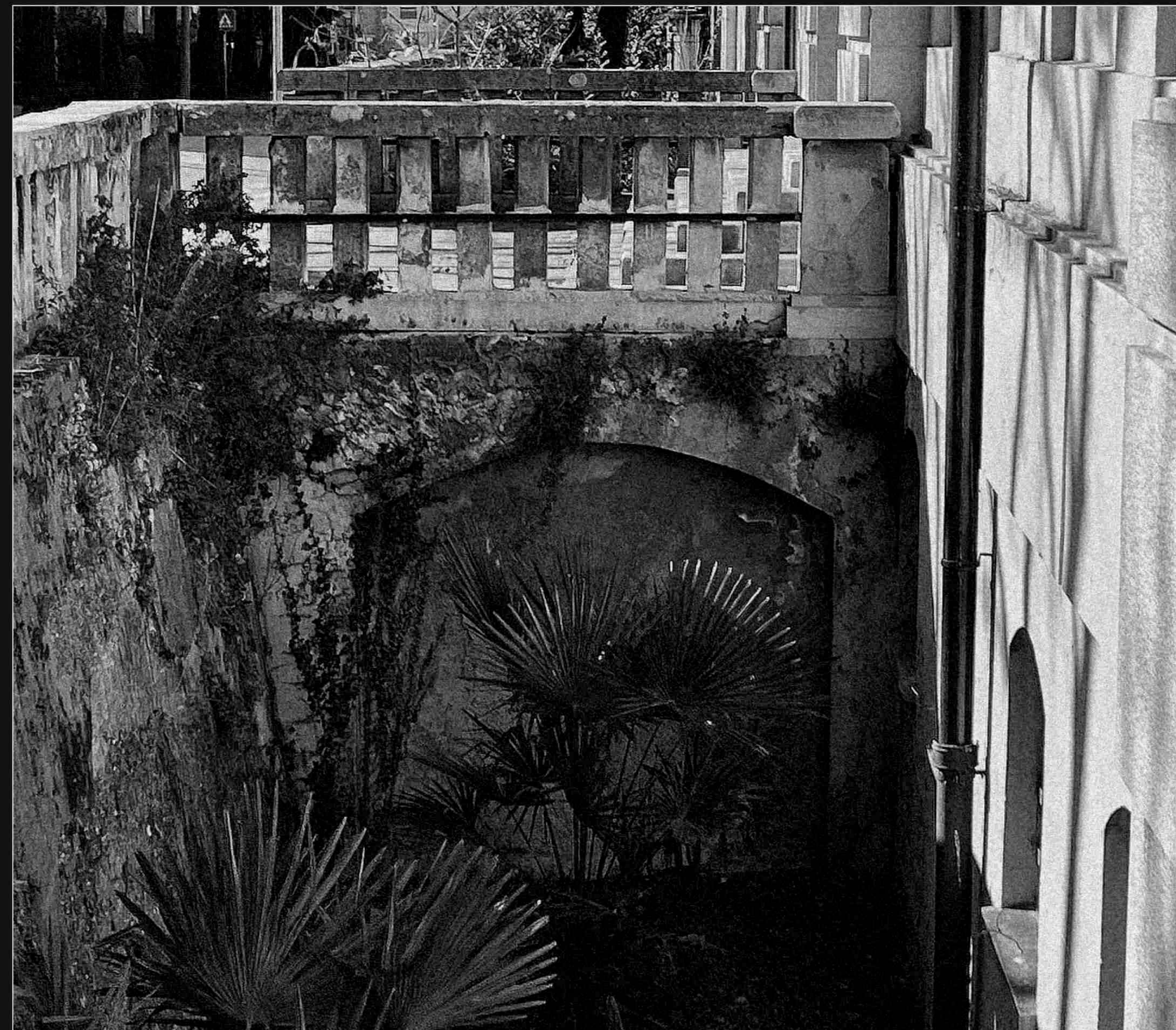
Dettaglio dell'accesso all'edificio - arco sottostrada
