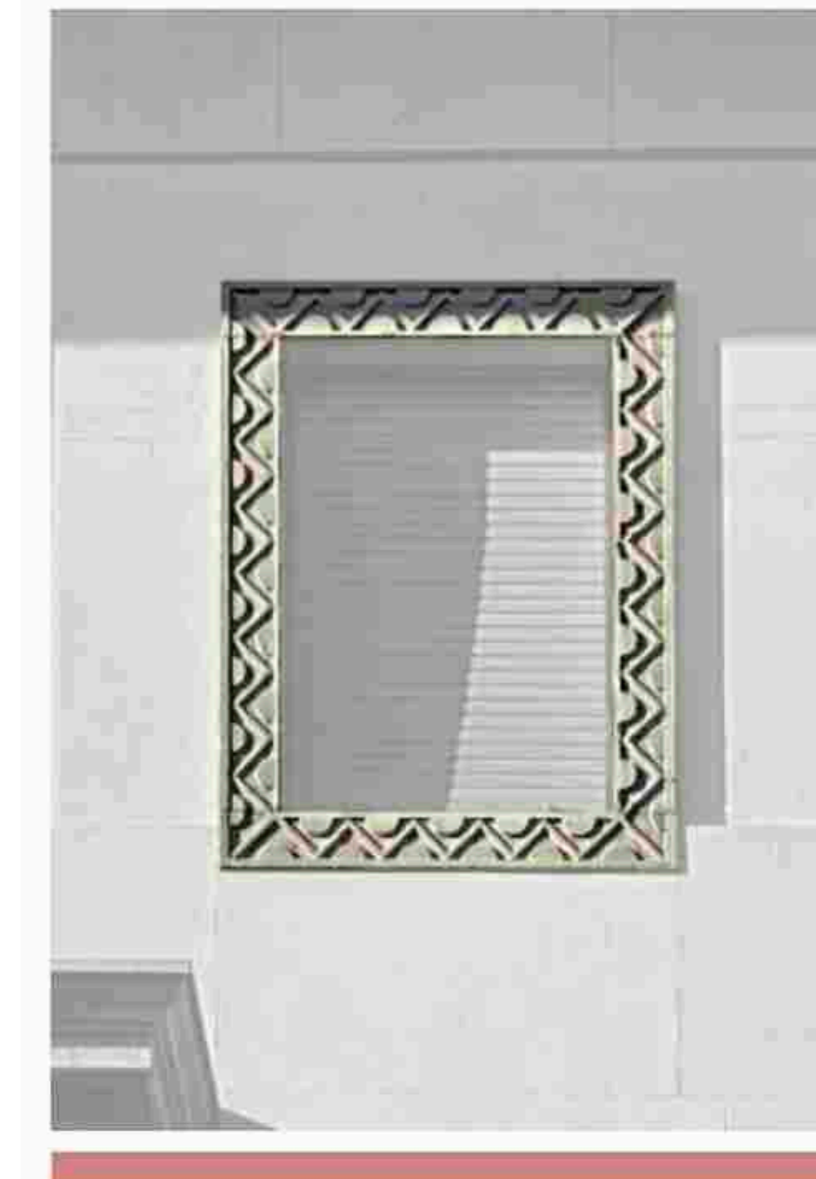
Cornice finestra livello 3 Graniglia di cemento MS_Jar_06
