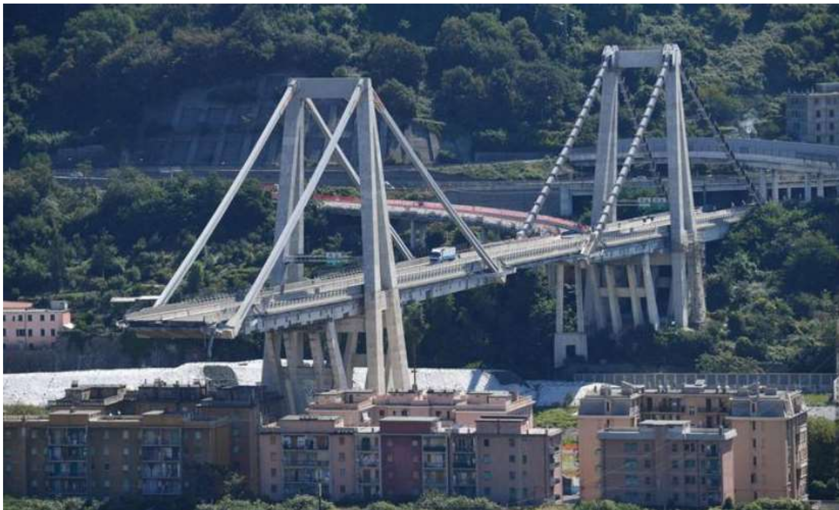
Viadotto sul Polcevera – Genova (ago. 2018)
