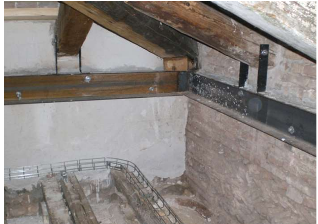
Legature orizzontali in profilati di acciaio spinottati.
