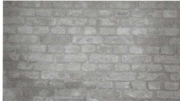
Mattoni pieni e malta di calce
