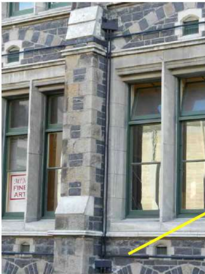
Particolari tirantature verticali e orizzontali post-tese
