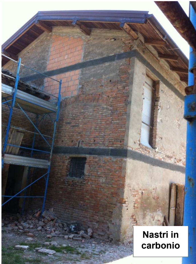
Legature orizzontali in profilati di acciaio spinottati.
