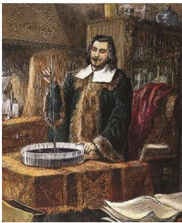
Nell'esperimento di Torricelli, una colonna di 760 mm di mercurio equivale la pressione atmosferica
