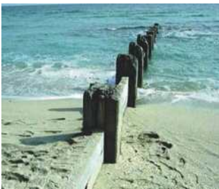
Figura 4.2.14: Pennello impermeabile con tavole e pali in legno trattati. Questo tipo di struttura è indicato per paraggi non soggetti a forte ondatazione e necessita di una buona infissione degli elementi nella sabbia e di un buon trattamento impermeabilizzante per il legname.
