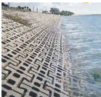
Figura 4.3.17: Esempio di sponda con rivestimento protettivo Armorloc. Ogni elemento costitutivo è connesso ad altri 6 elementi adiacenti, in modo da formare una struttura solidale e resistente al moto ondoso, in situazioni di bassa energia.
