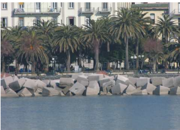
Figura 4.3.16: Rivestimenti in cubi di calcestruzzo (lungomare di Salerno) e in tetrapodi (prov. di Messina).
