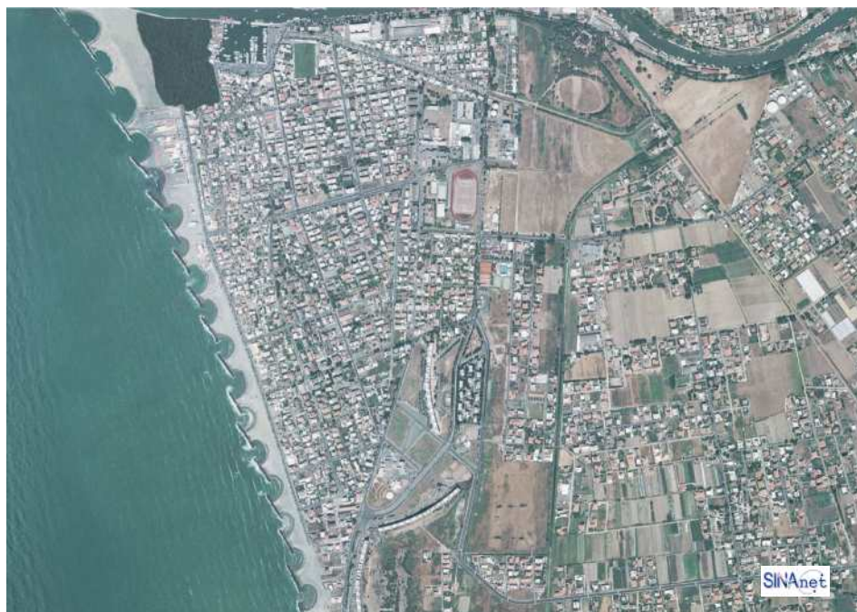
Figura 4.1.10: Roma, Comune di Fiumicino. Barriere emergenti inclinate verso la direzione della corrente litoranea prevalente. Questo tipo di opere, molto impiegato negli anni '60-'80 sul litorale laziale, viene realizzato allo scopo di contrastare l'azione diretta del moto ondoso e di favorire la formazione di nuova spiaggia. Terraltaly it2000™ © C.G.R. S.p.A. PARMA
