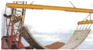
Figura 4.3.27: Operazione di installazione di una Unità Dytap
