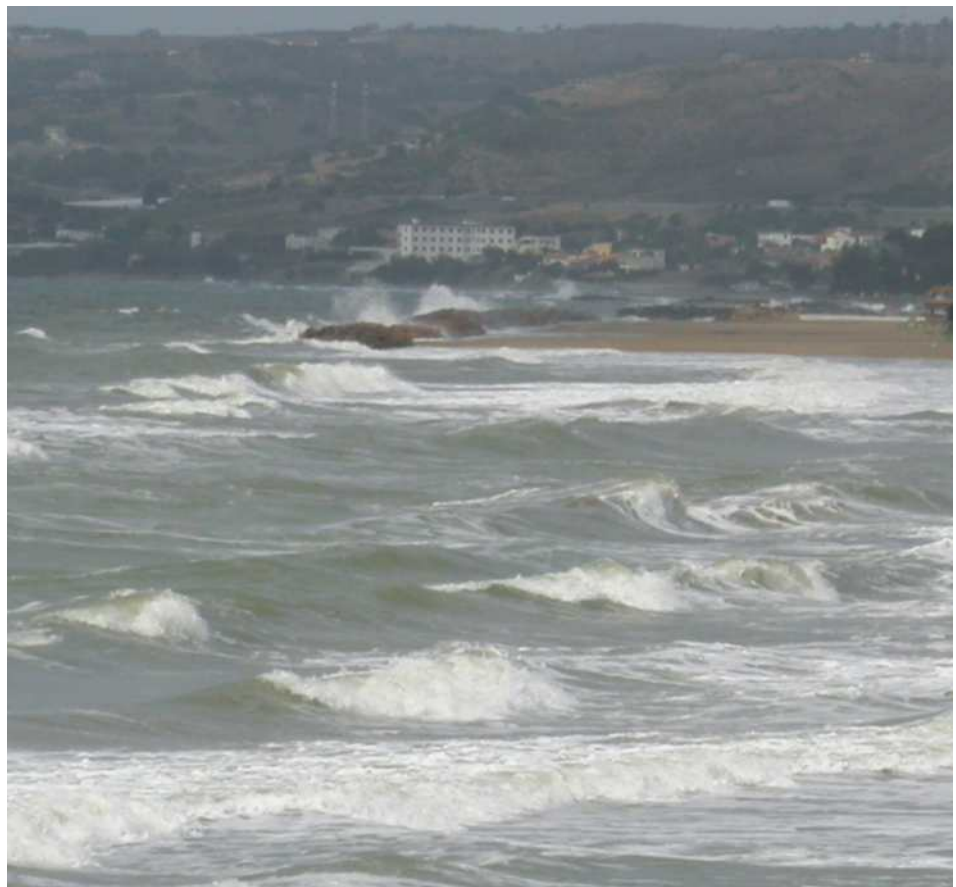
Figura 4.0.4: Effetto del moto ondoso su barriere emergenti nella costa laziale. L'azione erosiva delle onde viene fortemente ridimensionata a tergo delle zone protette.
