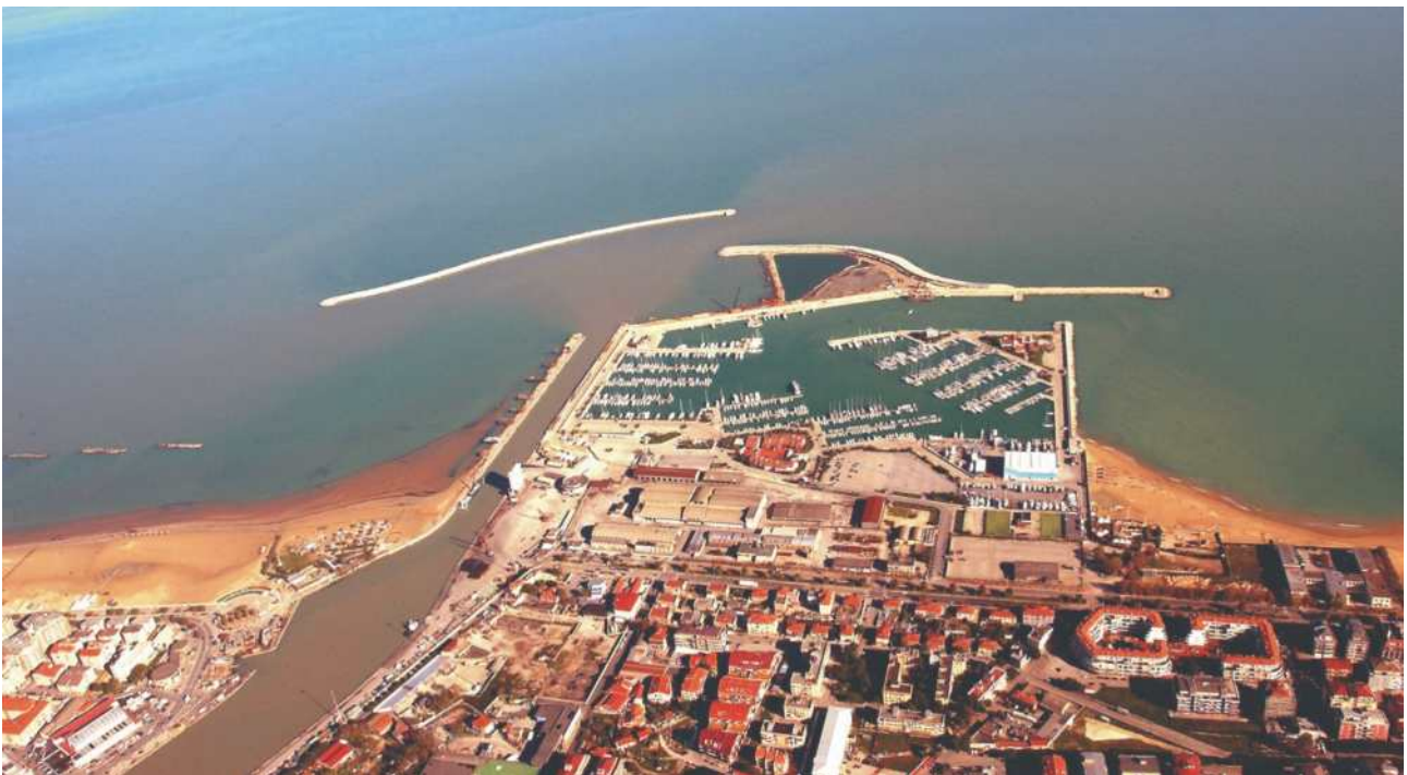
Figura 7.0.2: Porto-canale con diga foranea di protezione dell'imbocco, situato alla foce del fiume Pescara. La struttura di protezione, costruita a metà degli anni '90, impedisce la libera dispersione verso il largo delle acque dolci ed inquinate del fiume, che vengono così deviate verso il litorale a nord del porto, dove determinano problemi per la balneabilità delle spiagge. Sono in corso di studio alcune soluzioni alternative mirate alla mitigazione del problema dell'inquinamento. Nella stessa immagine è possibile osservare l'effetto di accumulo dei sedimenti determinato dal molo di destra del porto turistico (al centro), e dal molo di sinistra del porto-canale, dove viene segnalato il costante avanzamento della linea di riva accompagnato da una generale diminuzione della profondità del fondale. Foto, P. Orlandi.
