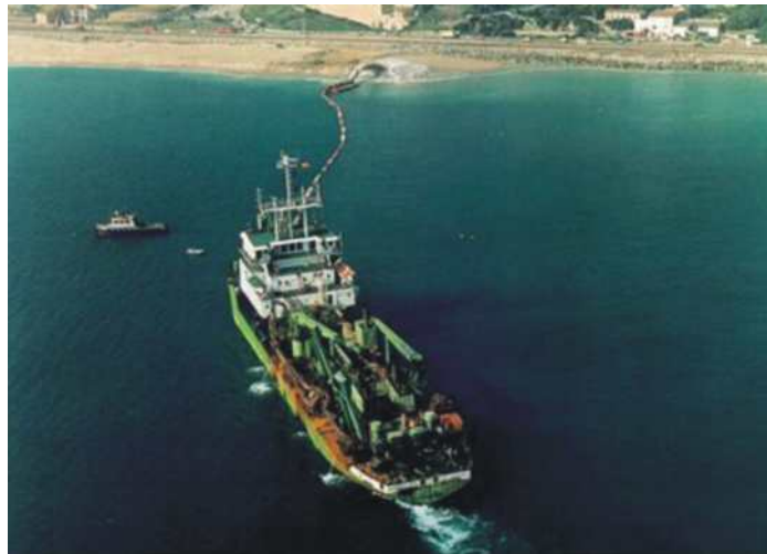
Figura 4.4.5: Panoramica di una draga in funzione durante la fase di scarico del sedimento. (Foto BeachMed).
