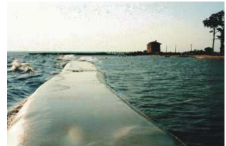
Figura 4.1.22: Barriere con tubi Longard. Un tubo Longard è una struttura con un doppio strato in geotessuto, costituito da polietilene impermeabile, con un diametro di 1-1,8 metri ed una lunghezza di 100 metri. Per il riempimento dell'involucro vengono realizzati due fori di 50 cm di diametro muniti di flangia. Il tubo viene esteso per la sua intera lunghezza e riempito idraulicamente con sabbia prelevata in sito, dopodiché i fori vengono sigillati.
