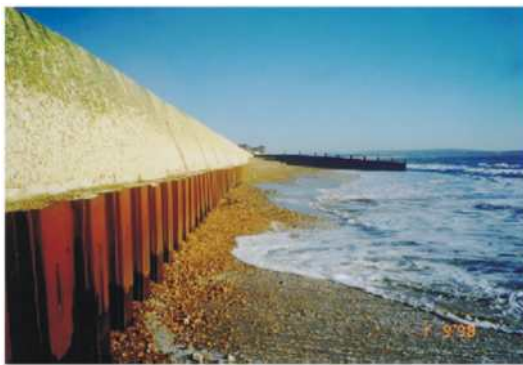
Figura 4.3.42: Paratie in acciaio. Sono costituite da palancole metalliche che possono essere infisse sia in terreni compatti che incoerenti. Le loro giunzioni impediscono all'acqua ed alla sabbia di penetrare. La struttura finale può essere chiusa superiormente con una trave in calcestruzzo oppure ancorata.
