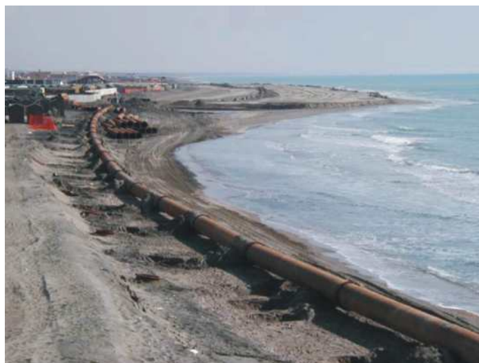
Figura 4.4.6: Particolare delle tubazioni utilizzate per il refluento di sabbia lungo l'arenile di Ostia nel 1999. (Foto Centro Monitoraggio Litorali Laziali).
