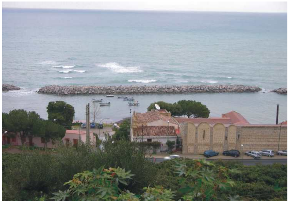
Figura 4.0.5: Le opere parallele e distaccate sono manufatti di tipo attivo-rigido, posizionati in mare, preferibilmente paralleli alla costa, che hanno lo scopo di provocare una dissipazione dell'energia del moto ondoso a distanza dalla riva (attenuandone il potere erosivo sui bassi fondali). (Salerno)
