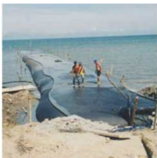
Figura 4.2.16: Pennello con tubi Longard. I Longard sono applicati negli interventi a breve termine o nelle situazioni di emergenza, a causa della loro vulnerabilità al danneggiamento (ad esempio fori o lacerazioni nel tessuto con perdita del contenuto sabbioso).
