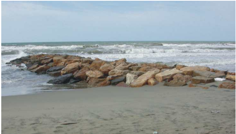
Figura 4.2.12: Pennello con mantellata in massi naturali. La disposizione degli elementi costituenti lo strato più esterno deve avvenire secondo una configurazione che sia più omogenea possibile. Dimensioni e dettagli devono essere determinati in base alle condizioni del sito, in particolare in base alle condizioni ondose incidenti.
