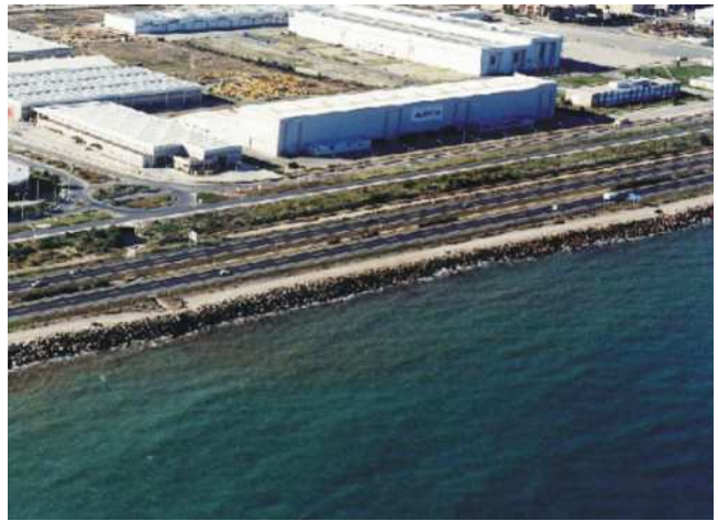
Figura 3.4.1: Foto a) Foce dell'Albegna (Regione Toscana). Foto b) Litorale spagnolo Le immagini illustrano le principali funzioni esercitate dalle barriere radenti: a) limitare l'erosione delle spiagge causata dall'azione del moto ondoso frangente; si può osservare un "rudimentale versamento" di massi naturali lungo la riva a protezione della spiaggia); b) sostenere il terreno a tergo della barriera - barriera posta a protezione della rete viaria in zona industrializzata.
