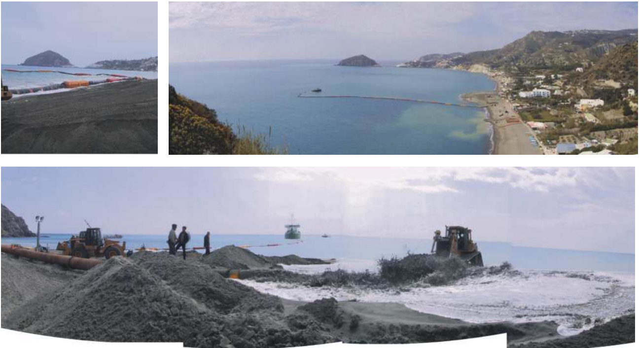
Figura 3.4.8: Attività di ripascimento della spiaggia dei Maronti (Isola di Ischia). Le foto illustrano l'installazione della condotta di refluento, costituita da tubazioni di acciaio per il tratto a terra e da tubazioni flessibili galleggianti per il tratto a mare. Al largo (su fondale di 10 m) la tubazione termina su un pontoncino di riferimento e con l'elemento di aggancio rapido alla draga (MODIMAR-s.r.l.).
