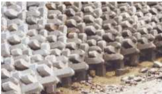
Figura 4.3.14: Rivestimento in Unità A-Jacks. In questa opera di difesa non è prevista la presenza di barre o cavi d'acciaio di collegamento, ma l'omogeneità dell'intera massa è data dall'elevata capacità che hanno i singoli blocchi di interconnettersi reciprocamente, formando quindi una struttura solida.
