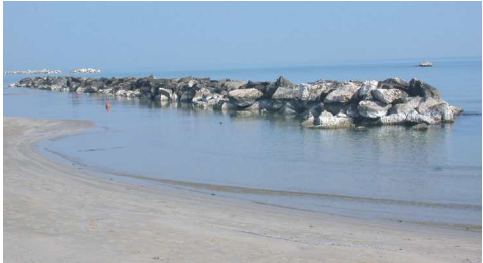
Figura 4.1.15: Barriera in massi naturali. Normalmente viene costruita su un adeguato imbasamento e con un nucleo in pietrisco. I materiali naturali più utilizzati sono in genere quelli calcarei (ad es. breccie calcaree cementate), ma si fa spesso ricorso anche a materiali ignei, quali graniti, lave, ecc.
