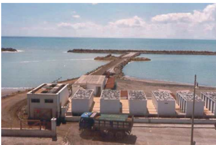
Figura 4.4.14: Lavori per ripascimento protetto di Ostia Centro (1989). Notare che il camion che entra nel cantiere ha il carico di sabbia coperto da un telo al fine di ridurre la dispersione del sedimento durante il trasporto. (Foto Centro di Monitoraggio dei Litorali Laziali).
