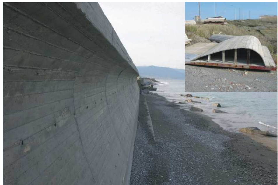
Figura 4.3.34: Muro concavo con paraonde. La presenza di un coronamento ricurvo contrasta la risalita e il conseguente scavalcamento dell'opera da parte delle onde più violente. Al piede del muro, o nelle sue vicinanze, è opportuno prevedere la collocazione di massi di protezione.
