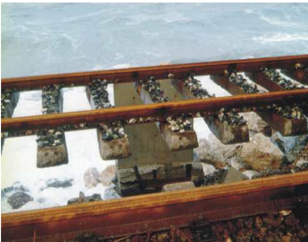
Figura 3.4.2: Foto a) Litorale calabro tirrenico (ESTRAMED s.p.a.). Foto b) Litorale di Fano (Regione Marche) Esempi di cattiva progettazione di barriere di protezione radenti. L'azione del moto ondoso frangente ha dato origine ad un approfondimento locale dei fondali, causando lo scalzamento al piede ed il successivo crollo dell'infrastruttura.
