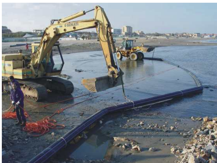
Figura 4.4.8: Messa in opera della tubatura per by pass al Porto Canale Garibaldi (Foto A. Peretti).
