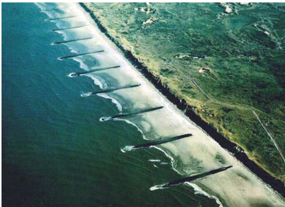
Figura 4.4.18: Serie di pennelli con versamento di sedimento realizzata sulla spiaggia di Valencia (Spagna). (Foto BeachMed).
