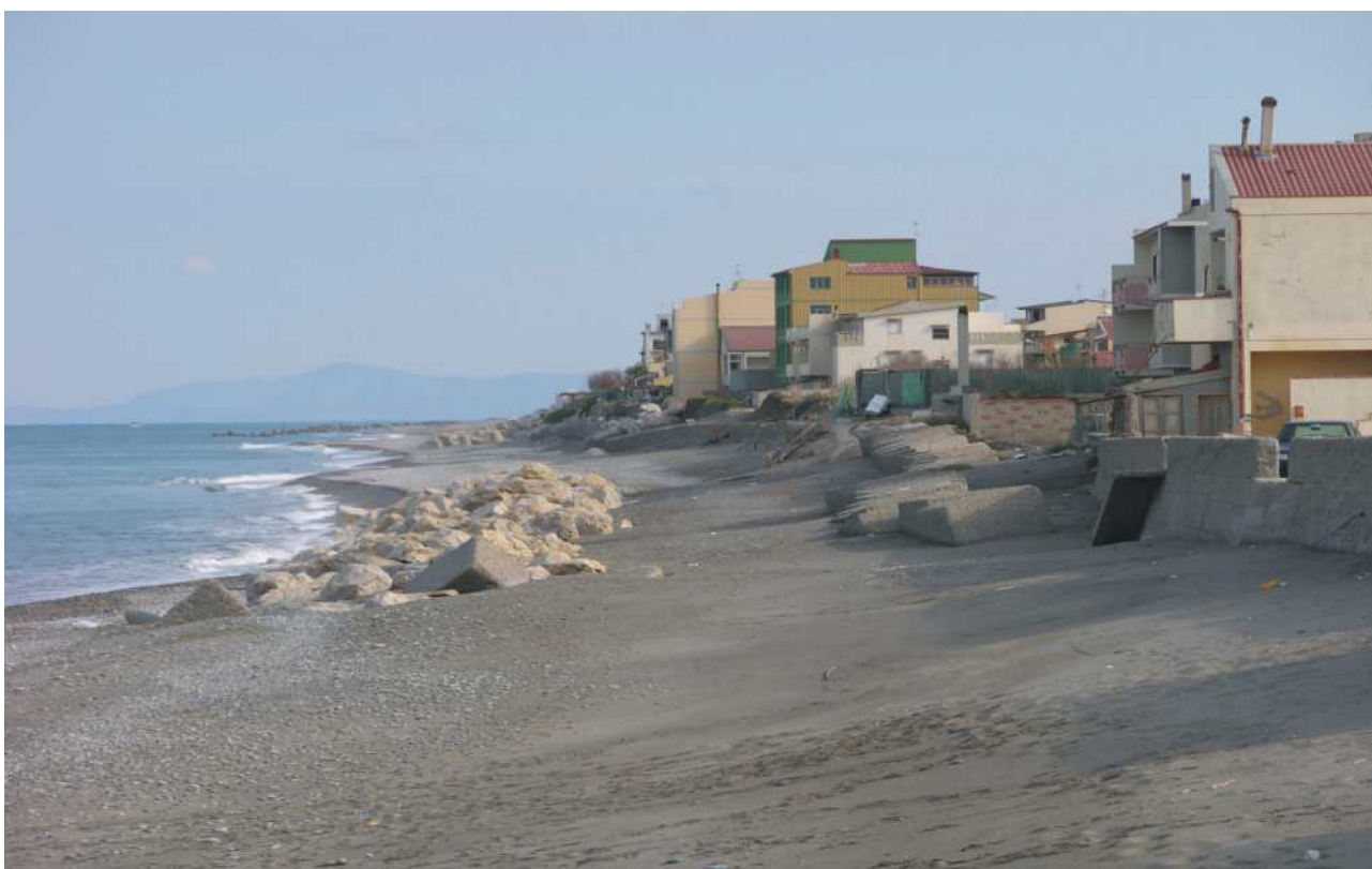
Figura 4.0.1: Comune di Capo d'Orlando (ME). Effetti dell'azione erosiva del mare sul litorale sabbioso antropizzato. La dinamica naturale, modificata dall'uomo mediante una non appropriata gestione delle coste ed un abusivismo incontrollato, comporta conseguenze negative sui litorali, con ingenti danni economici alle strutture. Per mitigare gli effetti dell'arretramento della linea di riva, si interviene con opere di protezione, che devono essere progettate tenendo conto dei fattori meteomarinari locali, della batimetria, della morfologia costiera e del contesto geoambientale.
