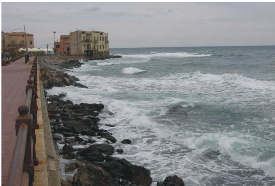
Figura 4.3.30: Palermo, località Santa Flavia. Muro verticale in calcestruzzo. La protezione al piede, con massi naturali, consente di limitare gli effetti del fenomeno della riflessione, che a lungo andare può provocare l'approfondimento del fondale antistante e lo scalzamento della struttura.
