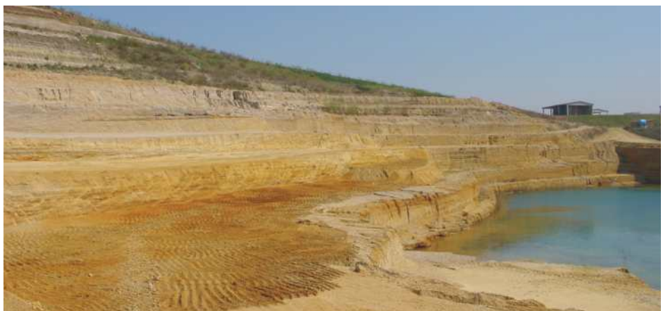
Figura 4.4.12: Fronte di scavo di una cava di Ponte Galeria nei pressi di Roma. (Foto S. Milli).
