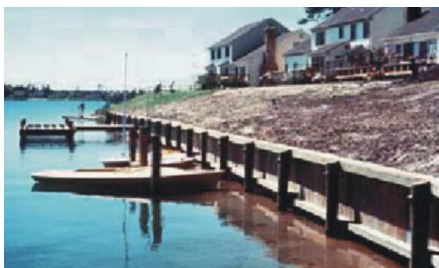
Figura 4.3.43: Paratia in legno. Essa è costituita da pali di grande diametro ai quali sono incastrati pali di legno orizzontali, a tergo dei quali viene fatto un riempimento di ghiaia e terreno granulare, poggiato su tessuto filtrante. L'installazione di un filtro resistente, capace di far da ponte tra i vuoti presenti fra i pali, può garantire una buona integrità del sistema e prevenire rotture.
