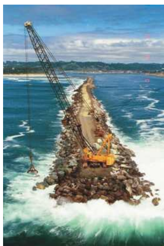
Figura 7.1.3: Costruzione di un molo radicato con mantellata in massi naturali.
