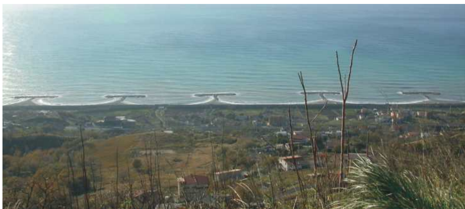
Figura 4.2.6: Fiumicino (RM). Spiaggia protetta da un campo di pennelli con antistante barriera sommersa.
