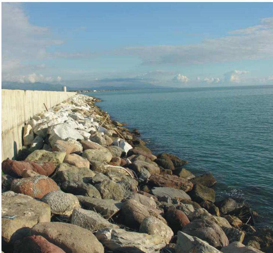
Figura 3.4.4: Carrara. Esempio di rivestimento flessibile a massi lapidei sciolti. Questa struttura permette alla massa d'acqua frangente di dissipare parte dell'energia.
