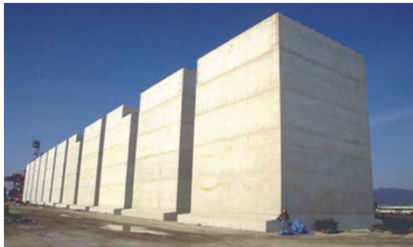
Figura 7.1.7: Cassoni in c.a. Pronti per essere rimorchiati verso il sito di costruzione del molo. Una volta sul luogo le strutture vengono affondate riempiendole con materiale inerte.
