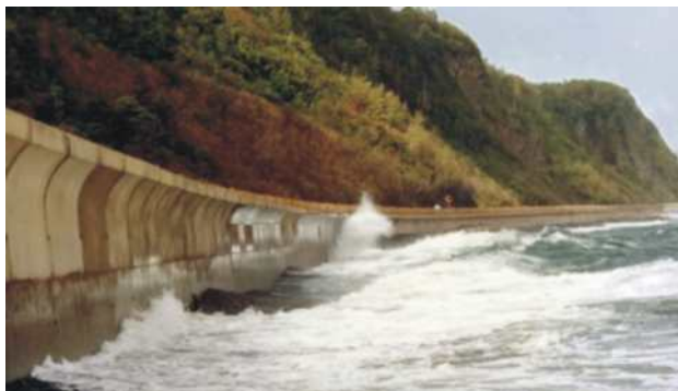
Figura 4.3.37: Muro in terra armata a sostegno di una strada.
