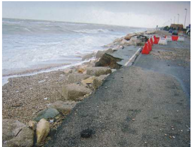
Figura 3.4.2: Foto a) Litorale calabro tirrenico (ESTRAMED s.p.a.). Foto b) Litorale di Fano (Regione Marche) Esempi di cattiva progettazione di barriere di protezione radenti. L'azione del moto ondoso frangente ha dato origine ad un approfondimento locale dei fondali, causando lo scalzamento al piede ed il successivo crollo dell'infrastruttura.
