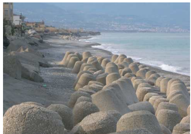
Figura 4.3.16: Rivestimenti in cubi di calcestruzzo (lungomare di Salerno) e in tetrapodi (prov. di Messina).
