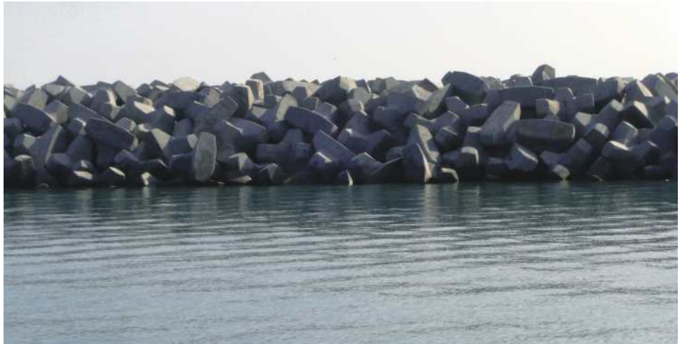
Figura 3.4.3: Opere di rivestimento di scarpate costituite da massi naturali ed artificiali (accropodi) all'interno della Laguna di Venezia (Corsini S.).
