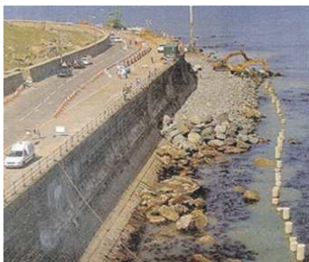
Figura 4.3.31: Costruzione di un muro verticale con sottostruttura di cut-off in pali, a protezione del piede. Il cut-off ha la funzione di impedire l'azione diretta delle onde marine sulla parte inferiore del muro. La difesa viene completata tramite il versamento di pietrame disposto alla rinfusa.
