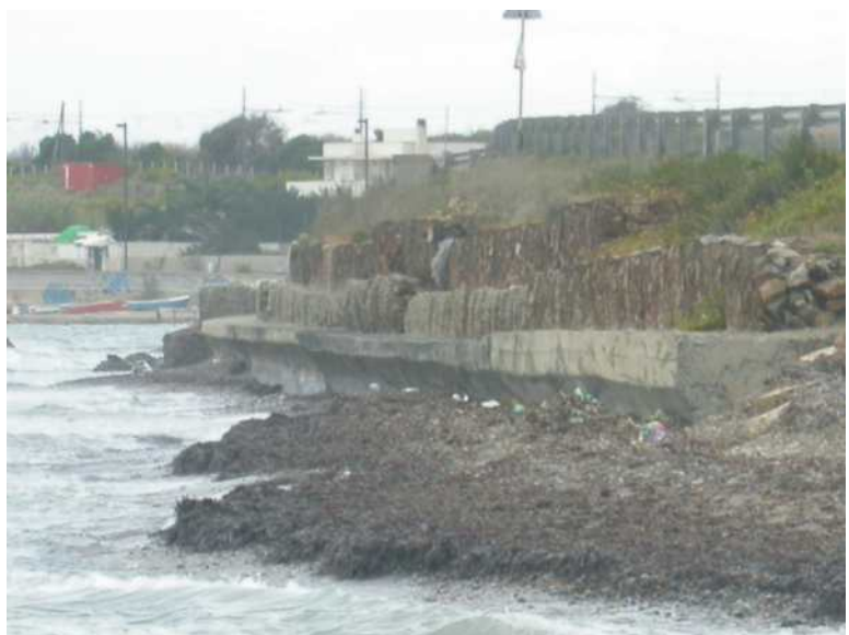
Figura 4.3.13: Esempi di protezioni di strade litoranee con rivestimenti in gabbioni. Nell'esempio a destra (litorale laziale) i gabbioni sono sistemati su un muro paraonde sagomato per riflettere l'onda incidente. Le gabbionature nei due casi assolvono anche ad una funzione di sostegno del terreno.
