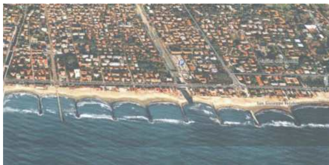
Figura 4.2.5: Marina di Massa (MS). Le strutture sono disposte in serie e variano in lunghezza da 30 metri a 100 metri, estendendosi dal retrospiaggia alla prima linea dei frangenti. La spaziatura dei pennelli deve essere abbastanza ampia da evitare lo scalzamento ai fianchi, ma abbastanza ridotta da costituire una trappola per i sedimenti.
