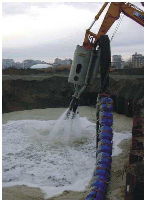
Figura 4.4.9: Disgregatore ad acqua utilizzato per mobilizzare il sedimento dall'area di dragaggio (Foto A. Peretti).
