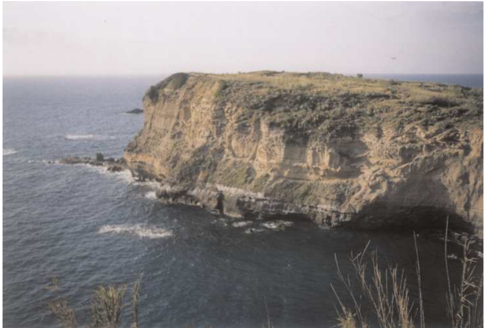
Figura 2.1.1: Ventotene (LT): Cala Parata Grande. Il mare aggredisce ed erode le coste rocciose tramite l'abrasione e la corrosione. L'azione di scalzamento al piede della parete rocciosa ne determina il crollo e quindi l'arretramento, contemporaneamente contribuendo alla formazione della piattaforma litoranea.
