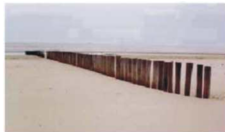
Figura 4.2.18: Pennello con palizzata in legname. L'utilizzo di una semplice struttura in legno, fa sì che grazie alla sua permeabilità non avvenga il fenomeno di dentellatura della linea di costa, con la formazione di un profilo costiero omogeneo, sia a monte che a valle dell'opera. Le strutture, una volta completate, agiscono deviando o intercettando le correnti lungo riva e, spesso, fornendo un ostacolo fisico al movimento del materiale di spiaggia. I limiti delle opere di difesa trasversali in pali di legno sono costituiti da una scarsa azione di barriera meccanica, dalla loro durata limitata e dagli alti oneri di manutenzione, nonostante il basso costo iniziale, e delle proprietà geologico-tecniche del substrato di incastro.
