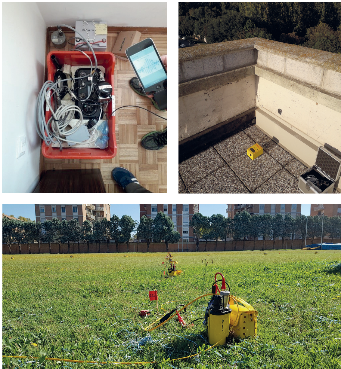
Fig. 3 - Strumentazione per l'indagine sull'interazione suolo-struttura e il comportamento dell'edificio: a) Reftek + 1s Lennarts; b) Tromino; c) Geofoni verticali a 4.5 Hz.
