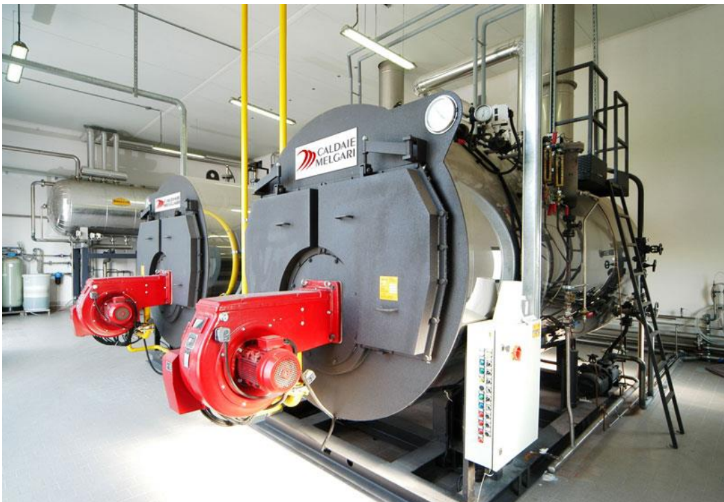
Figura 82 Generatore di vapore a tubi di fumo
