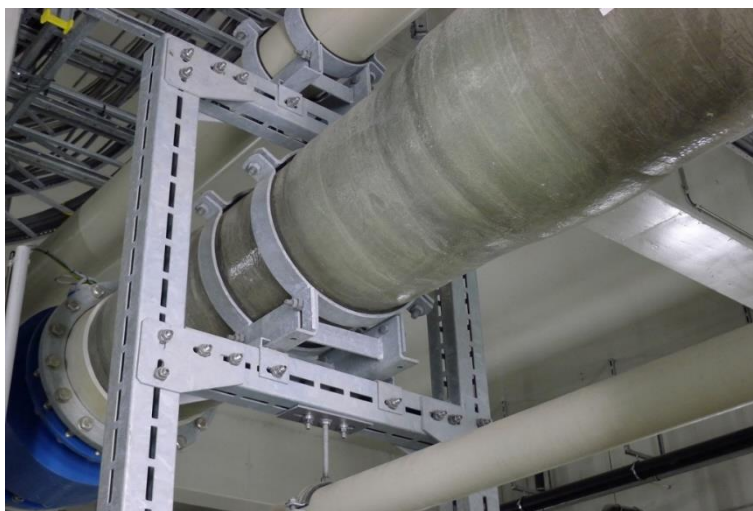
Figura 19 Supporto con guida
