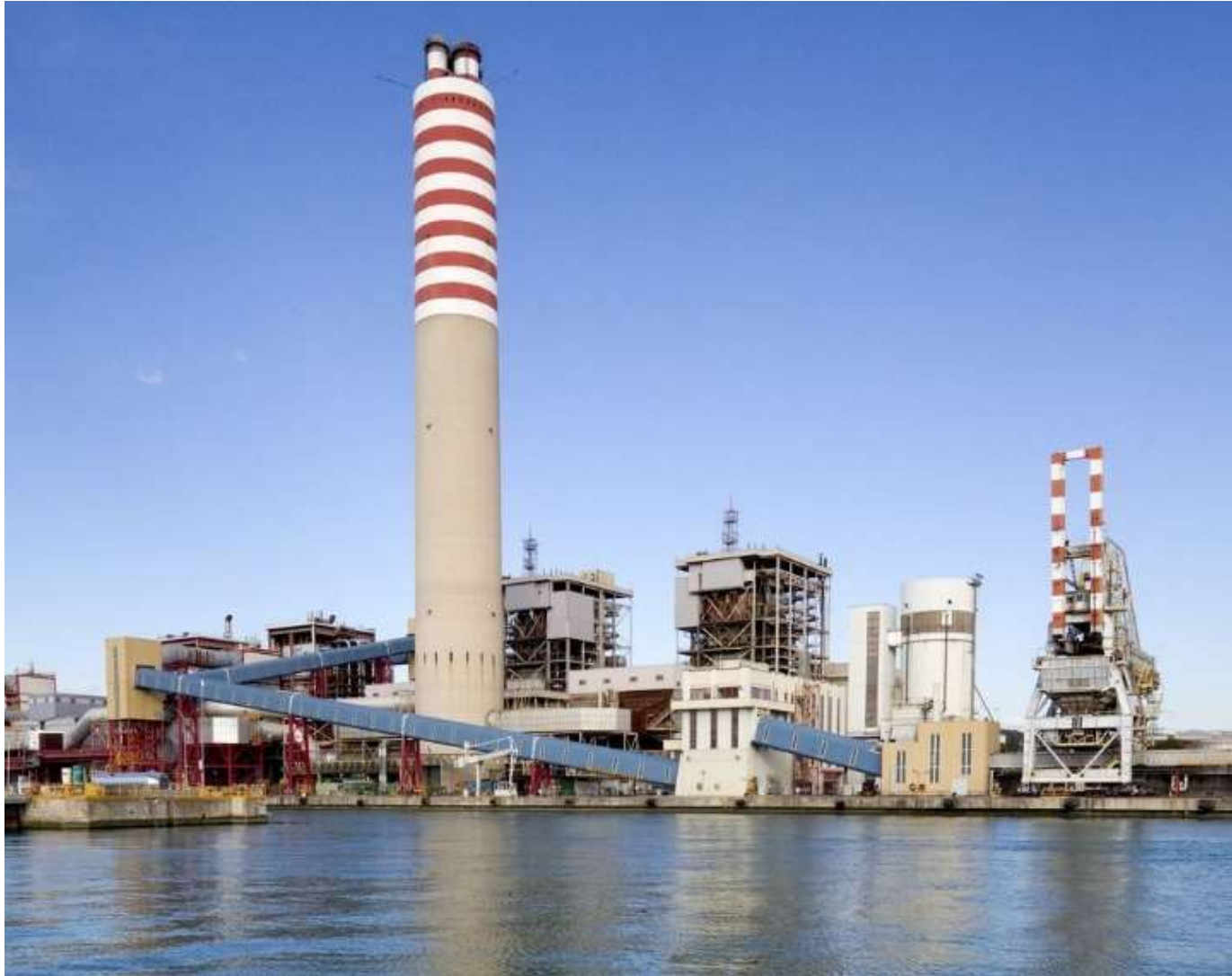
Centrale termoelettrica di Monfalcone
