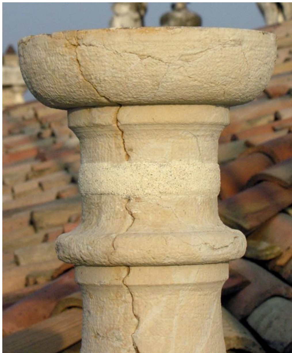
Figura 14 • Nastro in fibra di carbonio dopo la stesura della malta di finitura (calce naturale e inerti di calcare ammonitico, dimensioni > 0,1-0,2 mm).
