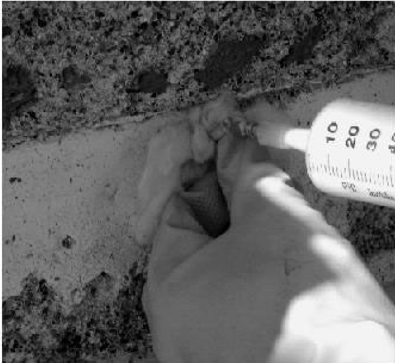
Figura 6 • Iniezione del consolidante (osservare l'impiego di batuffoli di ovatta per evitare perdite e colature).
