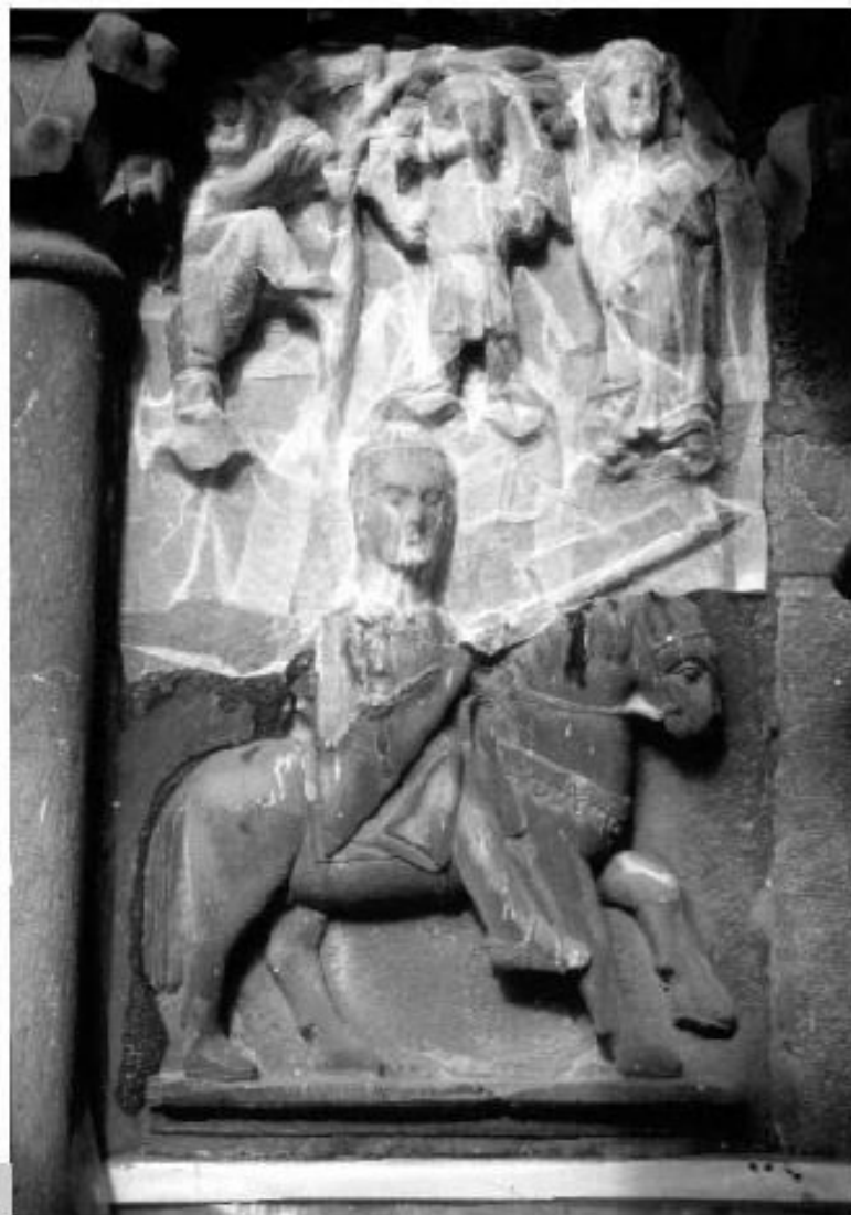
Figura 2 • Sulla superficie lapidea decoesa ed esfoliata si esegue una velinatura con fogli di carta giapponese per proteggerla sia dal contatto diretto del pennello con il quale è applicato il prodotto consolidante, sia dal particolato atmosferico e dalle polveri che potrebbero aggredire la superficie a impregnazione avvenuta.
