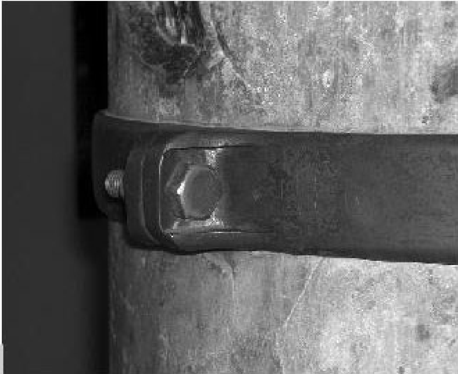
Figura 9 • Particolare di una cerchiatura in lega di rame.
