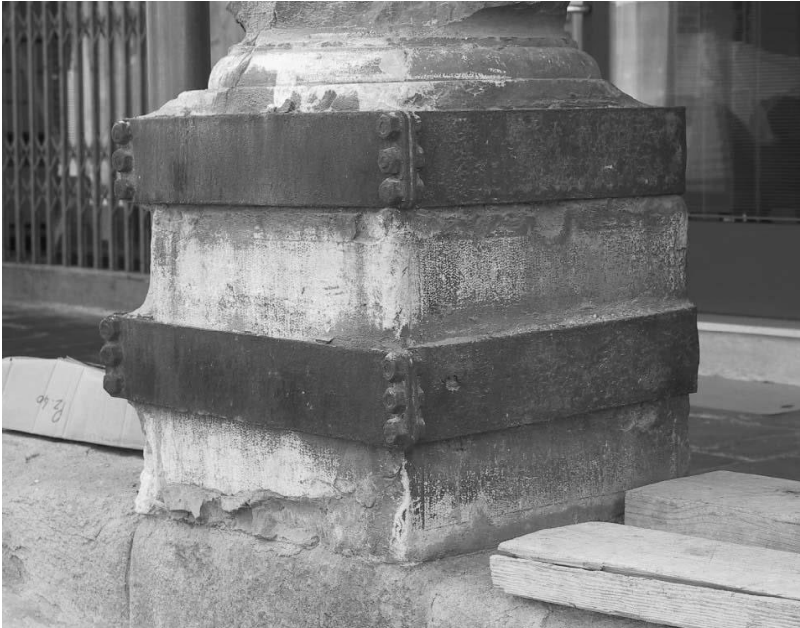
Figura 6 • Pesanti cerchiature al piedistallo di una colonna.
