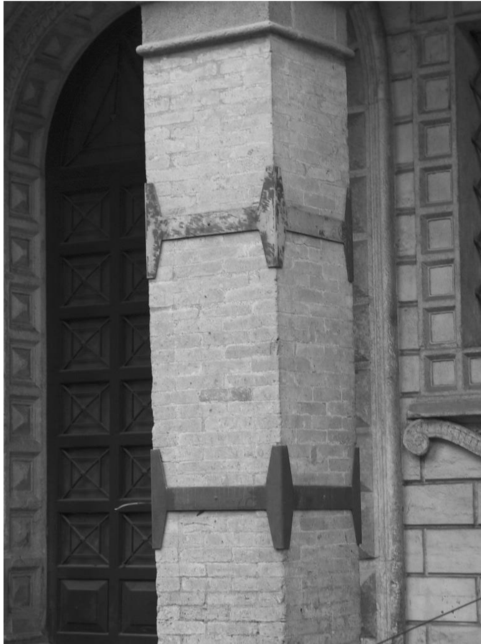
Figura 7 • Cerchiatura con rinforzi angolari di un pilastro di mattoni.
