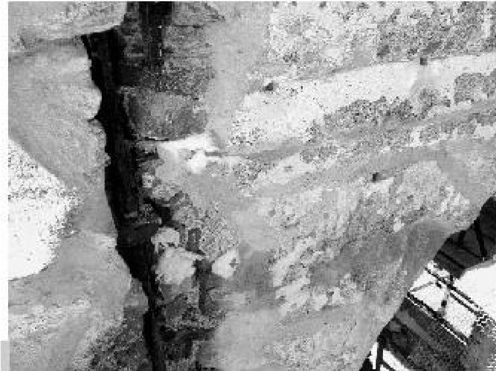
Figura 2 • La superficie muraria dopo l'esecuzione dei fori di iniezione e l'occlusione, con batuffoli di cotone, delle possibili vie di fuga del consolidante.
