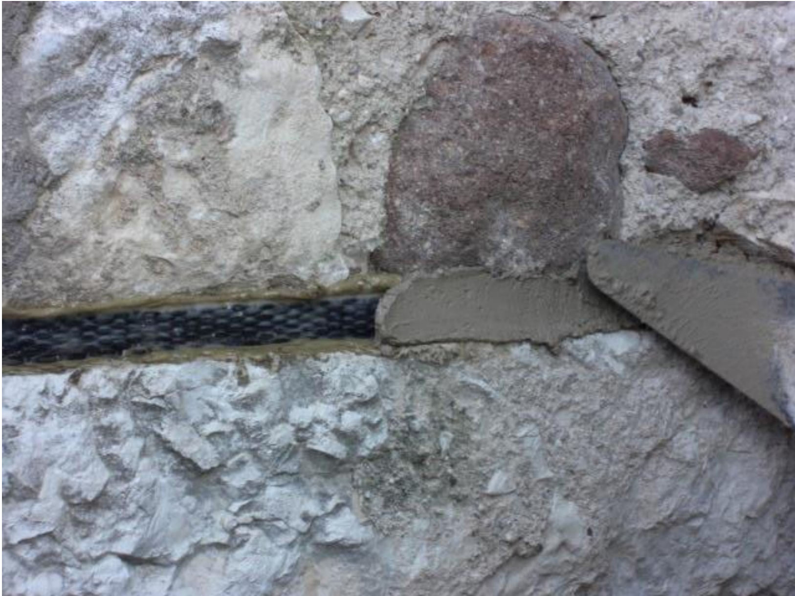
Figura 16e • Fasciatura inserita nei giunti di malta. Finitura dell'intervento con malta di calce idraulica naturale.
