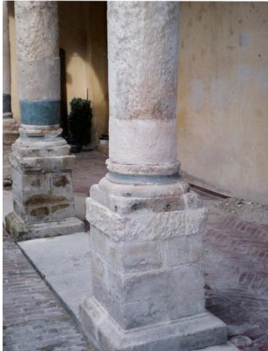
Figura 15 • Fasciature applicate alla base delle colonne. Nella colonna in primo piano è visibile la finitura con malta (calce naturale e inerti ricavati dalla frantumazione del medesimo litotipo della colonna).
