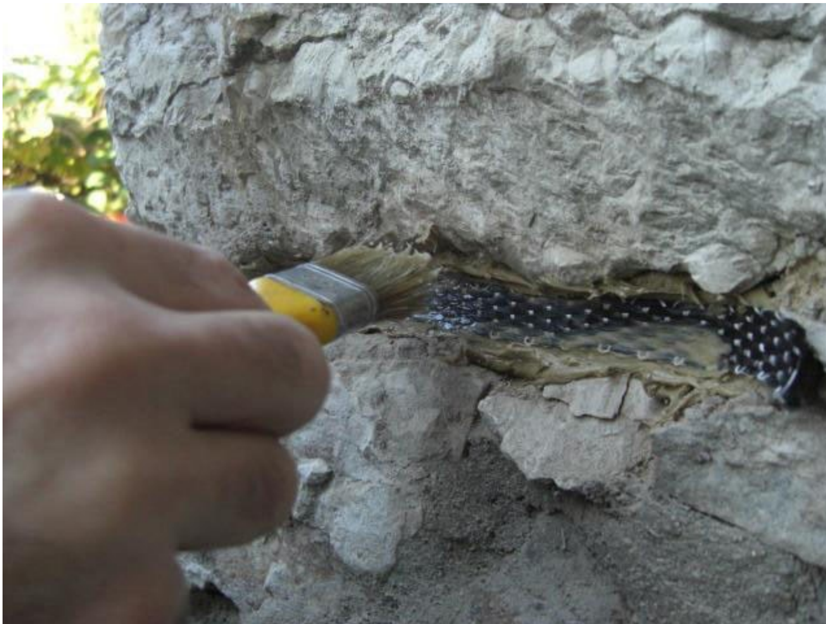
Figura 16d • Fasciatura inserita nei giunti di malta. Saturazione dei nastri in fibra in carbonio con resina epossidica fluida.
