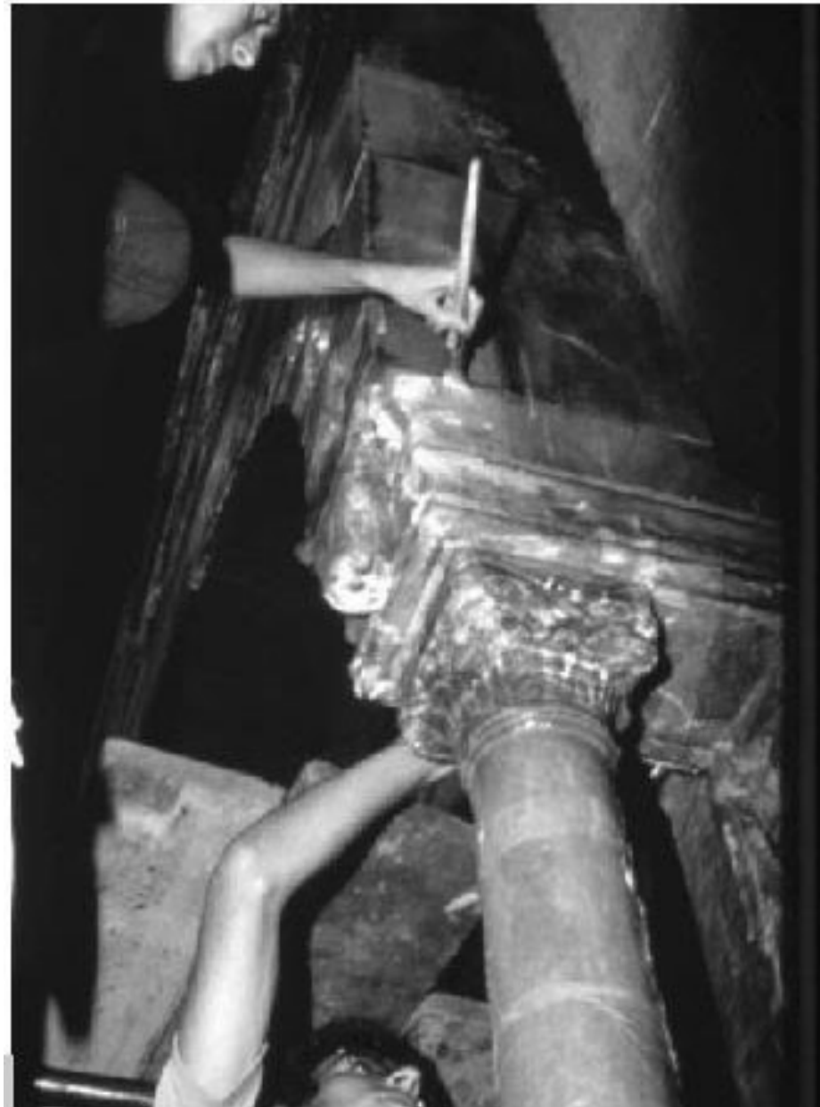
Figura 3 • Applicazione della velinatura.
