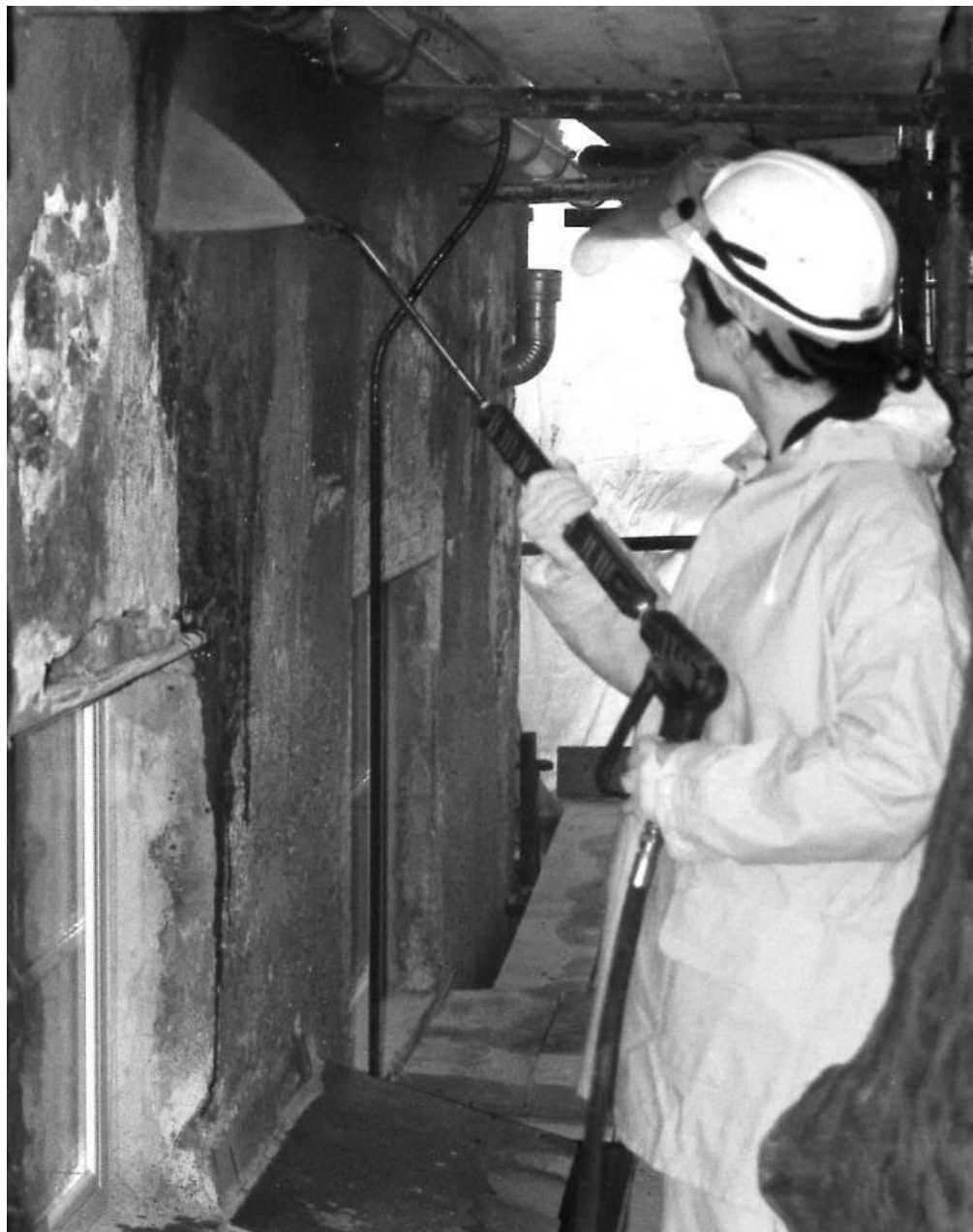
Figura 11 • Operatore durante il consolidamento.
