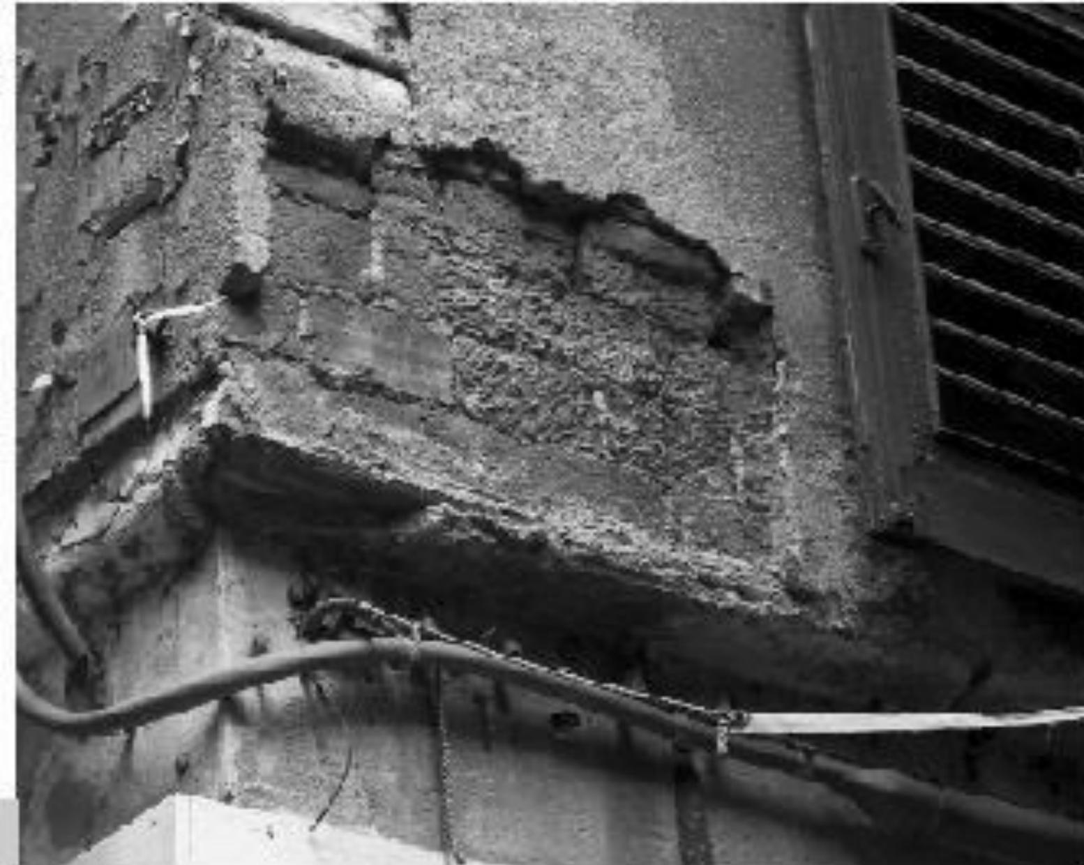
Figura 1 • Perdita di un tratto d'intonaco della facciata.
