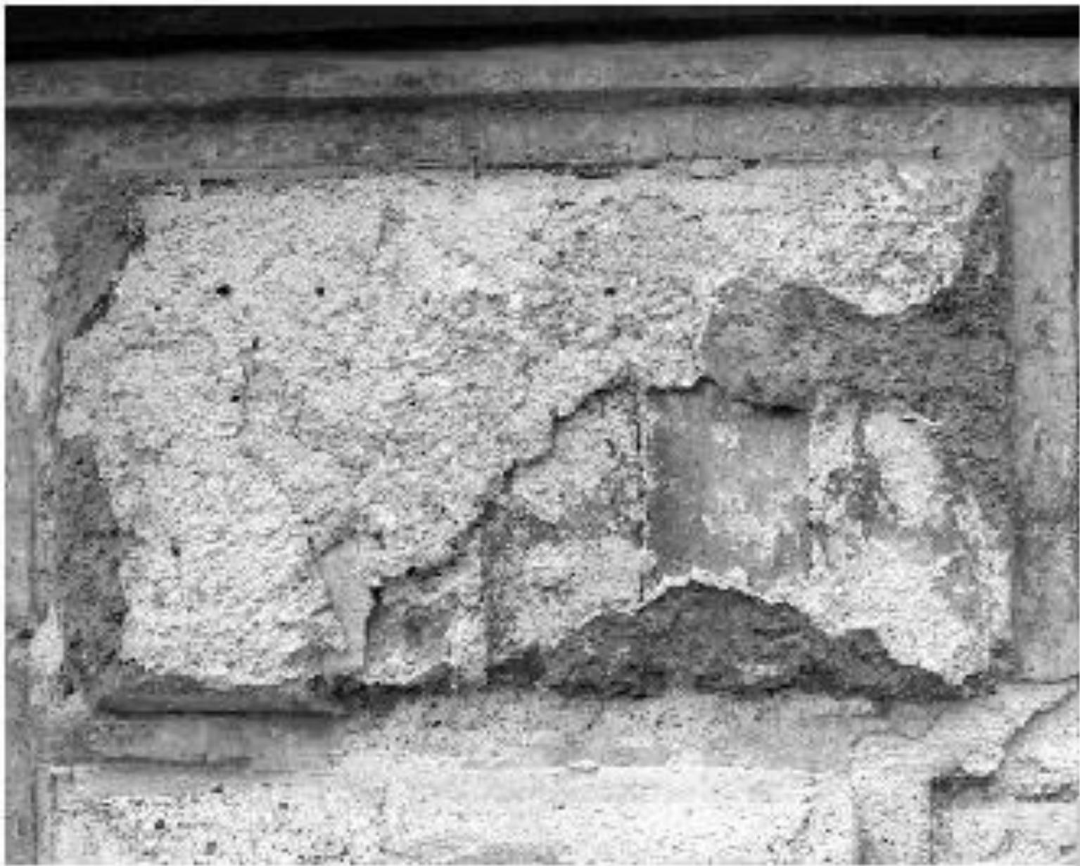
Figura 2 • Distacco degli strati d'intonaco da una bugna realizzata con malta.
