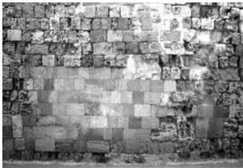
Figura 6 • Parete sulla quale è stata applicata la tecnica del cuci -scuci, mantenendo la nuova muratura a un livello di paramento arretrato rispetto a quello preesistente.
