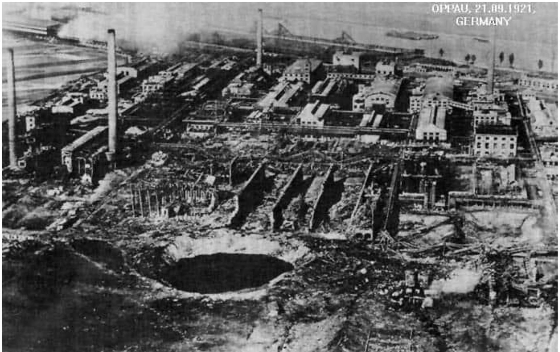
Esplosione di 4500 t di una miscela di solfato e nitrato di ammonio in un silos del primo impianto BASF di produzione industriale di ammoniaca: almeno 500 morti.
