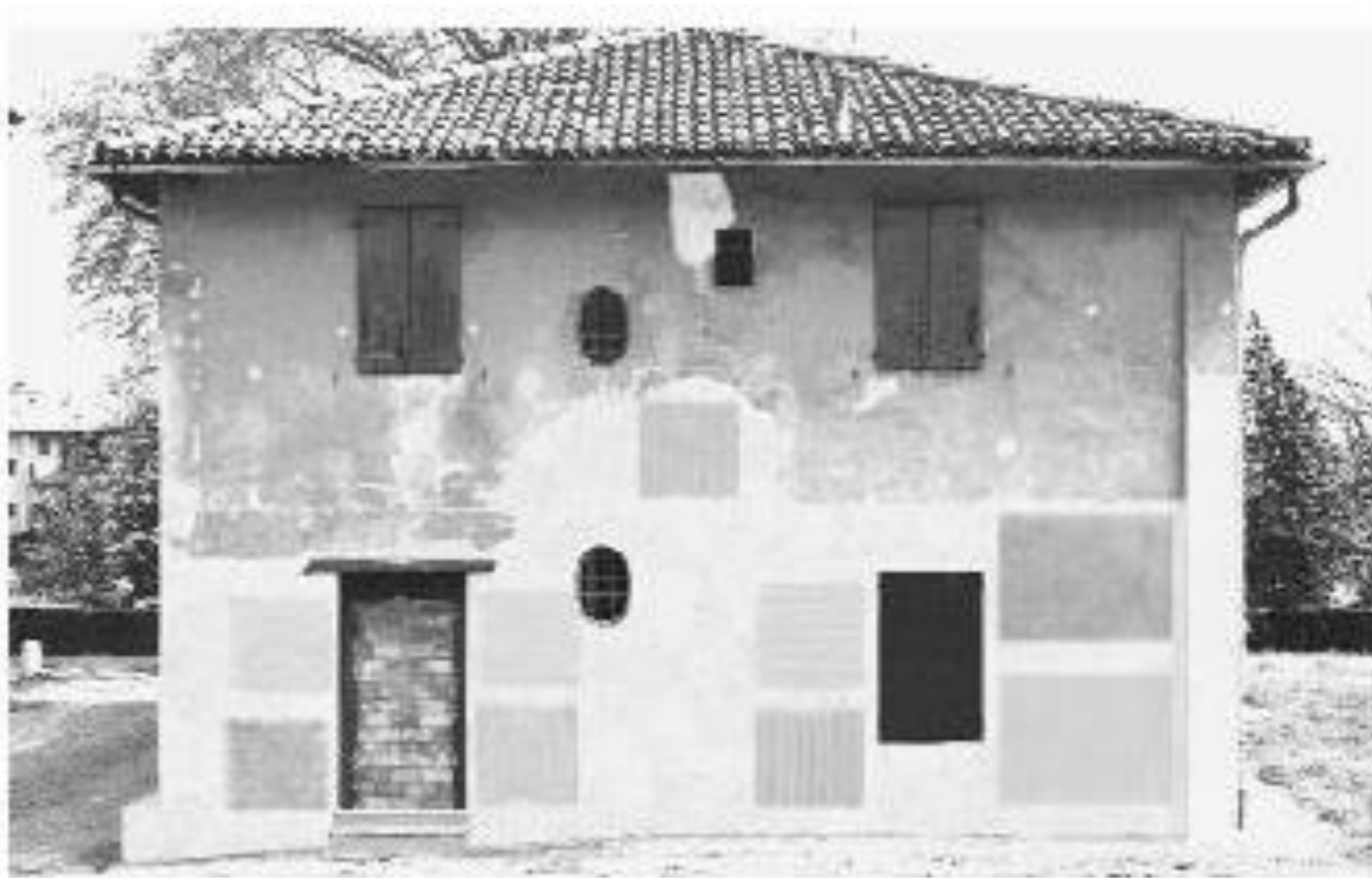
Figura 2 • Campionature di pitturazioni e velature di diverso colore e grado di trasparenza, realizzate sul nuovo intonaco. Nella parte centrale della facciata è riportato il campione di velatura scelto per le successive elaborazioni.
