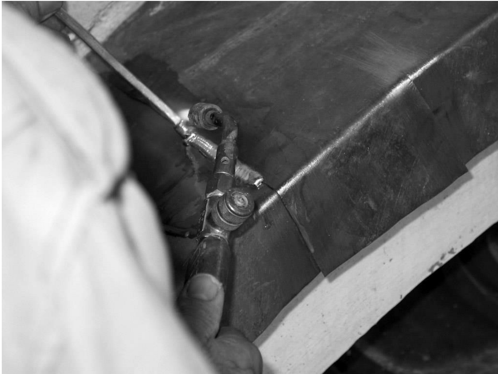
Figura 16 • Saldatura con cannello di stagno.
