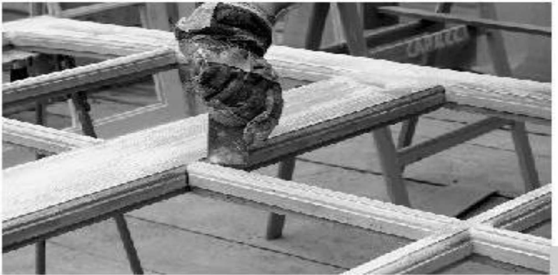
Figura 4 • Pulitura con raschietto.
