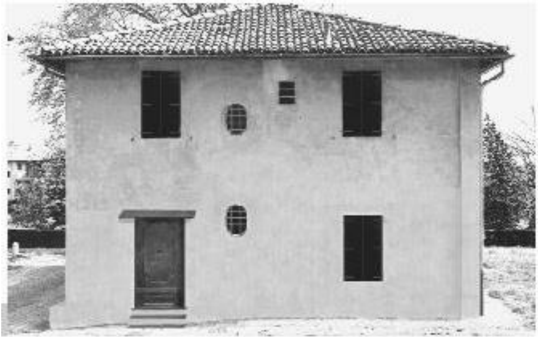
Figura 3 • Velatura del nuovo intonaco e dei vari rappezi con uno dei campioni di velatura realizzato nella fase precedente.
