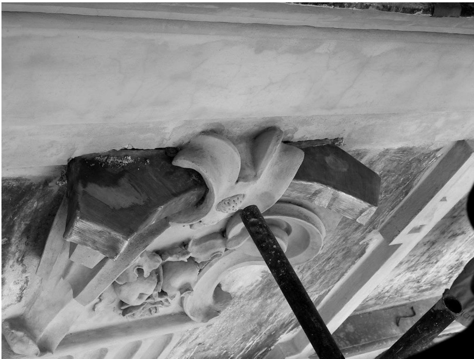
Figura 20 • Protezione di un capitello in stucco ottenuta tramite rivestimento dell'abaco con una lamina di piombo.
