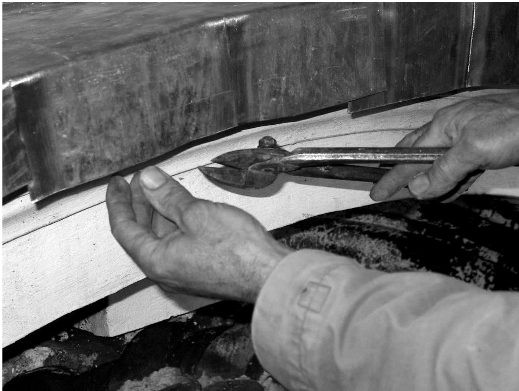
Figura 12 • Taglio con cesoie del materiale in eccesso.
