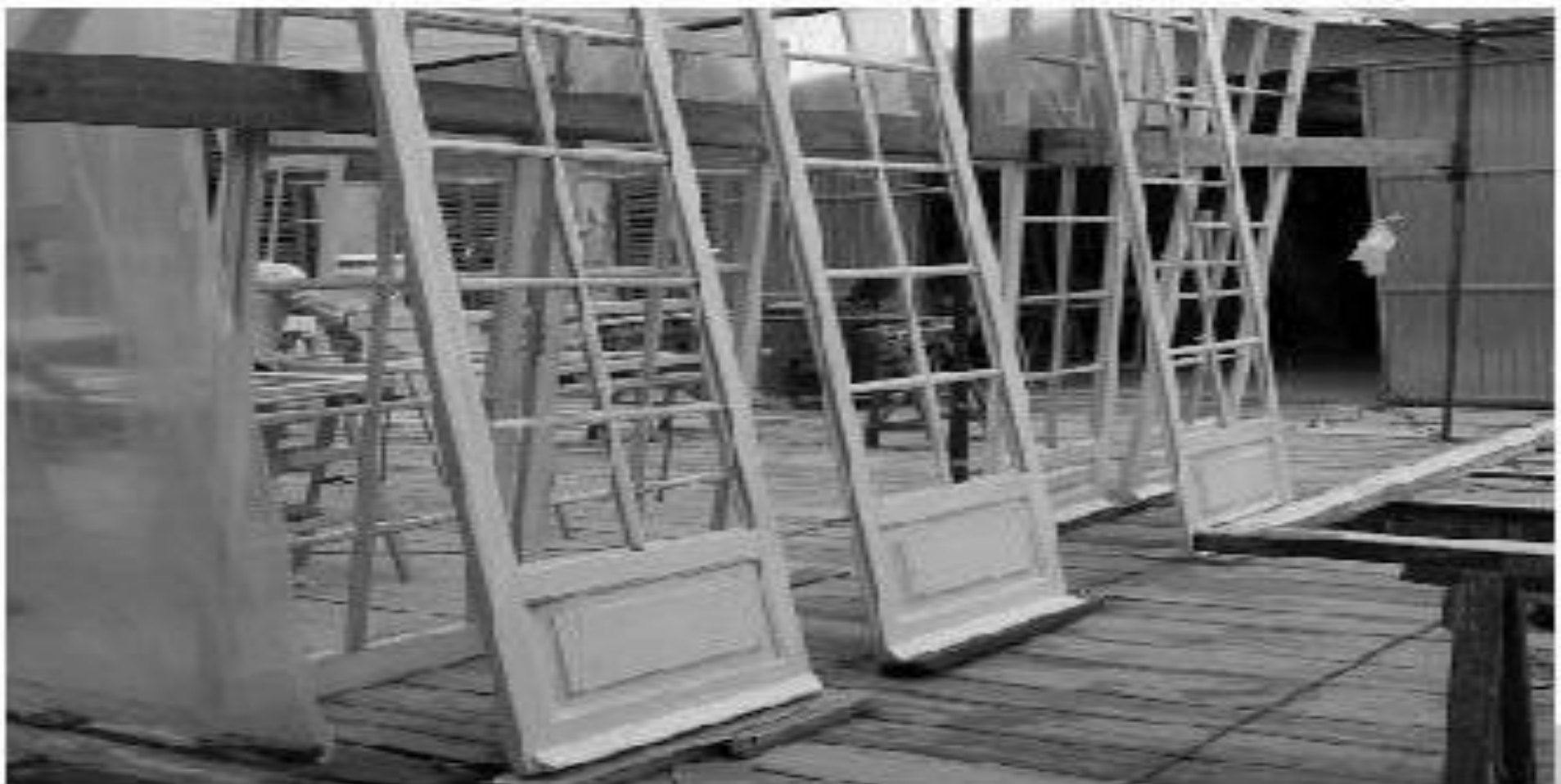
Figura 6 • Asciugatura dopo l'applicazione degli strati di coloritura.
