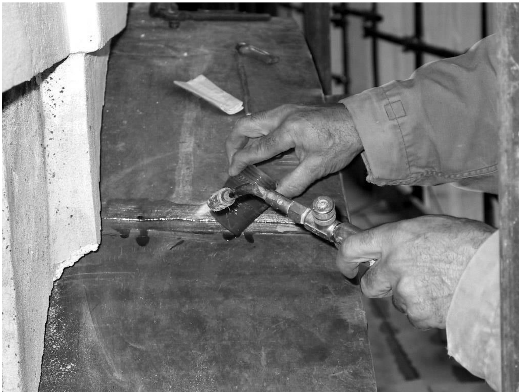
Figura 15 • Riscaldamento dei lembi da saldare e preparazione delle superfici con applicazione di stearina.
