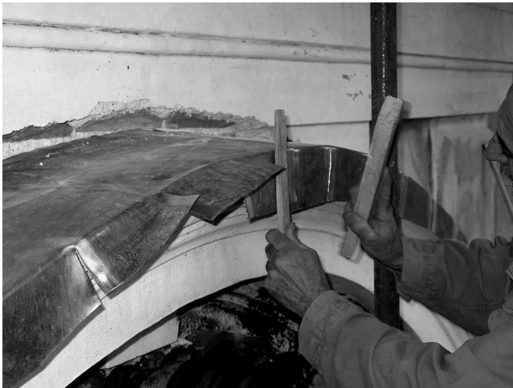
Figura 9 • Ribattitura del foglio di piombo mediante due assicelle di legno.
