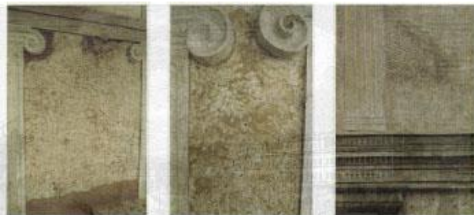
1 - ROMA, VILLA LANTE AL GIANICOLO - MOTIVO DI ELIMINAZIONE DEGLI INTONACI DEGLI ANNI '50 SUL LATO EST. Si vede un profilo architettonico
