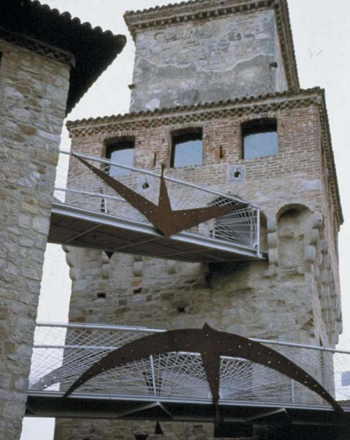
Vigoleno (PC, 1999), Castello degli Scotti: le due nuove passerelle aeree
