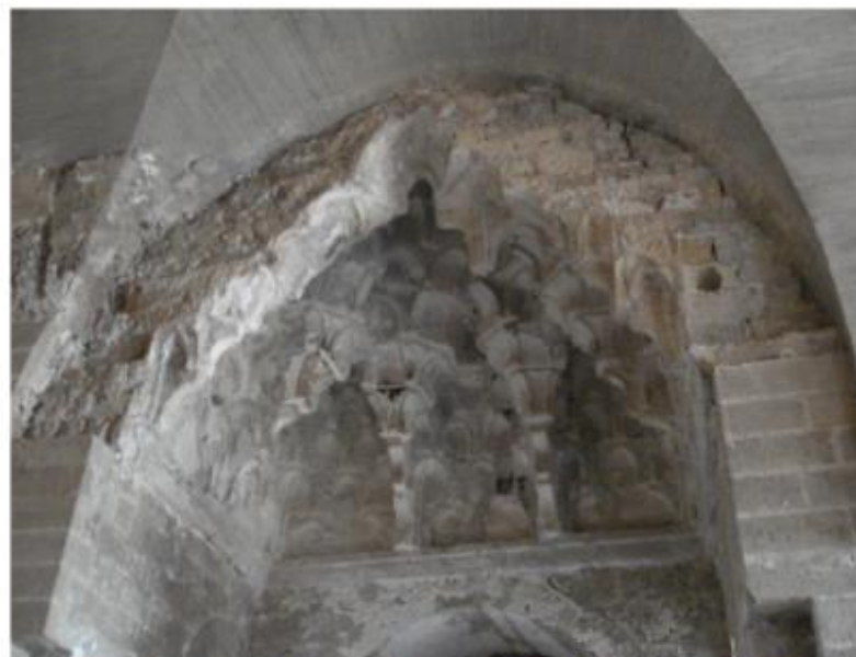
Particolare della murquana , e della ricostruzione della volta in cemento armato.
