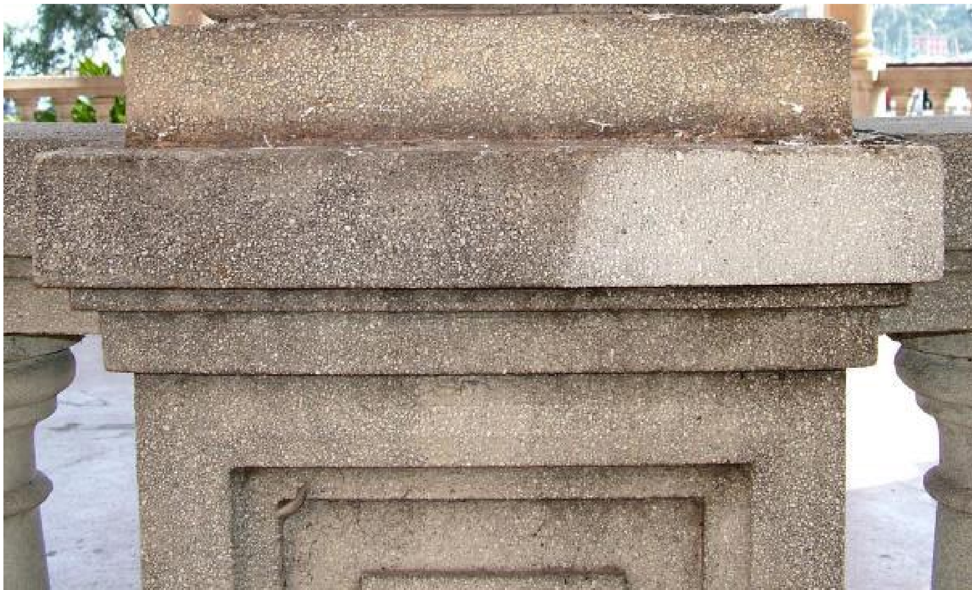
Figura 7 • Saggio di pulitura reale della superficie in pietra artificiale.
