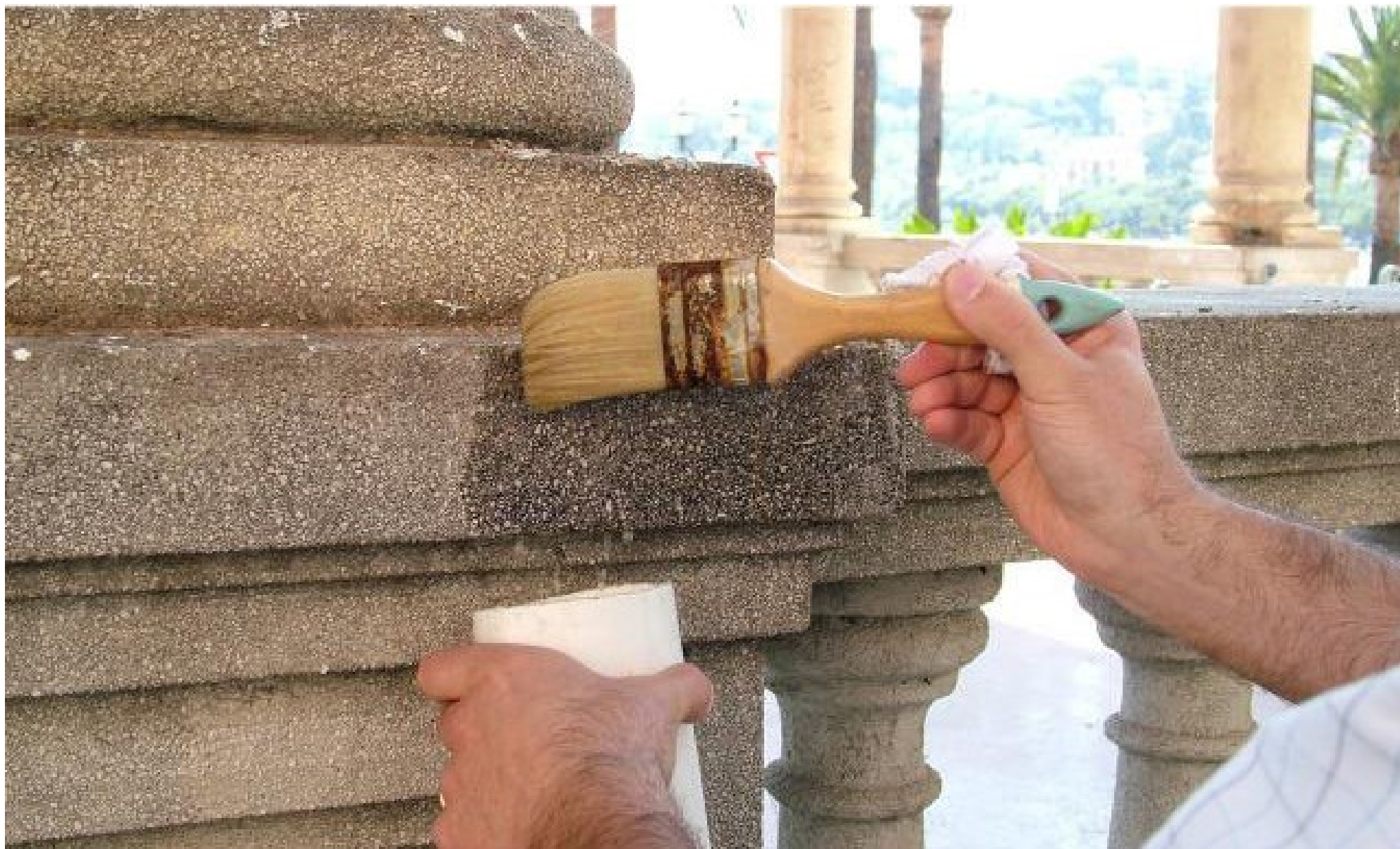
Figura 6 • Fase di esecuzione della pulitura di un basamento in pietra artificiale.
