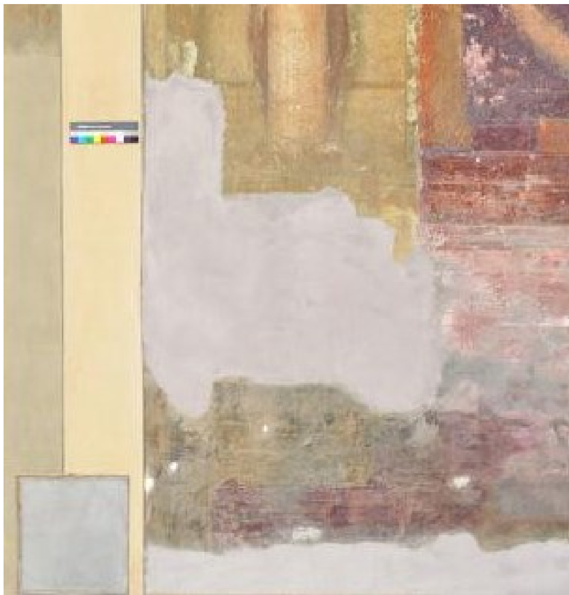
Figura 1c • Integrazione reale della lacuna effettuata con il medesimo intonaco del campione utilizzato nella simulazione. Come si può verificare confrontando le due immagini, la simulazione della integrazione è sufficientemente “realistica”.
