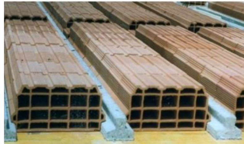
Solai a travetti in precompresso
