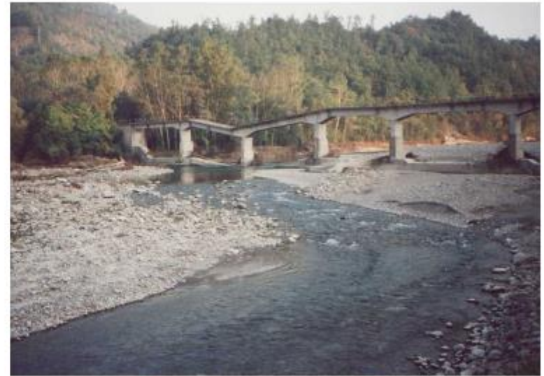
Figura 2 – Esempi di crolli di attraversamenti dovuti fenomeni di erosione localizzata alla base di una pila.
