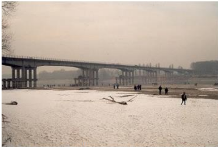
Figura 3 – Esempio di abbassamento d'alveo per erosione generalizzata. Ponte sul Fiume Po a Boretto.
