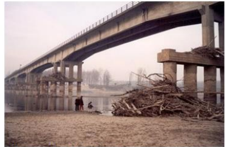
Figura 3 – Esempio di abbassamento d'alveo per erosione generalizzata. Ponte sul Fiume Po a Boretto.
