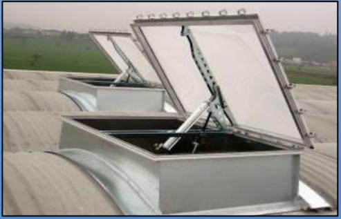
*Gli EFC devono essere installati, per quanto possibile, in modo omogeneo nei singoli compartimenti, a soffitto in ragione, ad esempio, di uno ogni 200 m<sup>2</sup> (su coperture piane o con pendenza minore del 20 %) come previsto dalla regola tecnica di progettazione costituita dalla norma UNI - VVF 9494*
