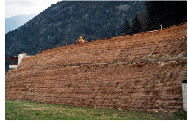
Le caratteristiche della terra rinforzata/armata **dipendono** dalla interazione tra il materiale di rinforzo e la terra a contatto, interazione che è legata alle caratteristiche dei materiali impiegati (terra e rinforzo) e alle modalità costruttive.
