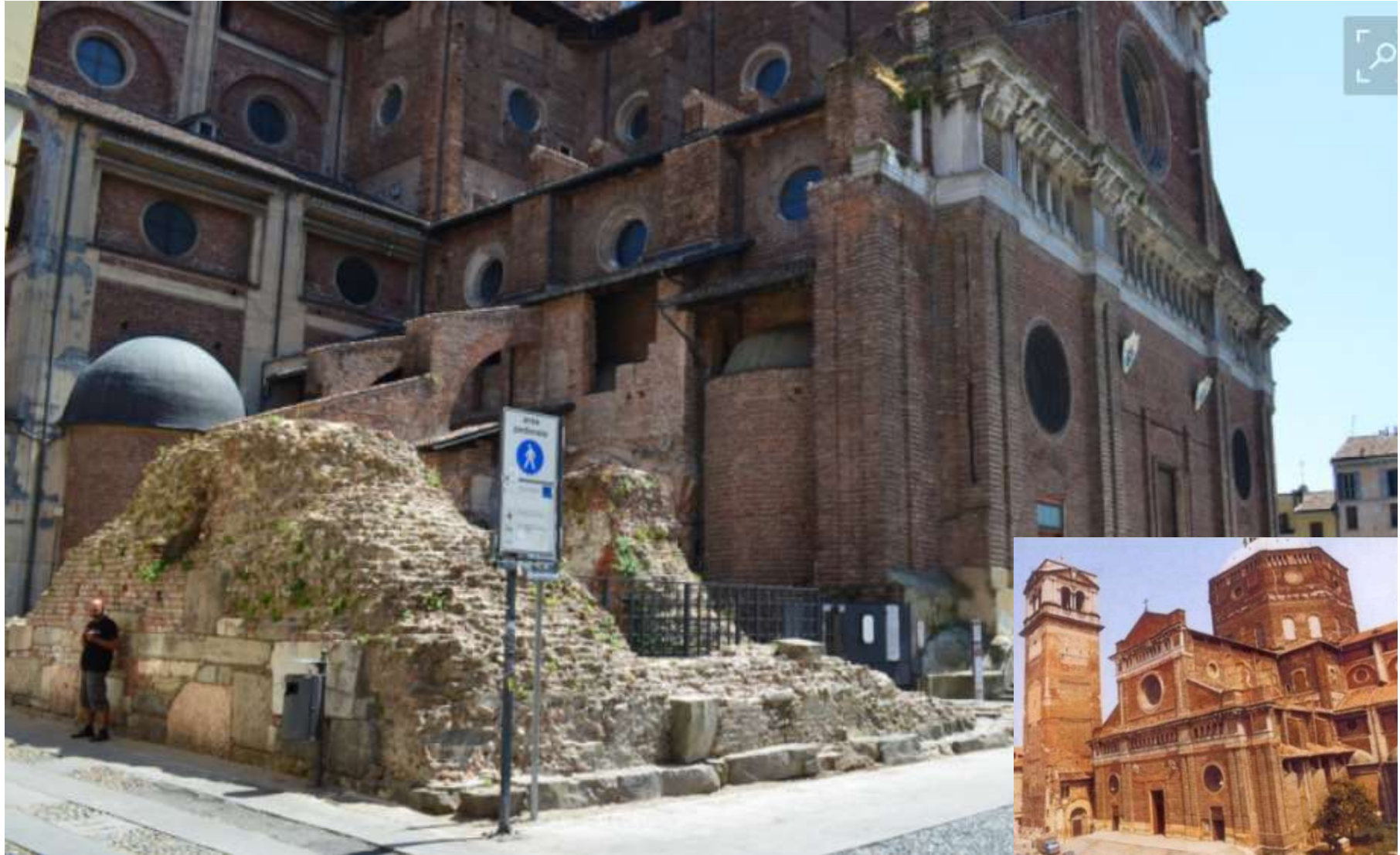
Crollo Torre Civica (marzo 1989)
