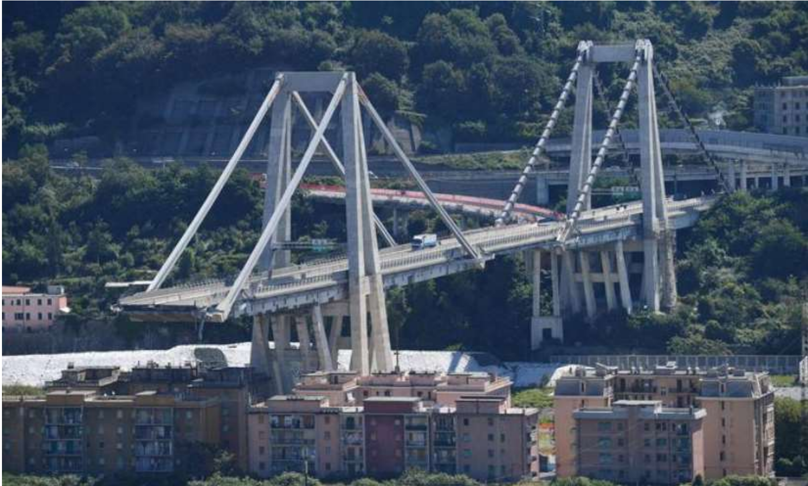
Viadotto sul Polcevera – Genova (ago. 2018)
