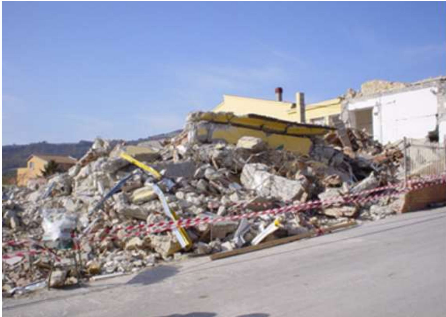
Crollo scuola Jovine ( ottobre 2002 ) – 28 morti
