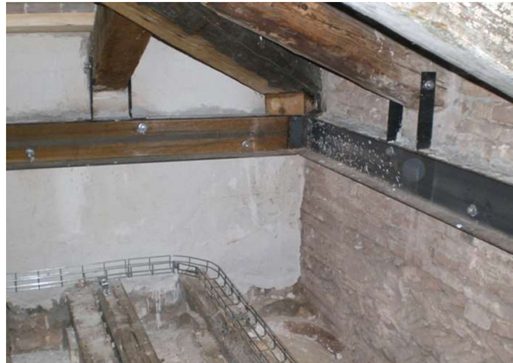
Legature orizzontali in profilati di acciaio spinottati.
