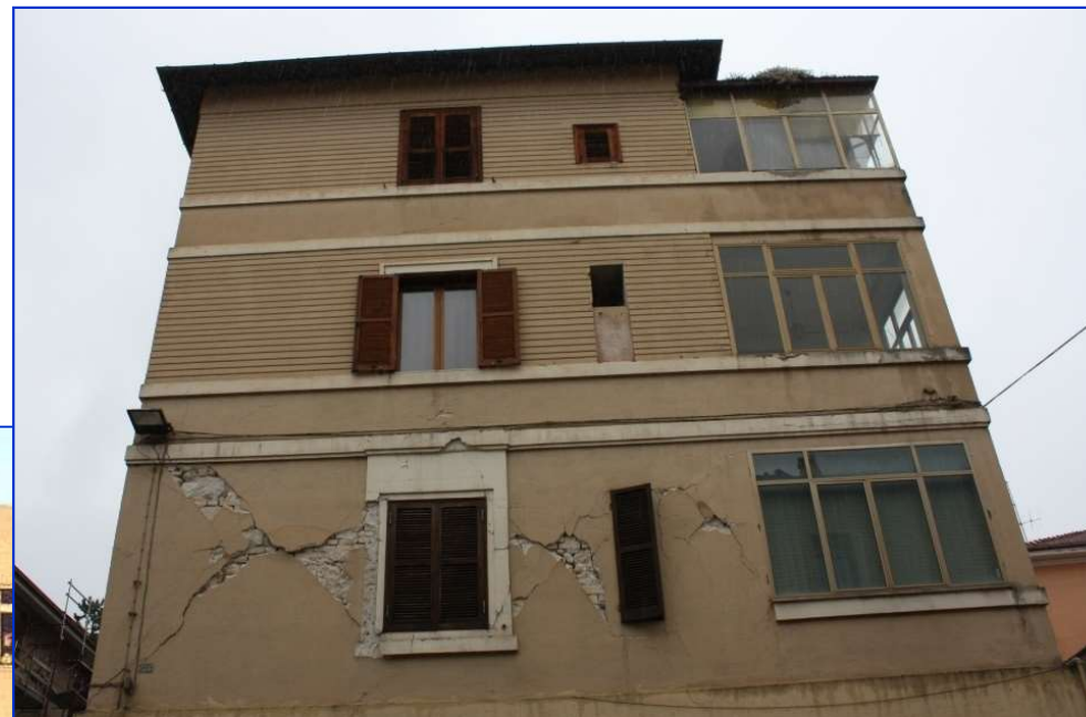
L'Aquila, 2009 Fessurazione diagonale maschi
