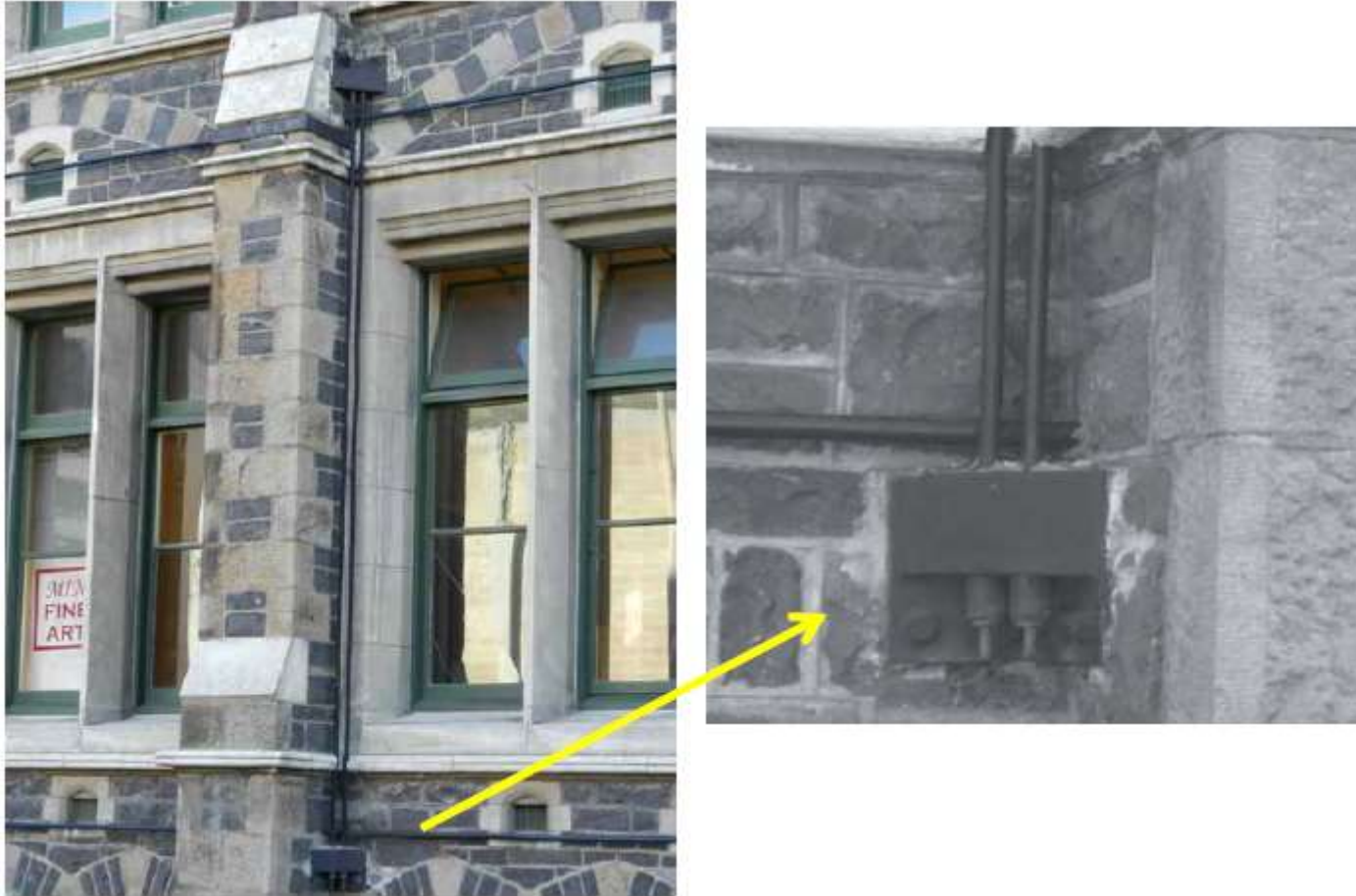
Particolari tirantature verticali e orizzontali post-tese
