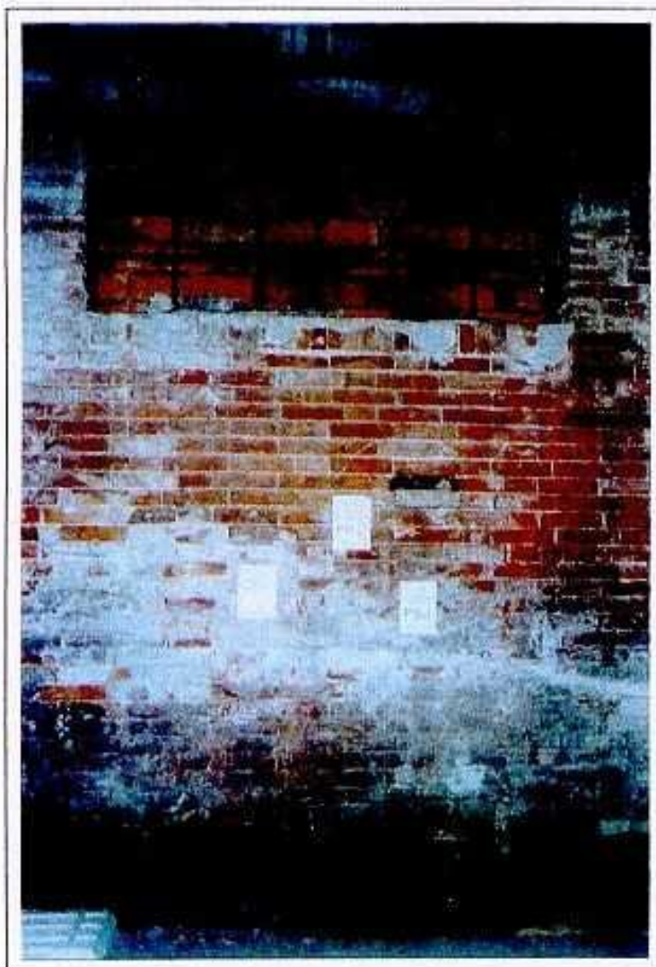
Foto 3: veduta della porzione muraria su cui è stato condotto il prelievo di campione di alettamento PA.2
