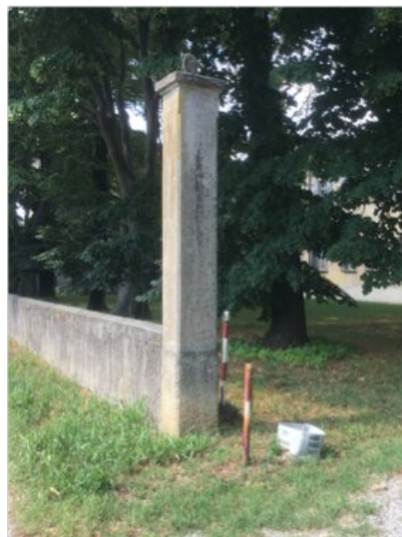
32 | RECINZIONI E CANCELLI Muro in cemento
