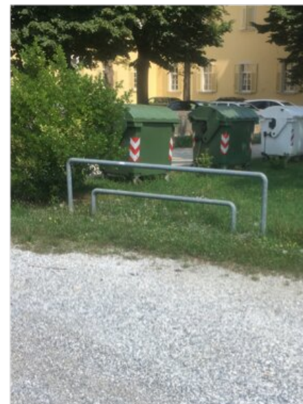
34 | RECINZIONI E CANCELLI Elemento divisore in ferro
