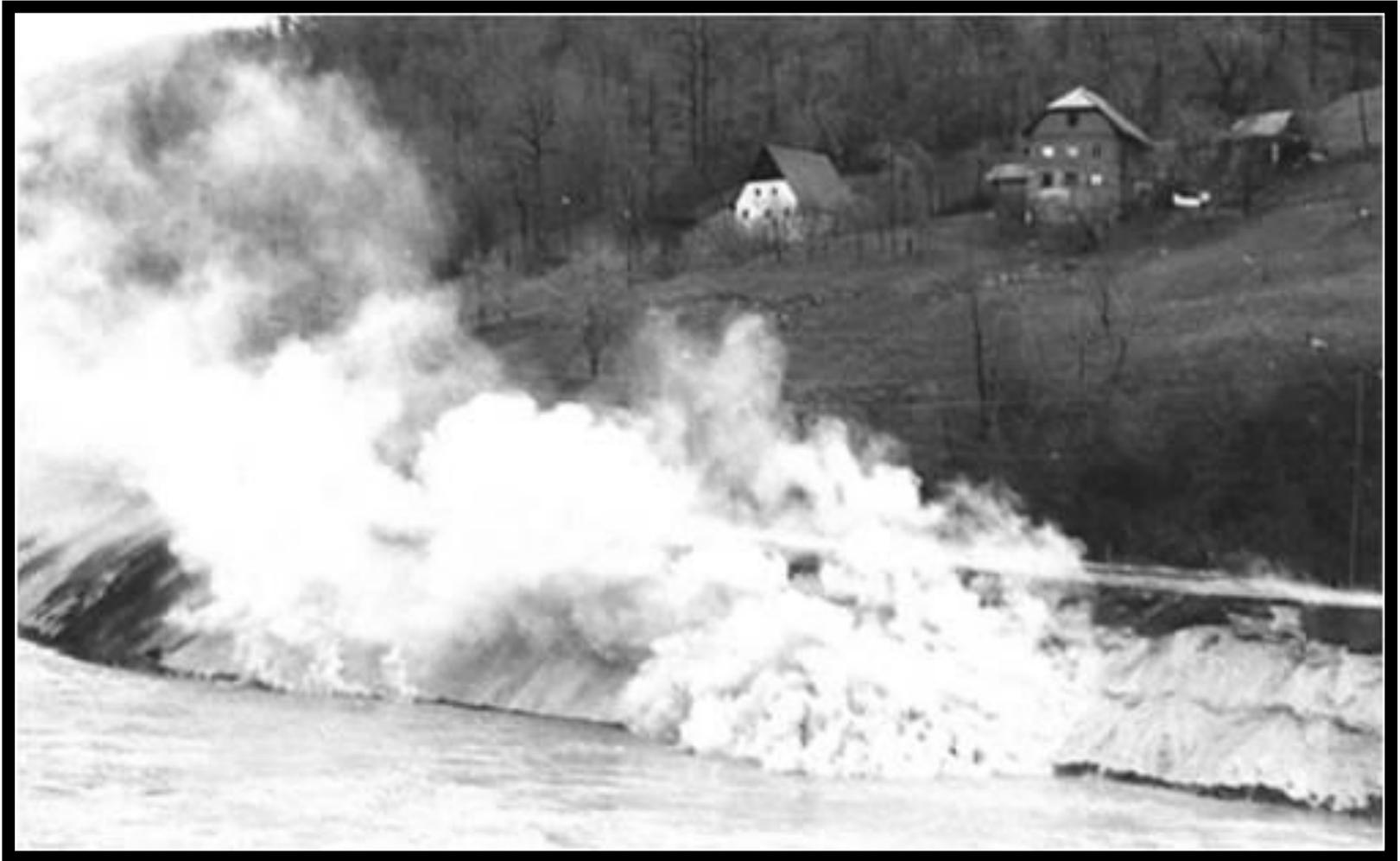
Nuove discariche di residui di minerale arrostito sono state create sulla riva destra del fiume Idrijca in diverse località (Čar 1998).
