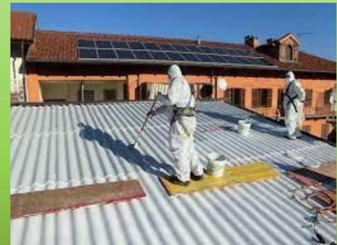
Il confinamento consiste nell'isolare il materiale contenente amianto mediante una barriera fisica, ad esempio una copertura o un rivestimento.
