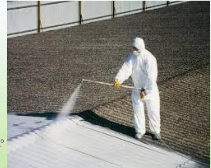
impregnare il materiale con l'uso di prodotti penetranti e ricoprenti, che permettono di inglobare le fibre di amianto e consente di costituire una pellicola di protezione sulla superficie esposta
