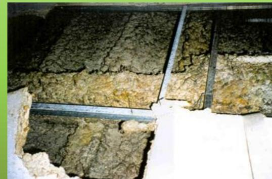
amianto spruzzato a soffitto visibile dopo rimozione di controsoffittature
