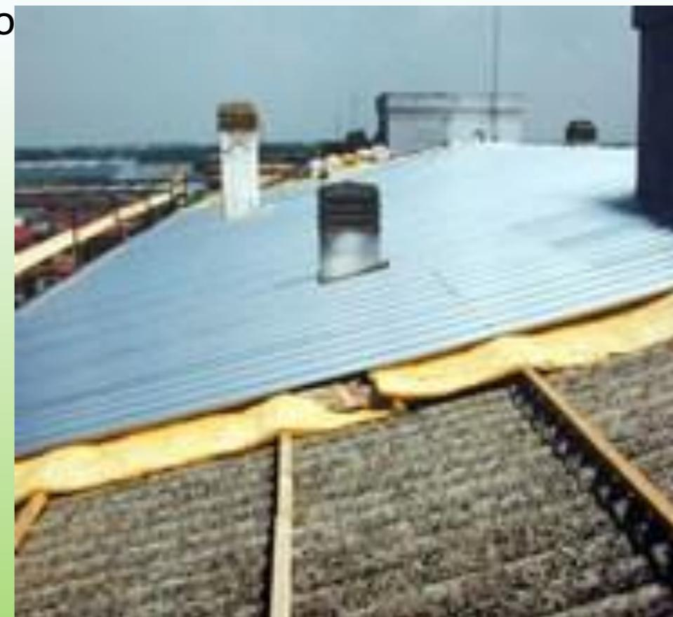
installare delle barriere in modo da isolare l'inquinante dall'ambiente. Per evitare che le fibre vengano rilasciate all'interno dell'area, il processo deve essere accompagnato da un trattamento incapsulante
